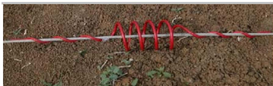
**Figura 197.** Swan Fligth Diverter colocado en un cable de línea de transmisión en la Reserva de Abbertton, Reino Unido. (Tomado de Frost 2008).
