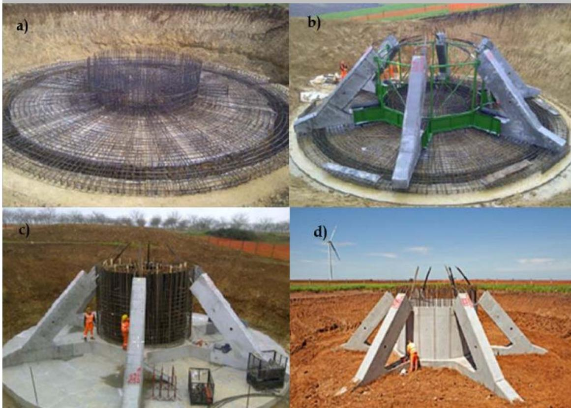
Figura 11. Procedimiento de cimentación de los aerogeneradores.
