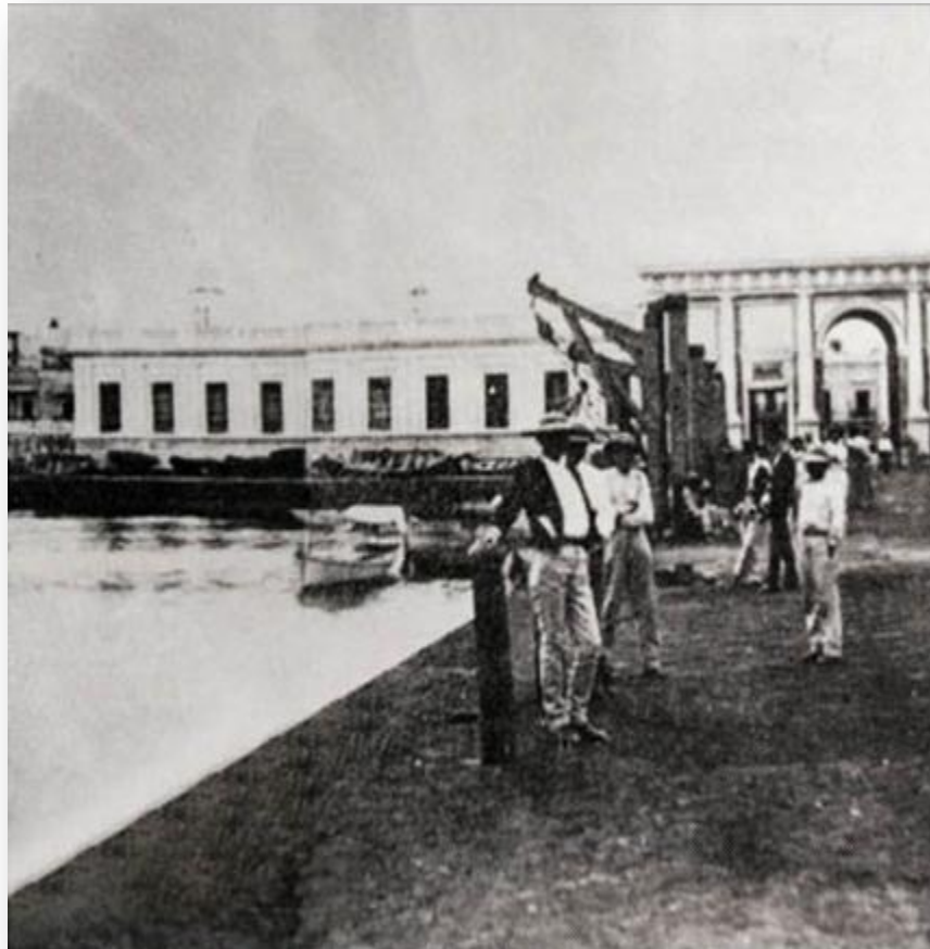
FIGURA 2 MALACATES DE MADERA EN EL MUELLE Y “PUERTA DE LA ADUANA” EN EL SIGLO XIX
