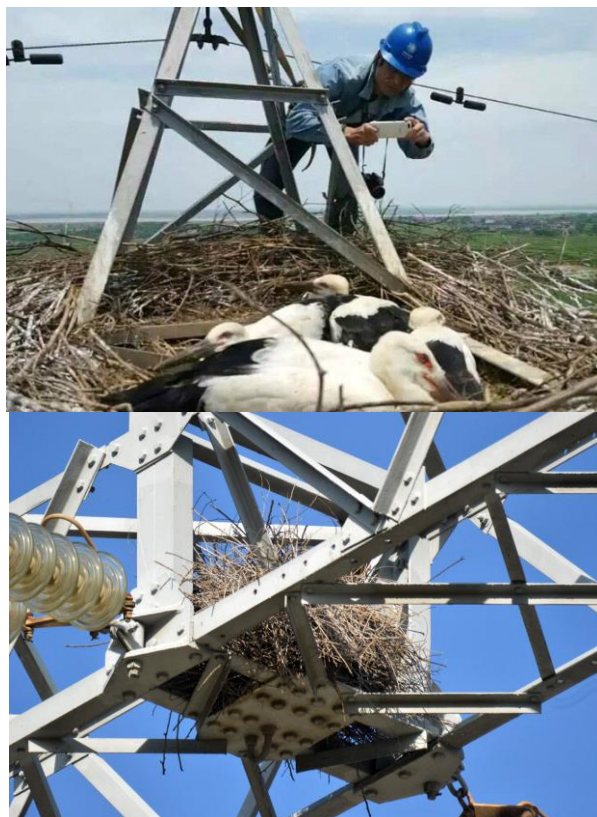
Figura 5. Mantenimiento y retiro de nidos en subestación y tendido eléctrico
