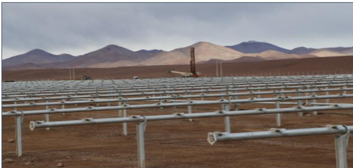
Figura 5. Ejemplo de instalación de tubos de rotación.
