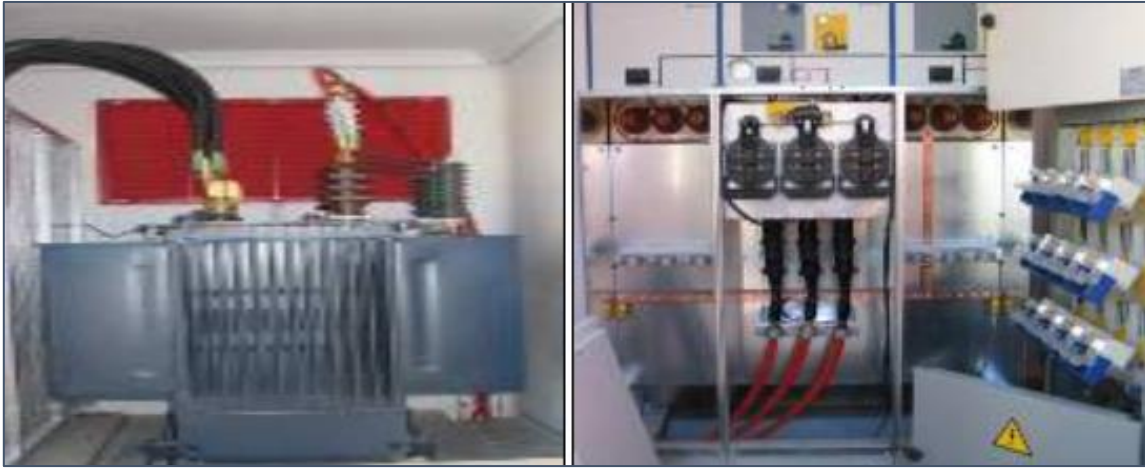
Figura 10. Ejemplo de transformador y media tensión.
