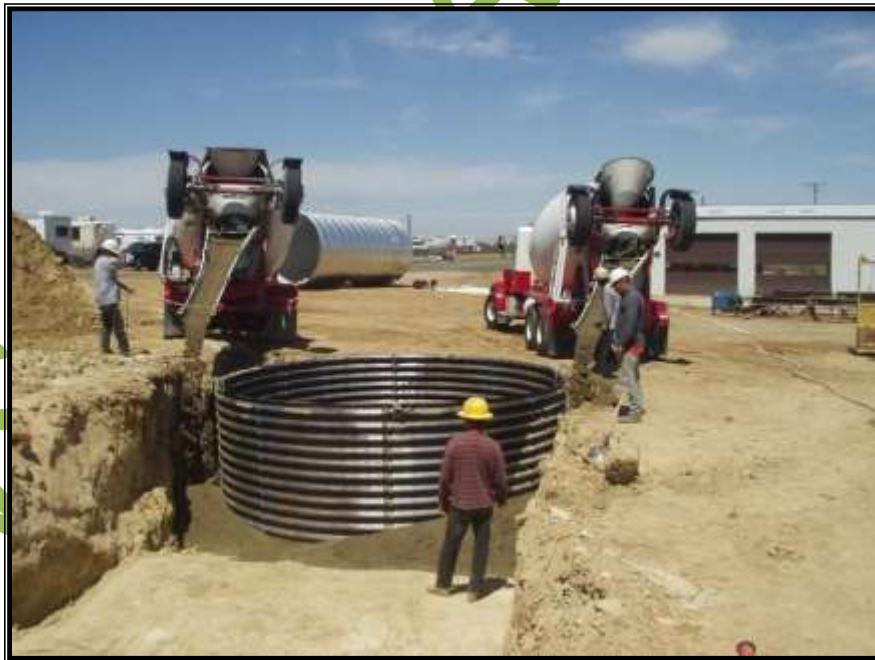
Figura II.5. Ejemplo de la instalación de un cimiento de pilar.
