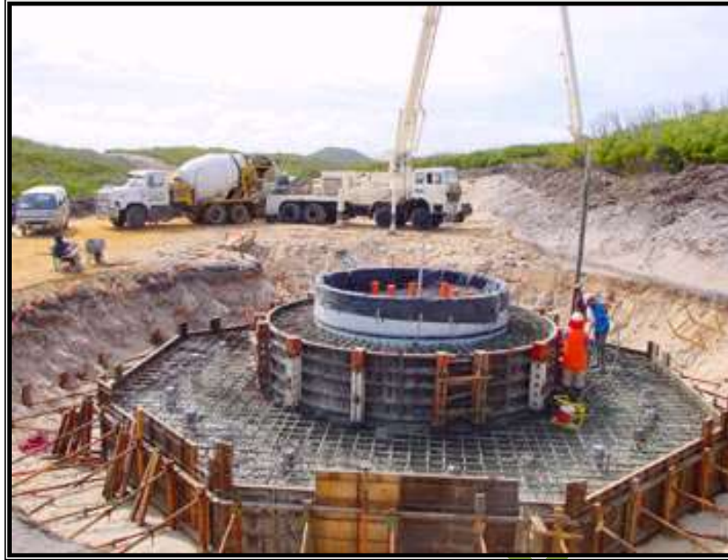
Figura II.4. Ejemplo de la instalación de un cimiento de tapete.
