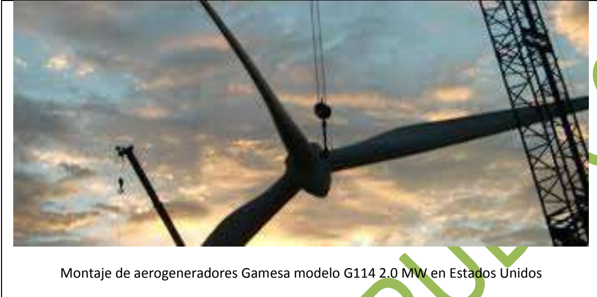
Figura II.6. Ejemplos de montaje de aerogeneradores Gamesa
