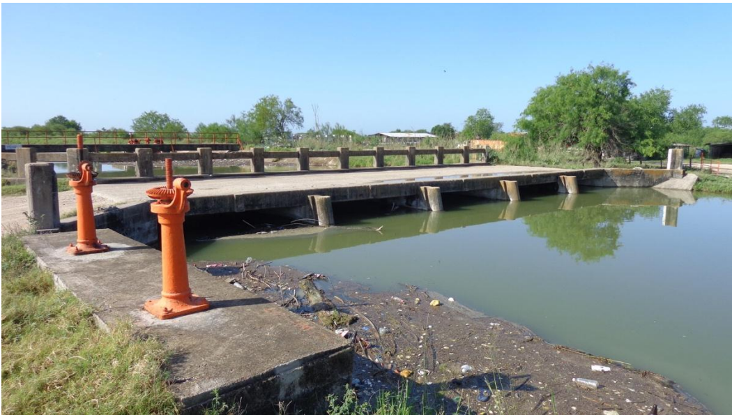
Figura 4.59. Canal Principal Guillermo Rodhe en el Noreste del sitio de proyecto.
