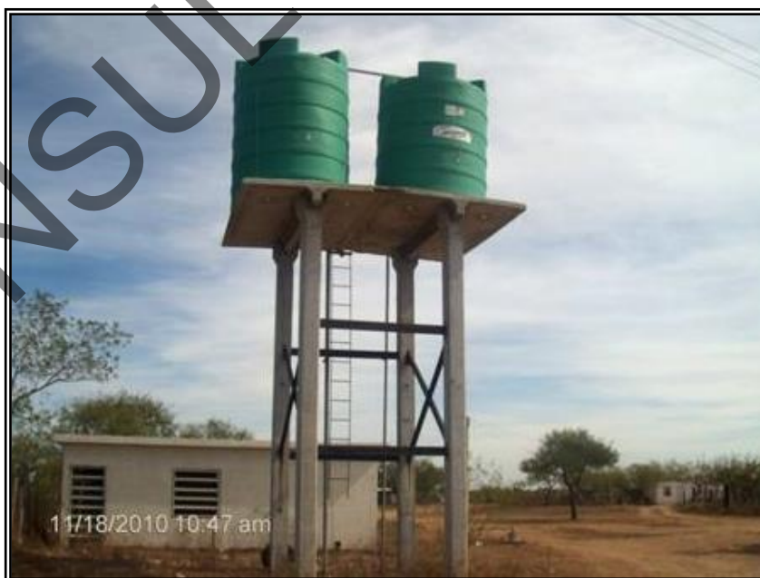
Fotografía IV.2.4-3.- Tanques elevados para suministrar agua potable.
