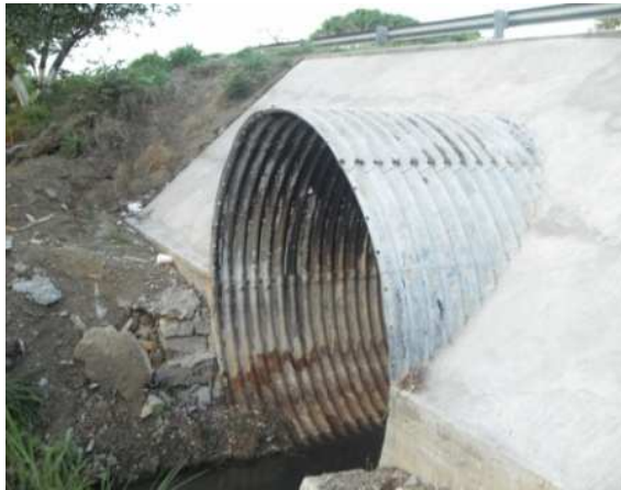
Figura II.22 Alcantarilla de lámina corrugada de acero.
