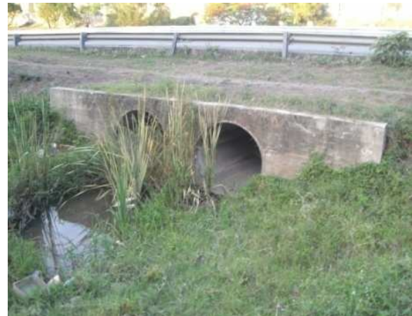
Figura II.23 Alcantarilla de doble tubo de concreto.
