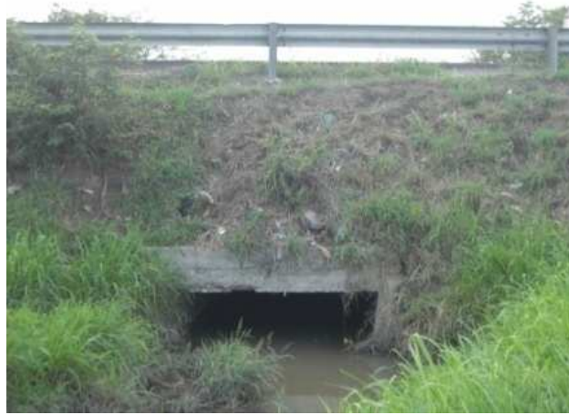
Figura II.24 Alcantarilla de losa
