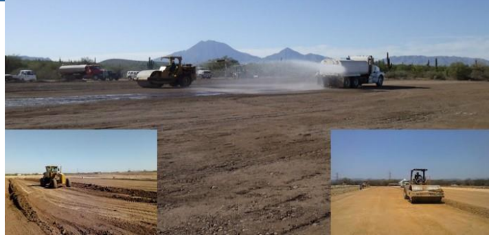
Figura.II.107. Se ilustra las actividades para la conformación de plataforma con material de banco
