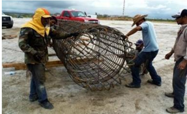
Figura.II.100. Habilitado de acero de refuerzo.
