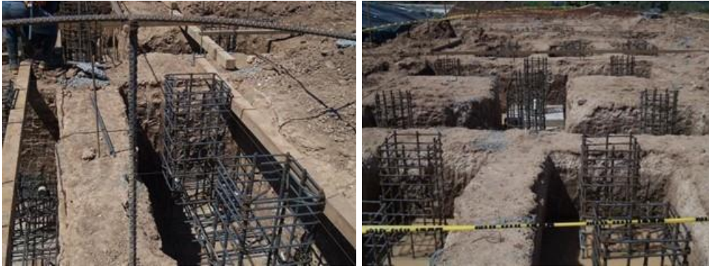
Figura.II.109. Ilustración gráfica del acero de refuerzo.
