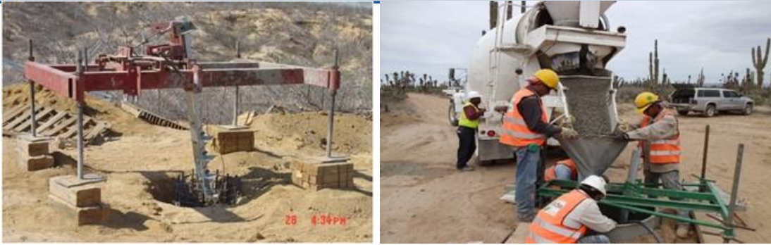
Figura.II.73. Proceso de cimentación.
