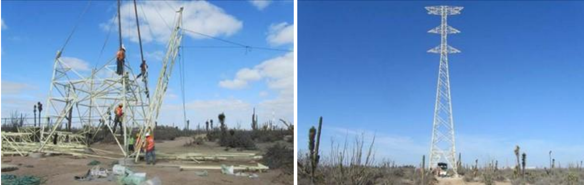
Figura.II.48. Armado, nivelado y montaje de estructuras.
