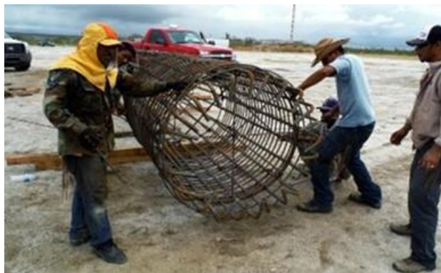
Figura.II.89. Habilitado de acero de refuerzo.
