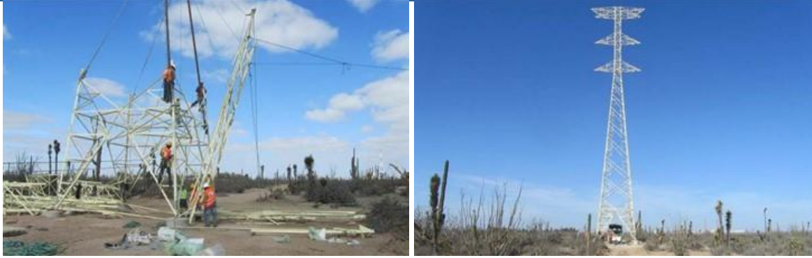
Figura.II.66. Armado, nivelado y montaje de estructuras.
