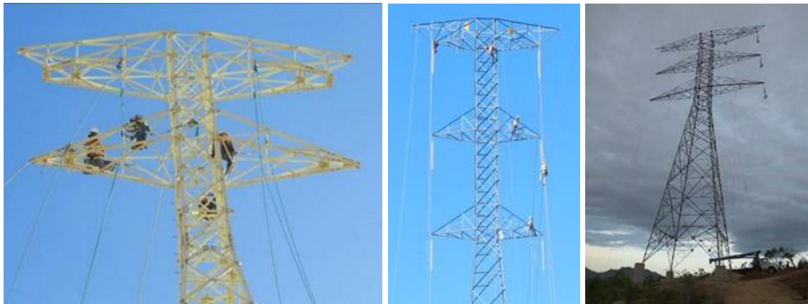
Figura.II.49. Procedimiento de vestido de estructuras.
