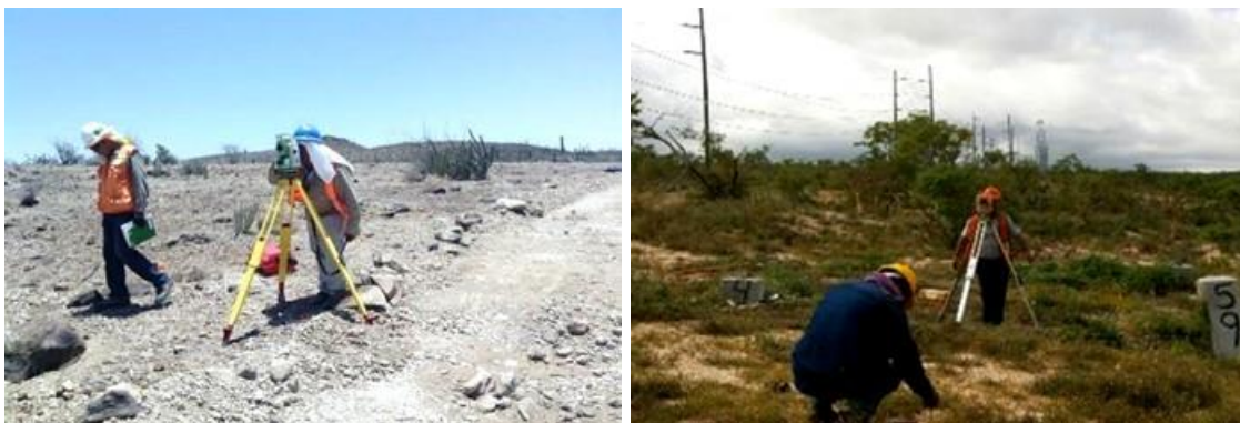
Figura.II.96. Localización de estructuras.
