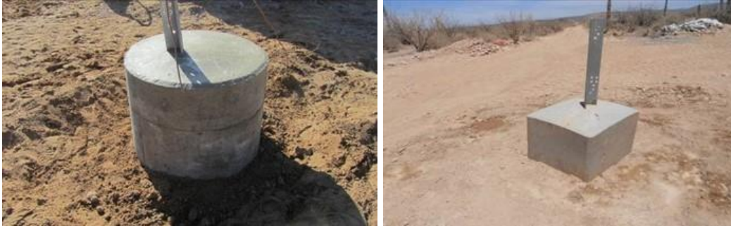
Figura.II.102. Cimentaciones tipo pilas y zapatas ya compactadas.
