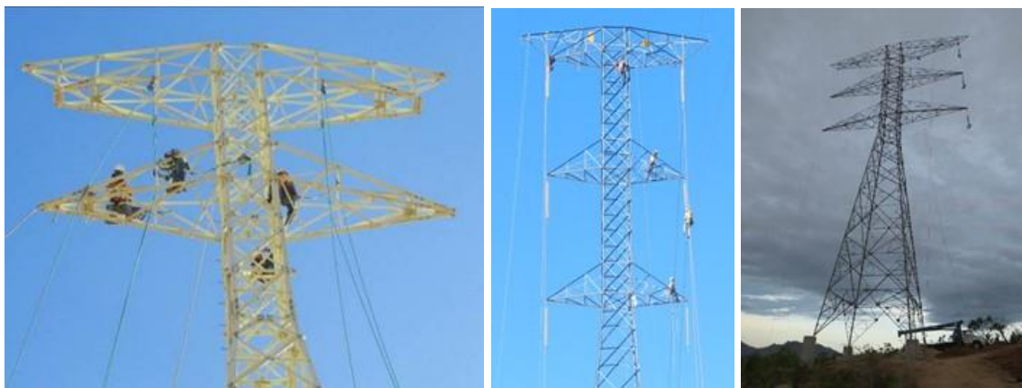
Figura.II.85. Procedimiento de vestido de estructuras.
