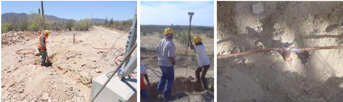
Figura.II.95. Se ilustran las actividades de instalación del sistema de tierras.
