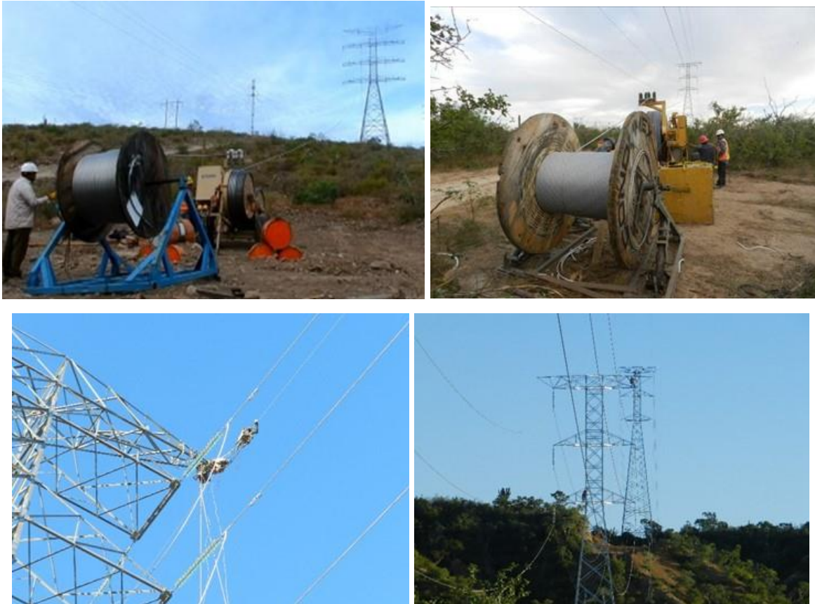
Figura.II.77. Tendido, tensionado y remate de cable conductor y de guarda.
