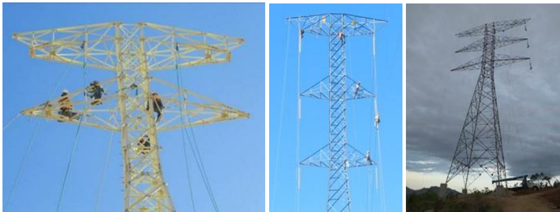
Figura.II.67. Procedimiento de vestido de estructuras.
