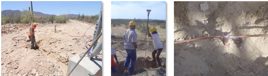
Figura.II.42. Se ilustran las actividades de instalación del sistema de tierras.
