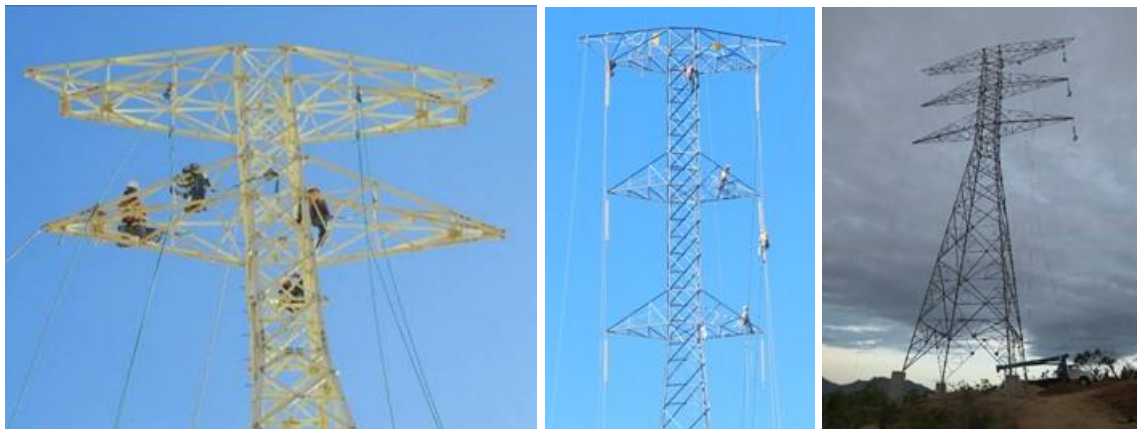
Figura.II.58. Procedimiento de vestido de estructuras.
