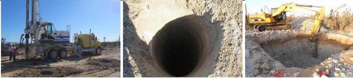
Figura.II.71. Excavación a cielo abierto para cimentación tipo pilas y zapatas.
