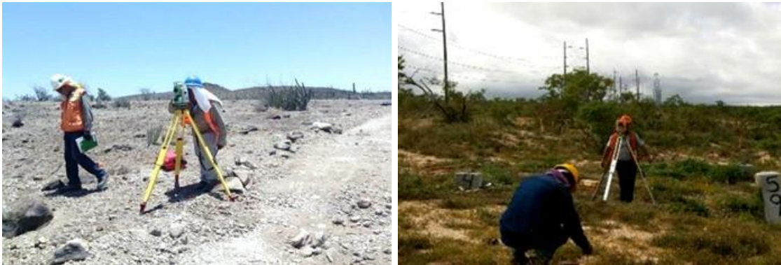
Figura.II.87. Localización de estructuras.
