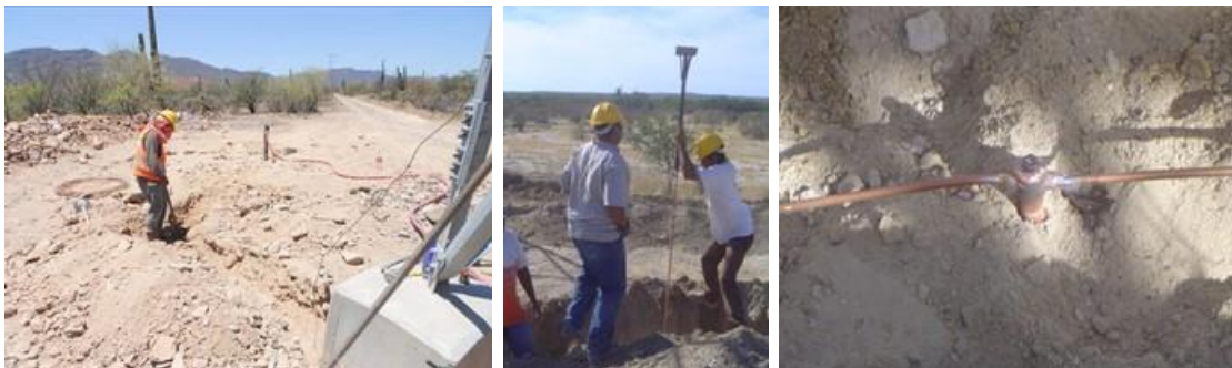
Figura.II.106. Se ilustran las actividades de instalación del sistema de tierras.
