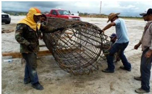
Figura.II.72. Habilitado de acero de refuerzo.
