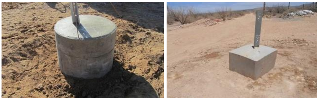
Figura.II.91. Cimentaciones tipo pilas y zapata ya compactado.
