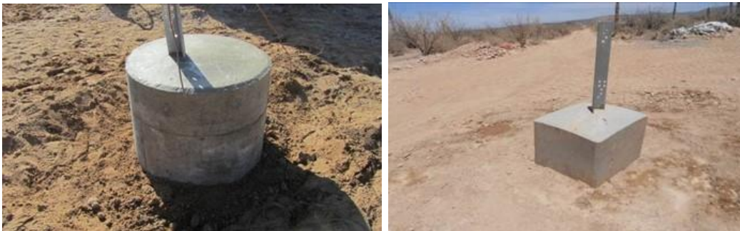
Figura.II.74. Cimentaciones tipo pilas y zapatas ya compactado.
