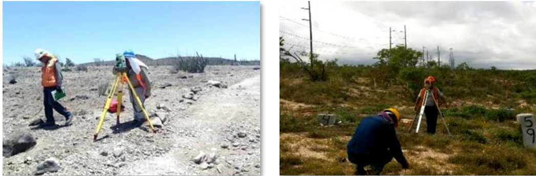
Figura.II.32. Localización de estructuras.
