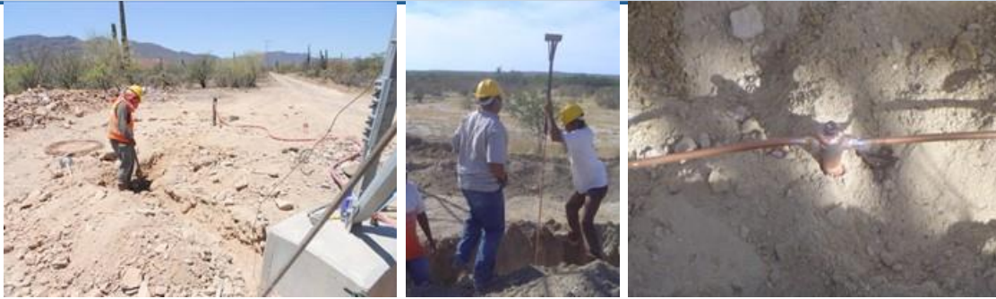
Figura.II.51. Se ilustran las actividades de instalación del sistema de tierras.
