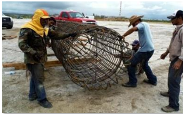
Figura.II.54. Habilitado de acero de refuerzo.
