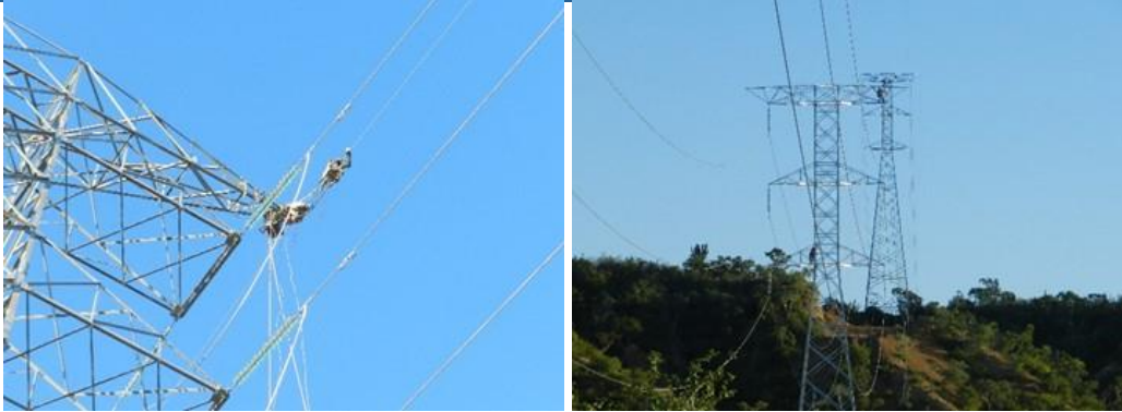
Figura.II.94. Tendido, tensionado y remate de cable conductor y de guarda.
