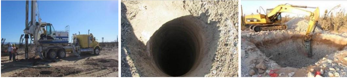
Figura.II.53. Excavación a cielo abierto para cimentación tipo pilas y zapatas.
