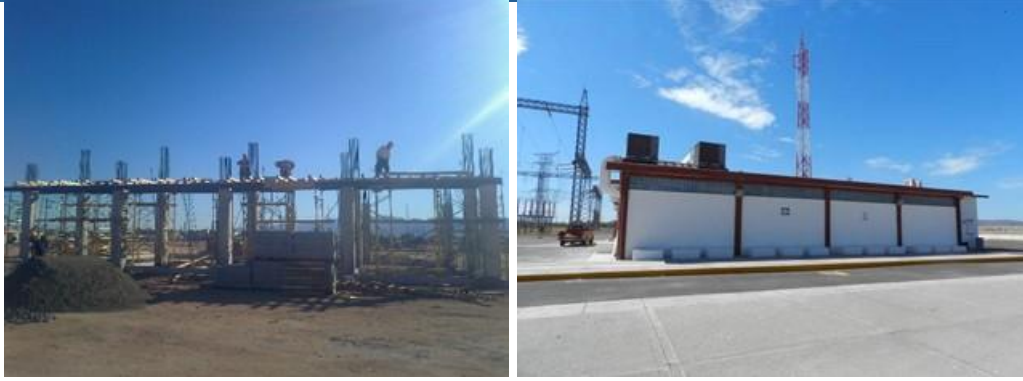
Figura.II.113. Construcción de caseta de control.
