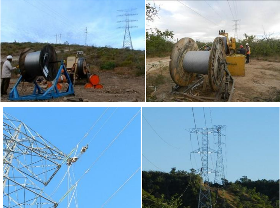
Figura.II.86. Tendido, tensionado y remate de cable conductor y de guarda.
