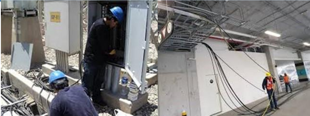
Figura.II.126. Tendido y conectado de cable de control.
