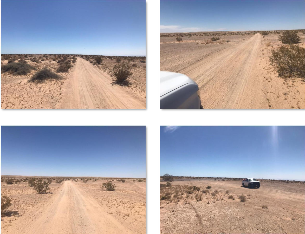
Figura.II.30. Imágenes del estado actual del camino de acceso asociado a la SE Golfo de Santa Clara.
