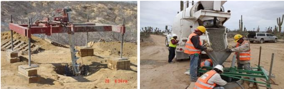
Figura.II.101. Proceso de cimentación.
