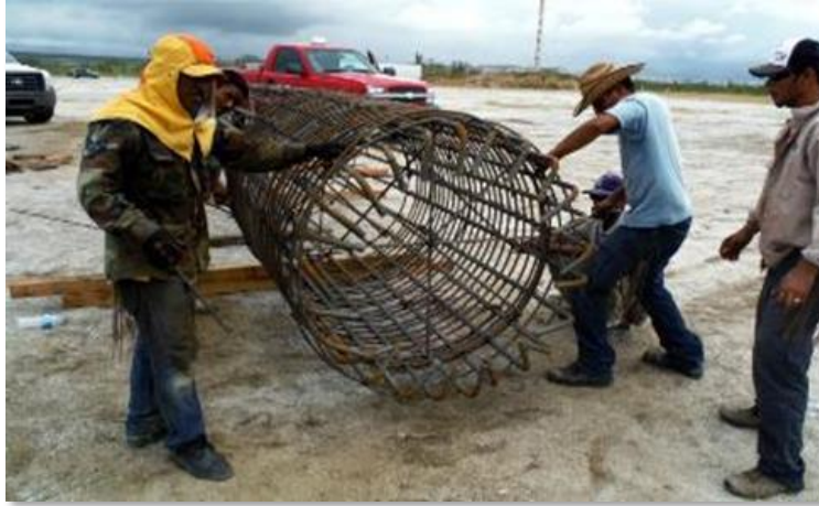
Figura.II.36. Habilitado de acero de refuerzo.
