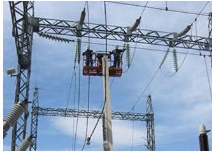
Figura.II.118. Montaje, tendido y conectado de buses.
