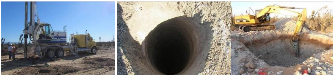
Figura.II.35. Excavación a cielo abierto para cimentación tipo pilas y zapatas.
