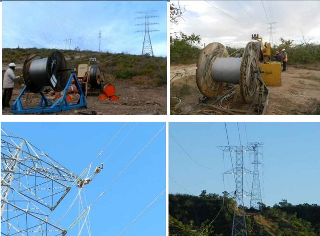
Figura.II.41. Tendido, tensionado y remate de cable conductor y de guarda.
