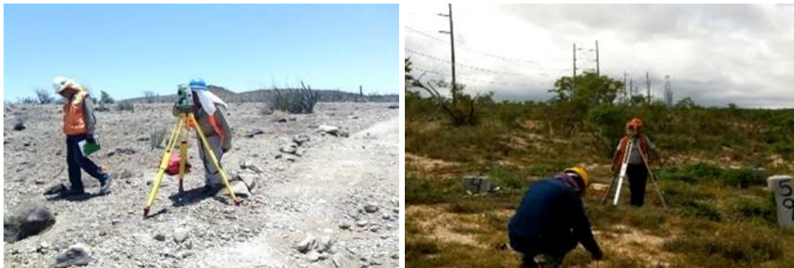
Figura.II.52. Localización de estructuras.
