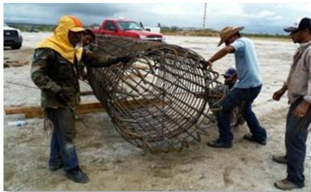
Figura.II.63. Habilitado de acero de refuerzo.
