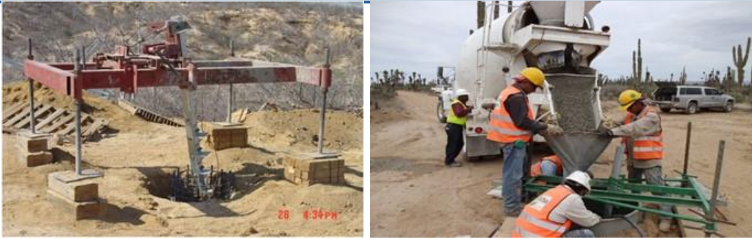
Figura.II.82. Proceso de cimentación.
