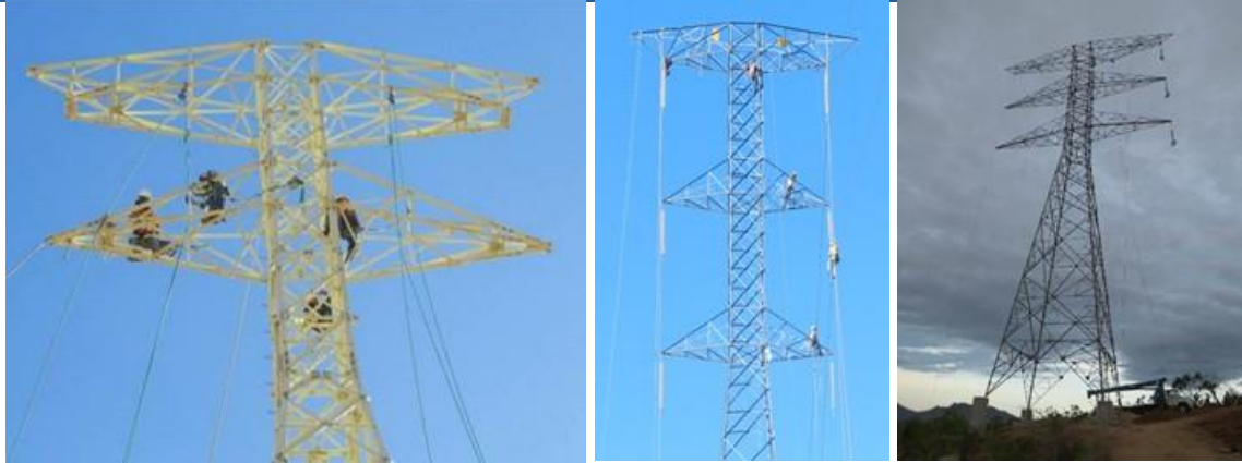
Figura.II.93. Procedimiento de vestido de estructuras.
