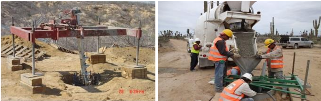
Figura.II.90. Proceso de cimentación.
