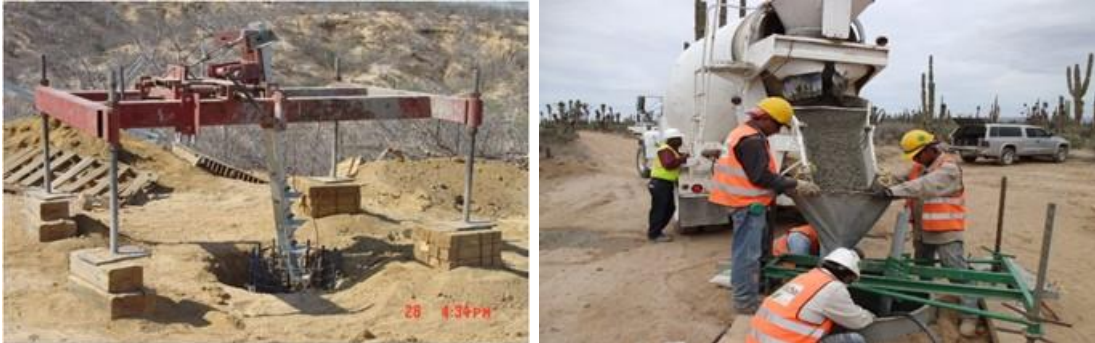
Figura.II.46. Proceso de cimentación.
