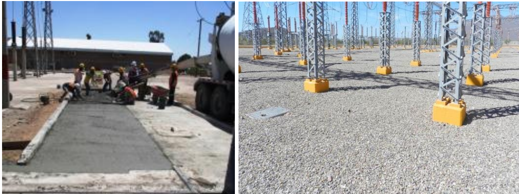
Figura.II.114. Ejemplos de pisos terminados.
