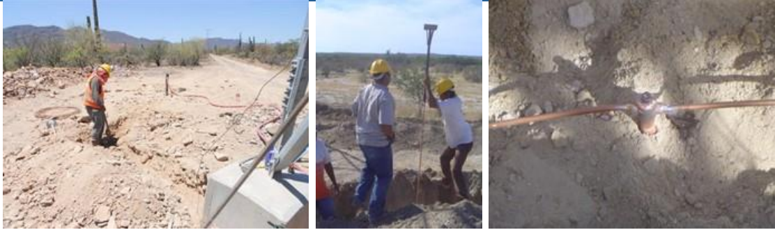
Figura.II.69. Se ilustran las actividades de instalación del sistema de tierras.
