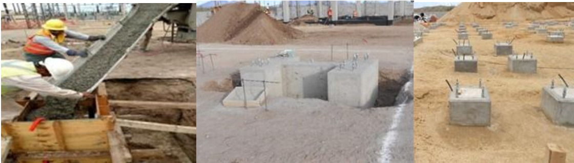
Figura.II.110. Colocación de concreto.
