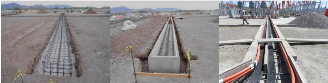
Figura.II.111. Ejemplos del proceso de construcción de trincheras y ductos.
