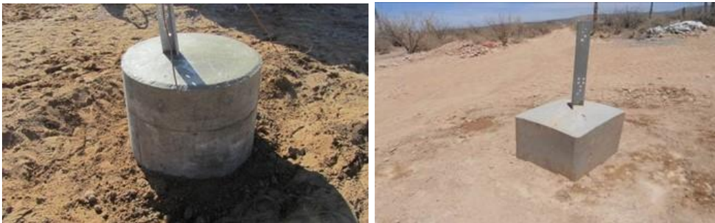
Figura.II.56. Cimentaciones tipo pilas y zapatas ya compactado.
