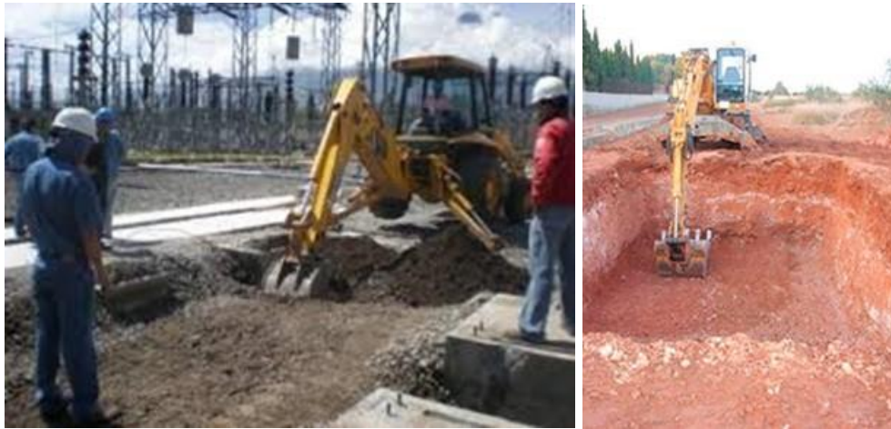
Figura.II.108. Excavaciones para cimentaciones.
