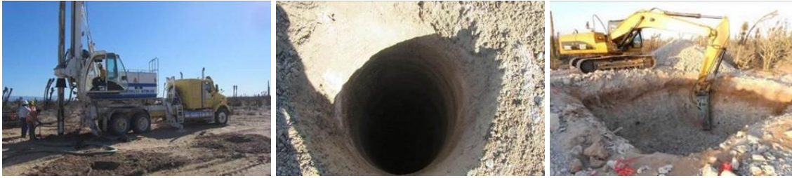
Figura.II.44. Excavación a cielo abierto para cimentación tipo pilas y zapatas.
