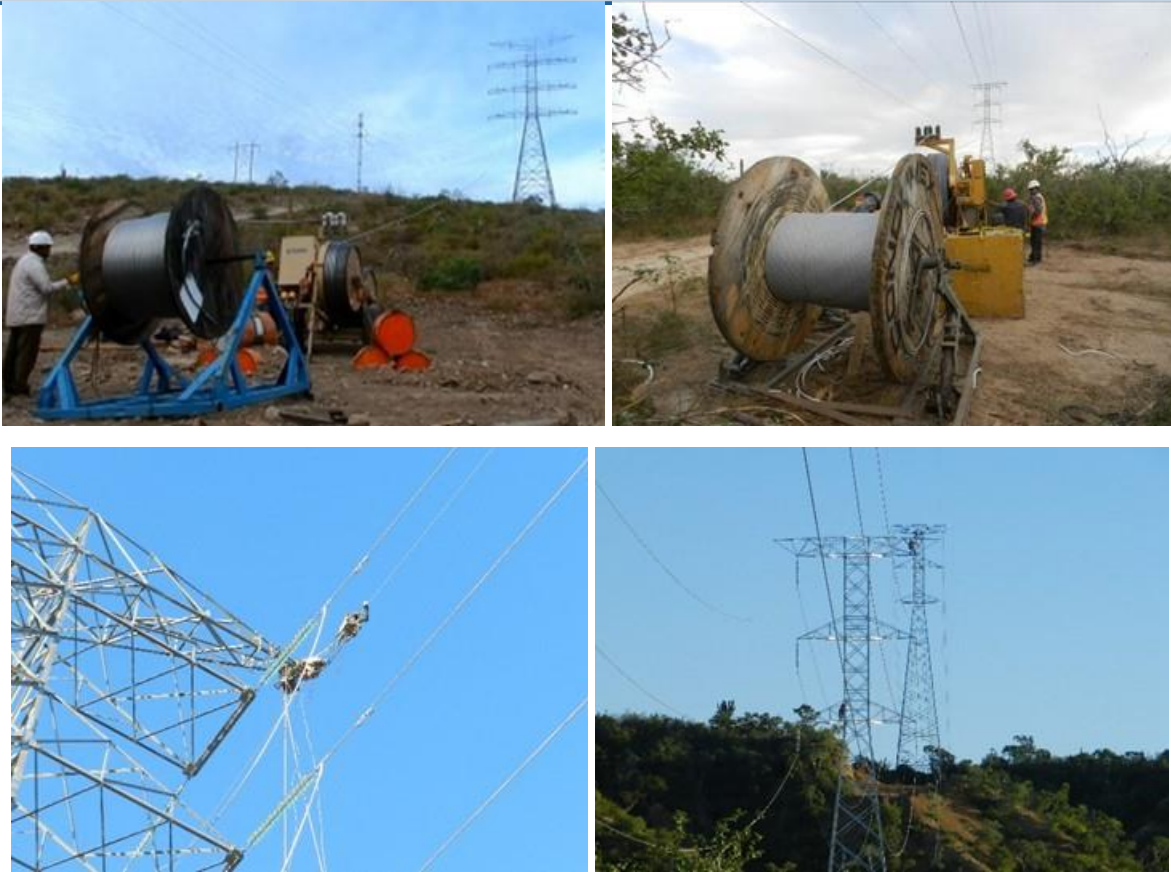
Figura.II.105. Tendido, tensionado y remate de cable conductor y de guarda.
