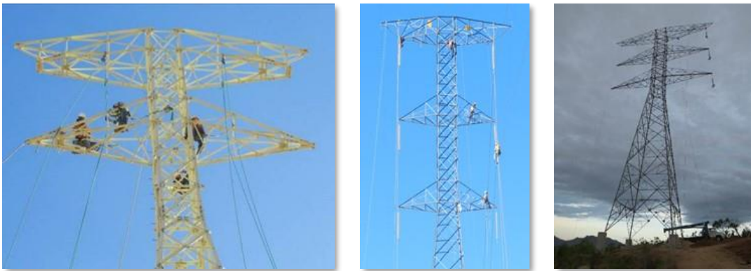
Figura.II.40. Procedimiento de vestido de estructuras.
