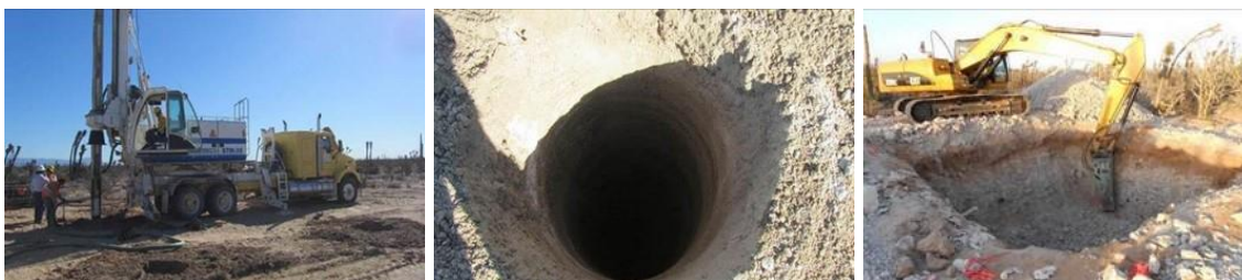
Figura.II.99. Excavación a cielo abierto para cimentación tipo pilas y zapatas.
