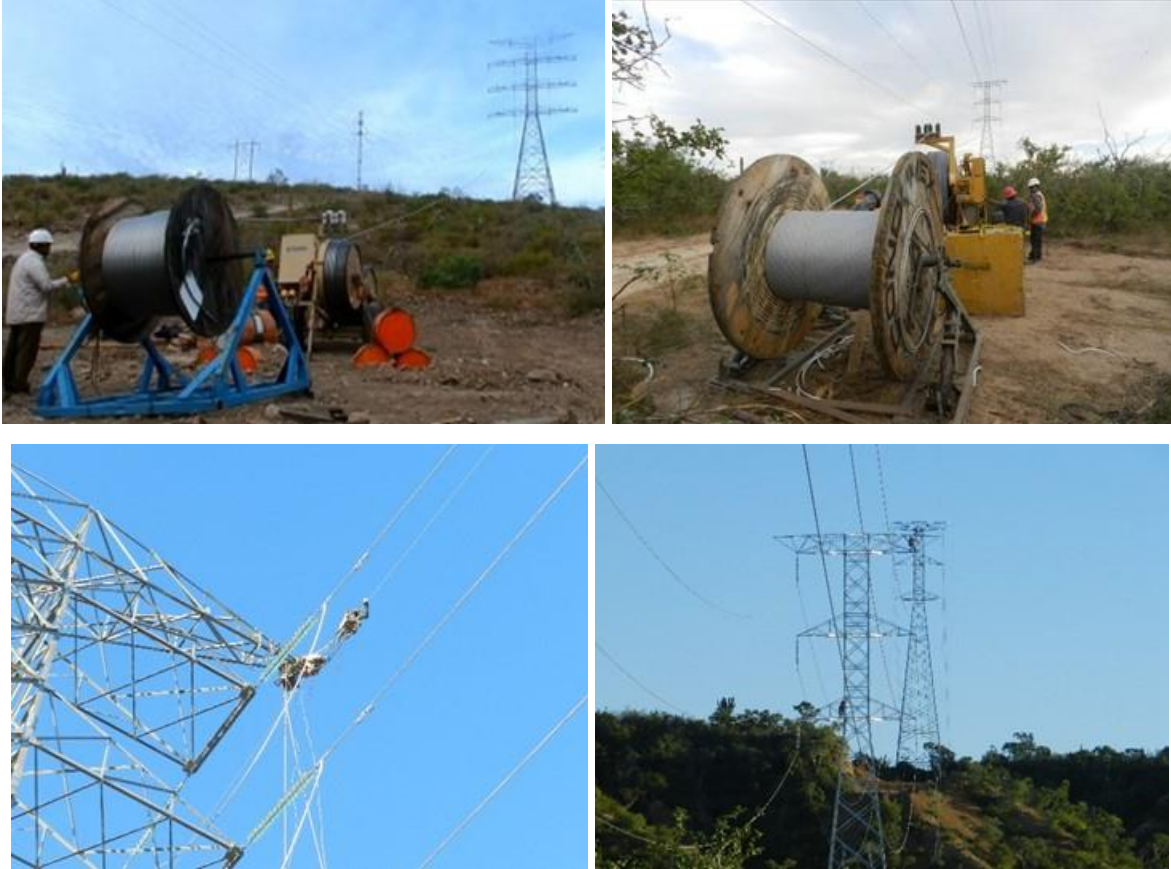
Figura.II.68. Tendido, tensionado y remate de cable conductor y de guarda.
