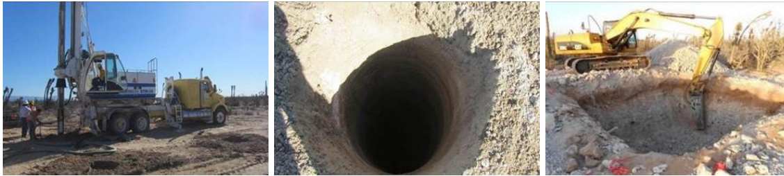
Figura.II.88. Excavación a cielo abierto para cimentación tipo pilas y zapatas.
