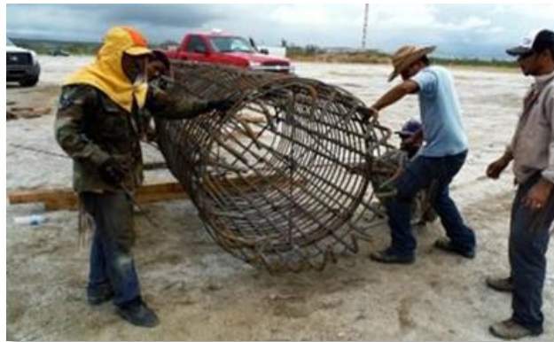
Figura.II.45. Habilitado de acero de refuerzo.
