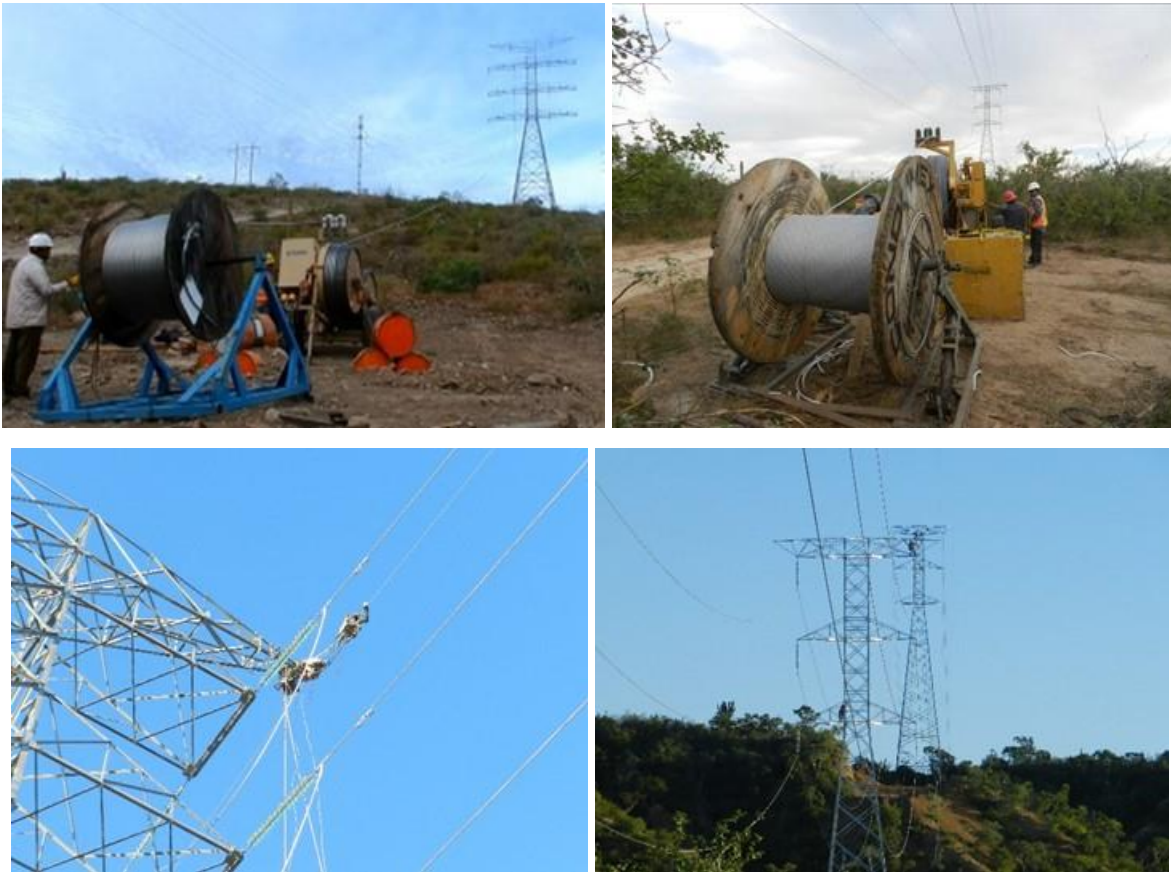
Figura.II.50. Tendido, tensionado y remate de cable conductor y de guarda.
