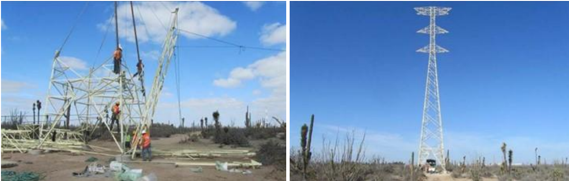
Figura.II.92. Armado, nivelado y montaje de estructuras.
