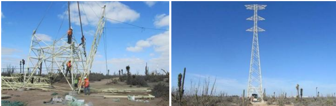
Figura.II.103. Armado, nivelado y montaje de estructuras.
