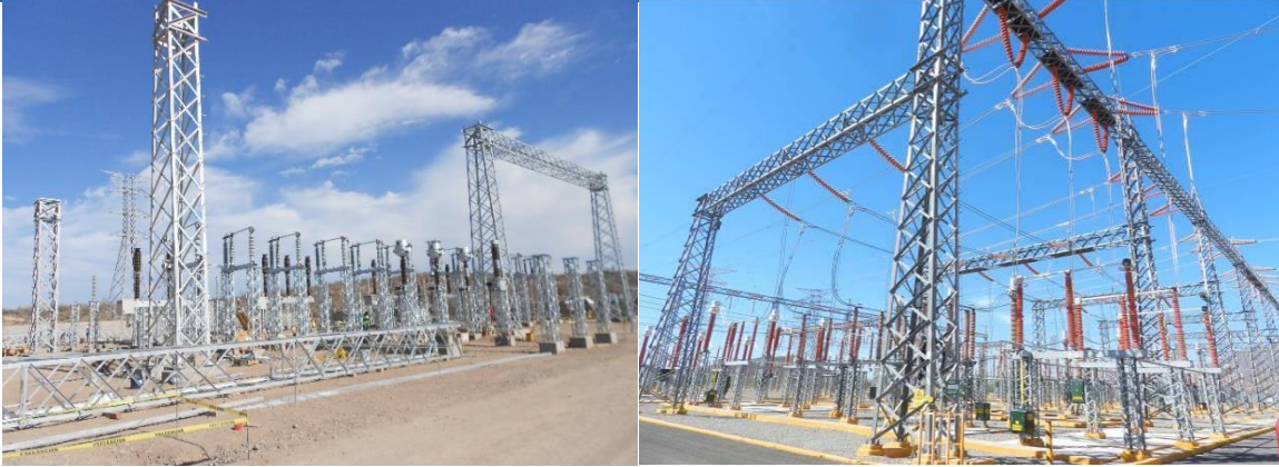
Figura.II.117. Montaje de estructuras mayores.
