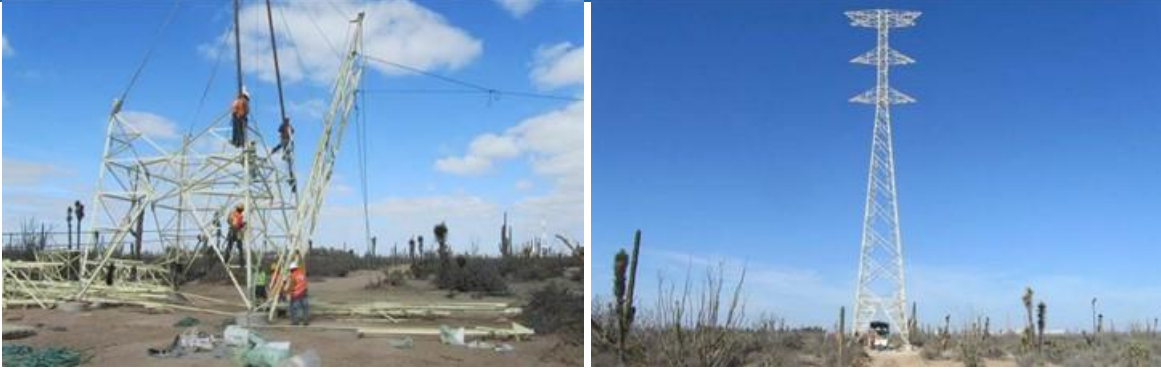
Figura.II.84. Armado, nivelado y montaje de estructuras.
