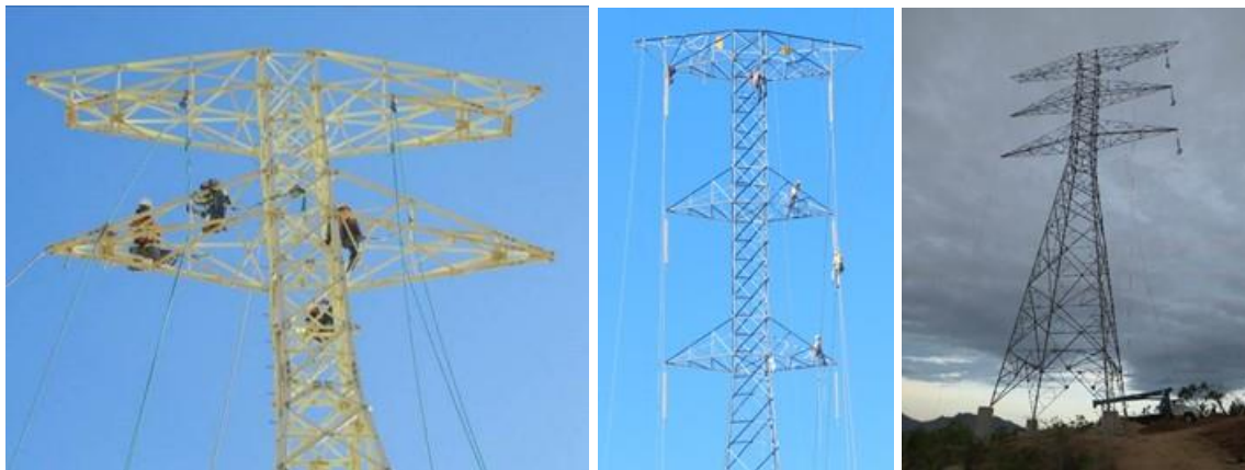
Figura.II.76. Procedimiento de vestido de estructuras.
