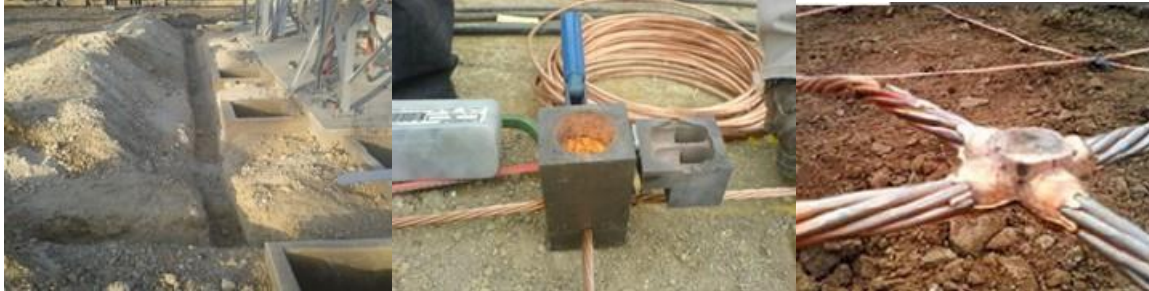
Figura.II.128. Colocación de sistema de tierras.
