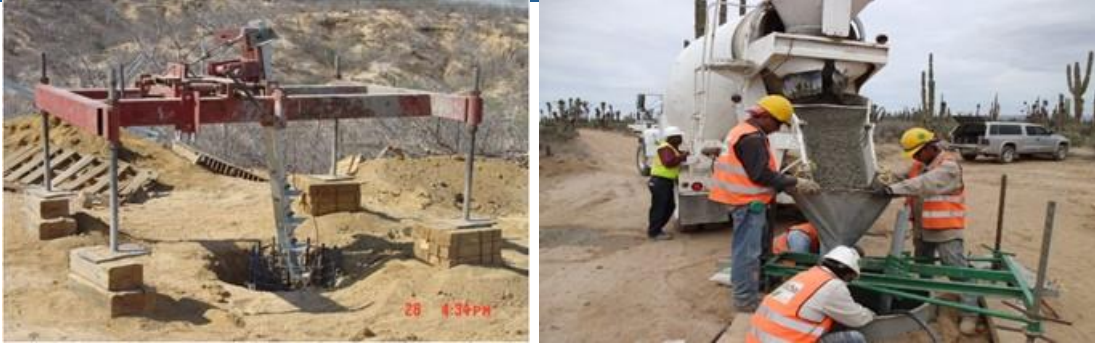
Figura.II.64. Proceso de cimentación.
