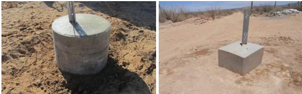
Figura.II.47. Cimentaciones tipo pilas y zapatas ya compactado.
