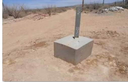
Figura.II.38. Cimentaciones tipo pilas y tipo zapatas.
