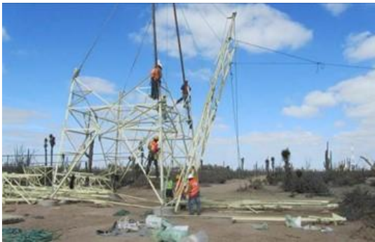
Figura.II.39. Armado, nivelado y montaje de estructuras.
