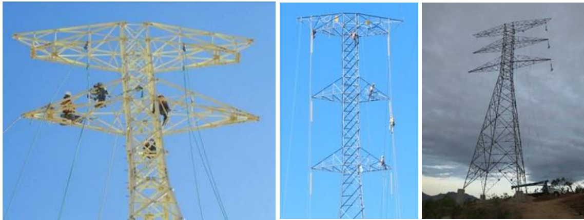
Figura.II.104. Procedimiento de vestido de estructuras.
