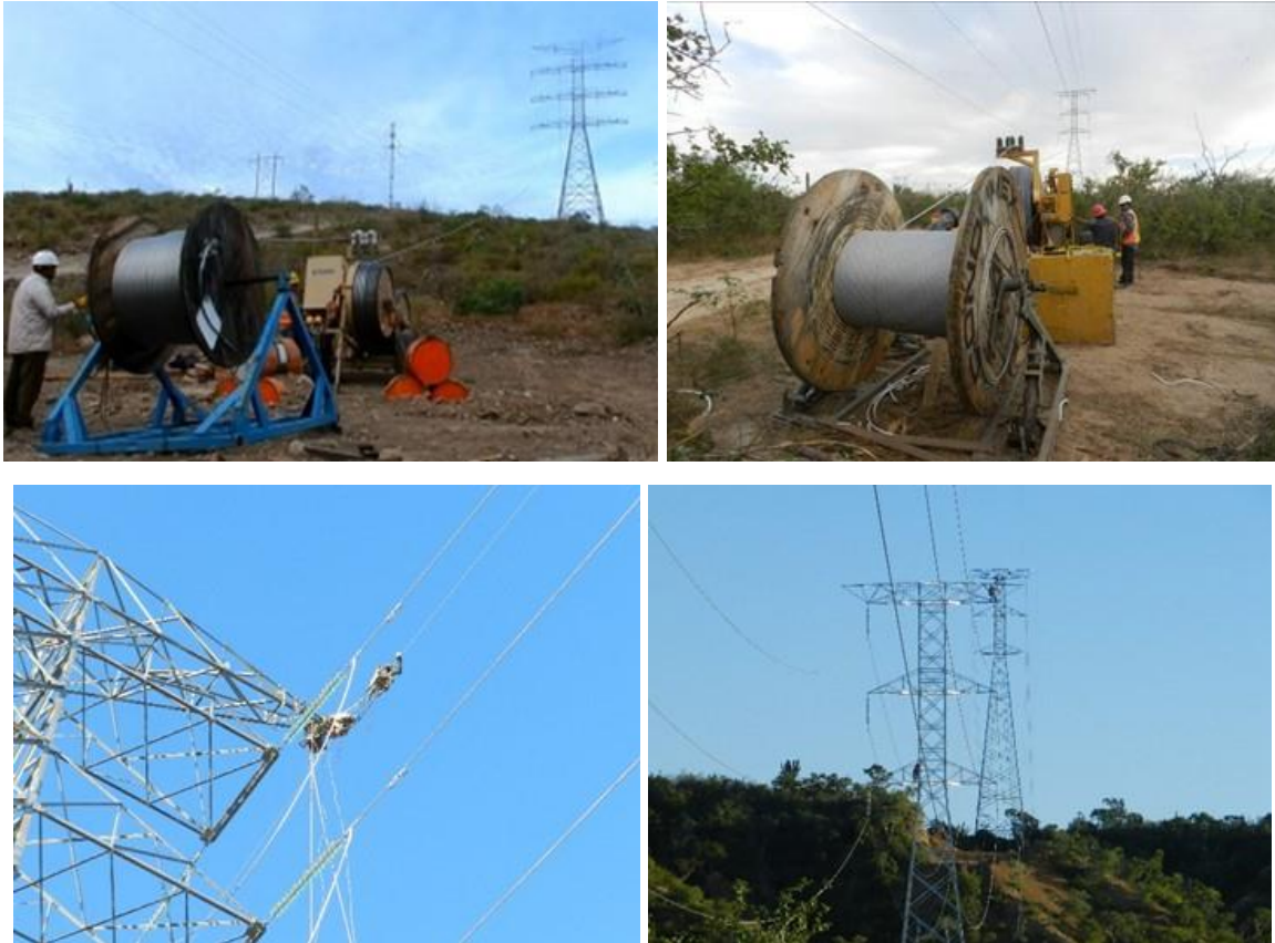
Figura.II.59. Tendido, tensionado y remate de cable conductor y de guarda.
