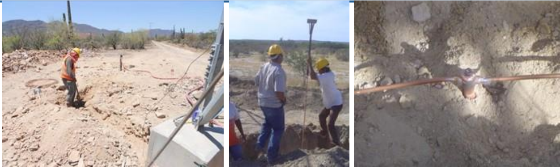
Figura.II.60. Se ilustran las actividades de instalación del sistema de tierras.
