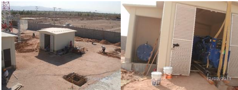
Figura.II.129. Montaje de planta diésel.
