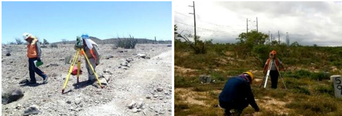
Figura.II.79. Localización de estructuras.
