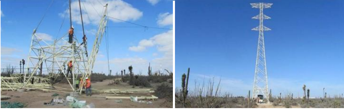
Figura.II.57. Armado, nivelado y montaje de estructuras.
