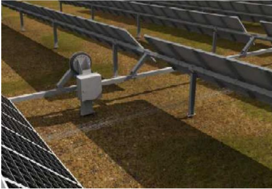
Figura II. 11. Accionamiento electromecánico del seguidor.
