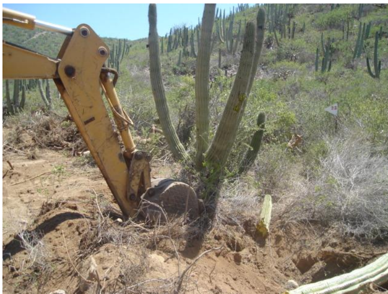
Ejemplo de rescate de planta con maquinaria pesada
