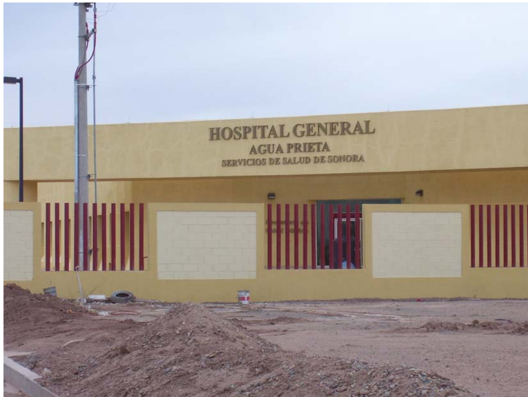
SSA - Hospital General de Agua Prieta.
