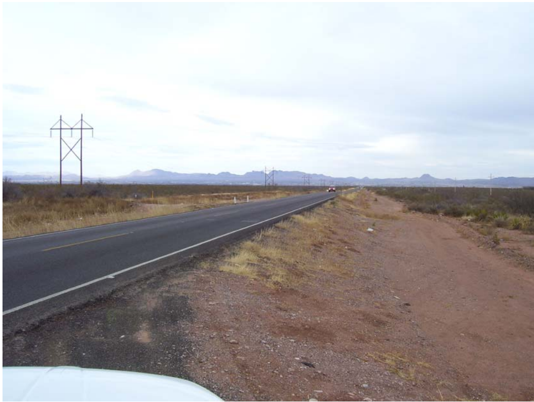
Vista del Carretera Federal N° 2 Cananea - Agua Prieta acceso principal de la 171 CC Agua Prieta II (Con Campo Solar).
