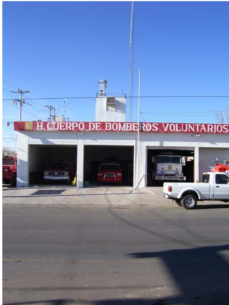
Estación de Bomberos de Agua Prieta.
