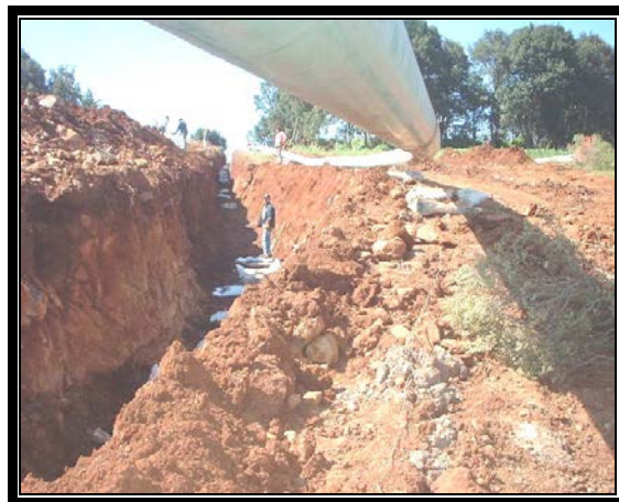
Bajado de tubería sobre cama de costales rellenos con material de banco.
