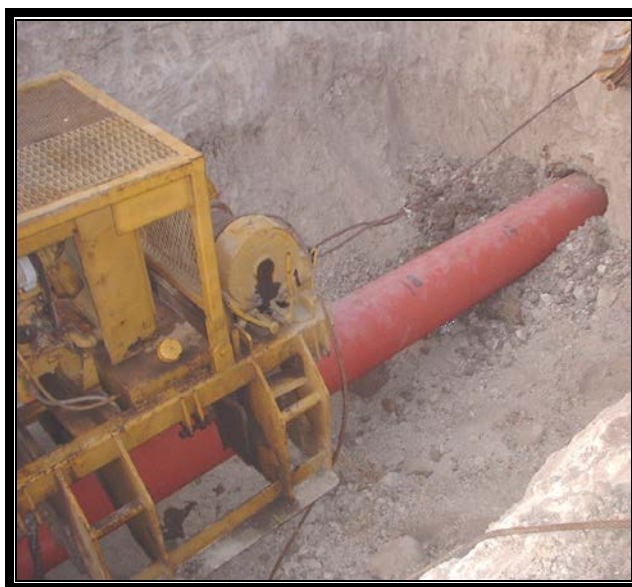
Hincado de tubería (camisa) con máquina tuneleadora.
