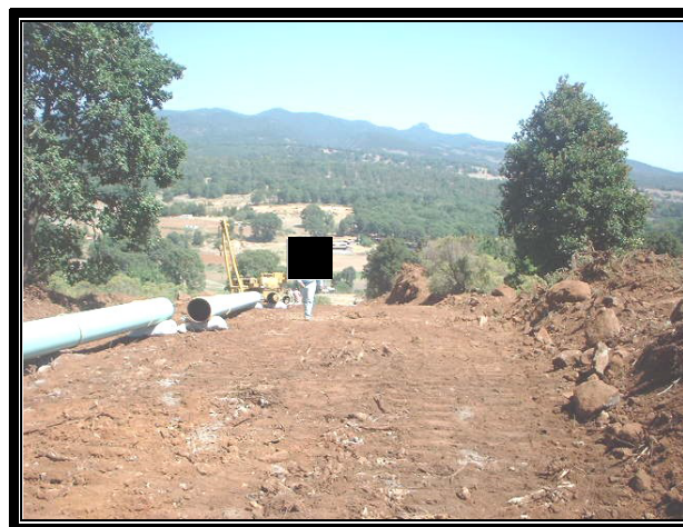
FOTOGRAFIA DE PERSONA FISICA, ART. 116 PRIMER PARRAFO DE LA LGTAIP Y ART. 113 FRACCIÓN I DE LA LFTAIP. Tendido de tubería con tractor pluma.
