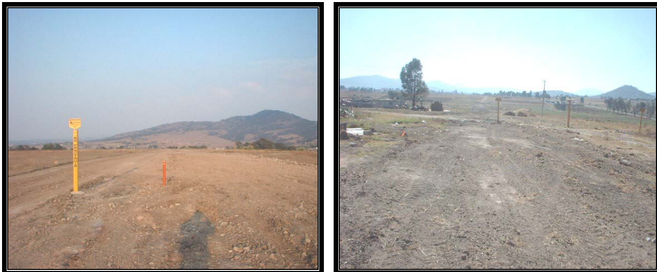
Postes de señalización de límite de derecho de vía.
