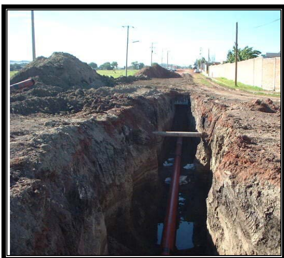
Cruce con línea de agua potable.
