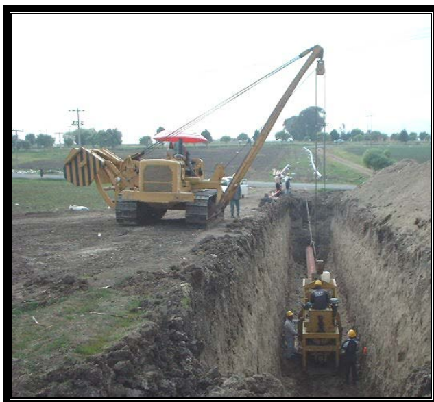
Hincado de tubería (camisa) con máquina tuneleadora.
