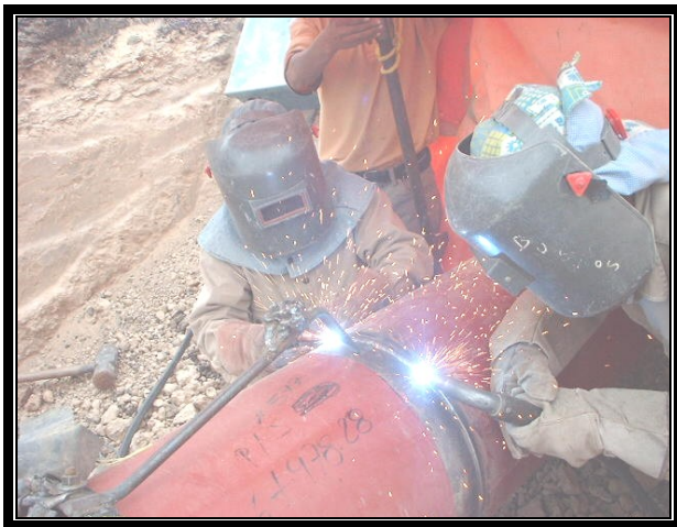
Aplicación de soldadura semiautomática en línea regular.
