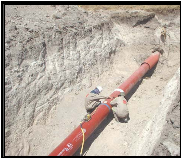
Inspección radiográfica (exterior).
