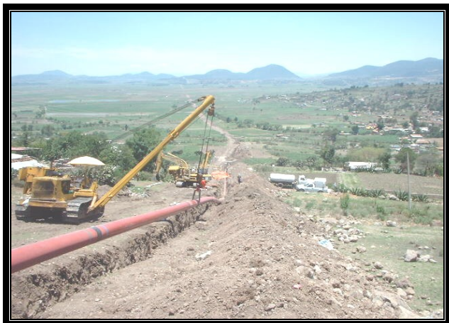
Bajado de tubería en línea regular utilizando tractores pluma.
