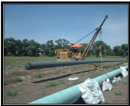
Introducción de línea conductora en cruzamiento direccionado.
