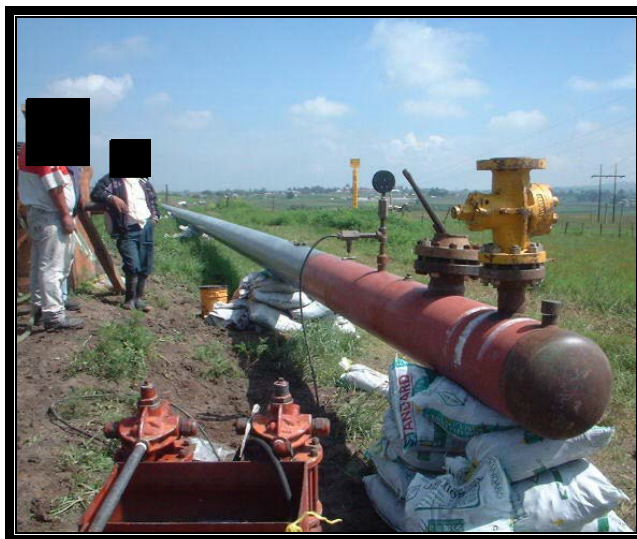
Arreglo para prueba hidrostática
