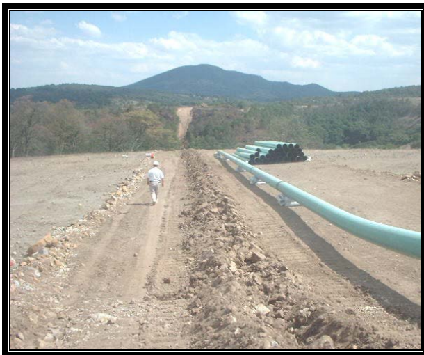
Tubería descargada y apilada dentro del derecho de vía.
