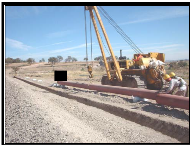
FOTOGRAFIA DE PERSONA FISICA, ART. 116 PRIMER PARRAFO DE LA LGTAIP Y ART. 113 FRACCIÓN I DE LA LFTAIP. Tendido de tubería con tractor pluma.
