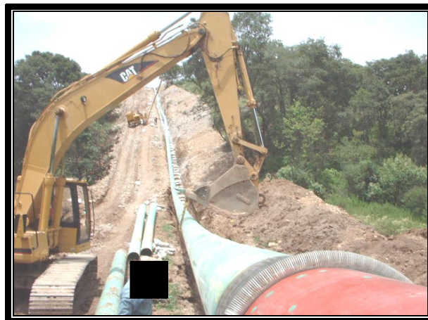
Bajado de tubería en línea regular utilizando tractores pluma.
