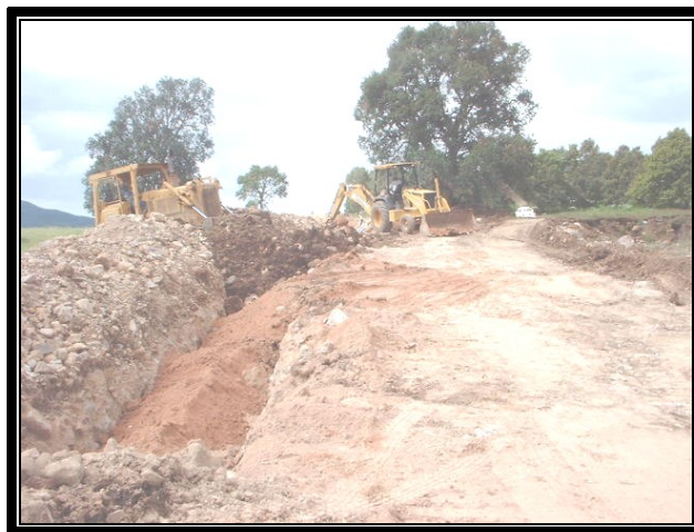
Acolchonado de tubería con material de banco y tapado posterior.
