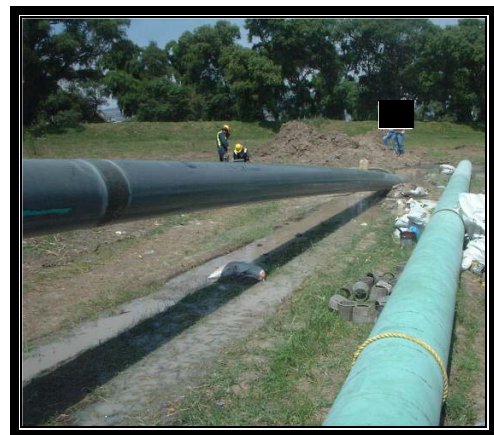
Introducción de línea conductora en cruzamiento direccionado.
