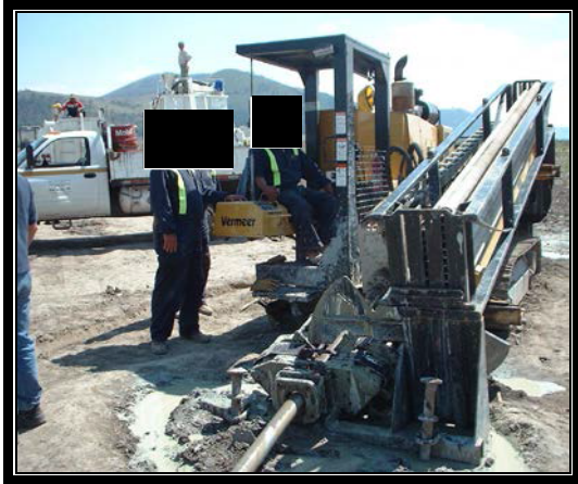
Equipo de perforación.
