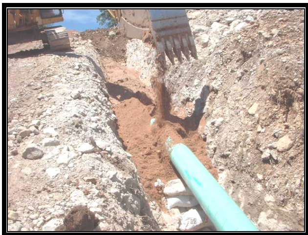
Acolchonado de tubería con material de banco y tapado posterior.
