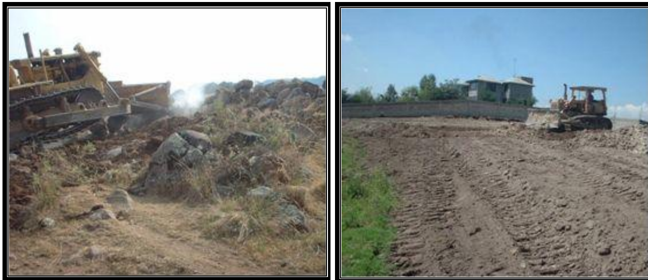
Apertura del derecho de vía con tractor buldócer
