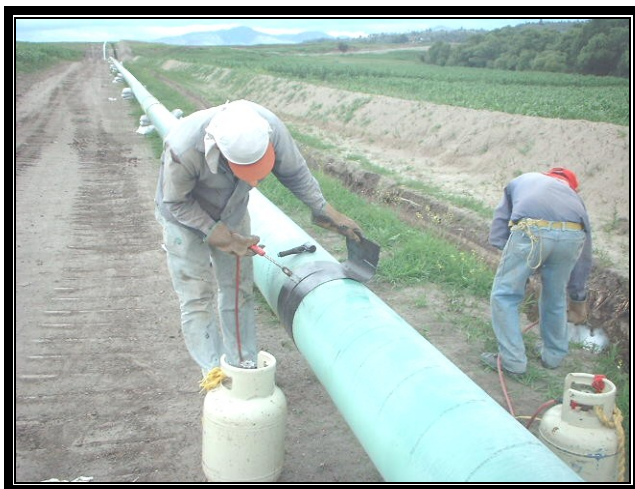
Colocación de mangas termo-contráctiles en juntas de soldadura
