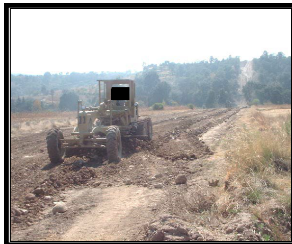
Reacondicionamiento del derecho de vía con tractor bulldozer y motoconformadora.
