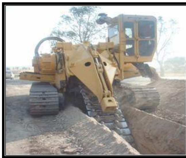
Excavación con máquina zanjadora.
