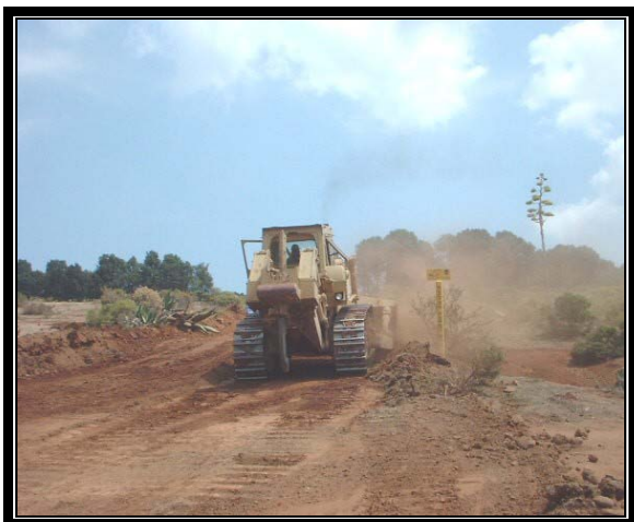
Reacondicionamiento del derecho de vía con tractor bulldozer y motoconformadora.
