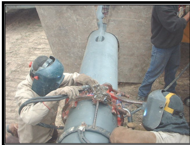
Alineado y punteo de tubería utilizando alineador exterior.
