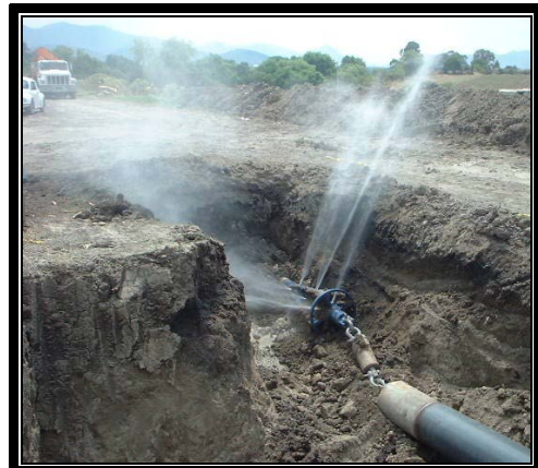
Vista del ampliador con bentonita a presión.
