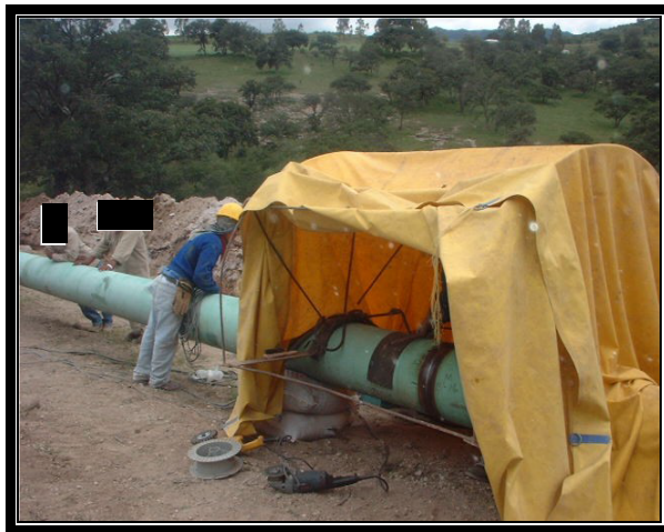
Aplicación de soldadura semiautomática en línea regular.
