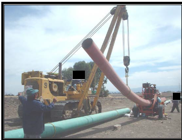
Doblado de tubería en campo utilizando tractor pluma y dobladora hidráulica.
