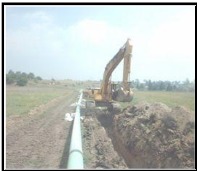
Excavación con máquina excavadora.
