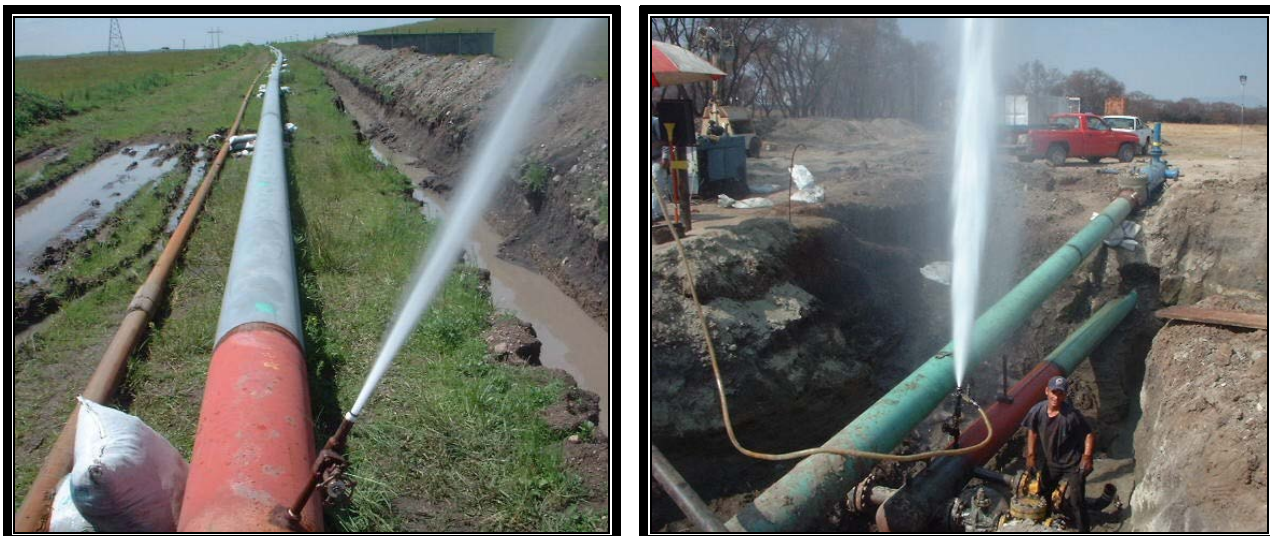
Desfogue de agua para bajar la presión después de la prueba hidrostática.
