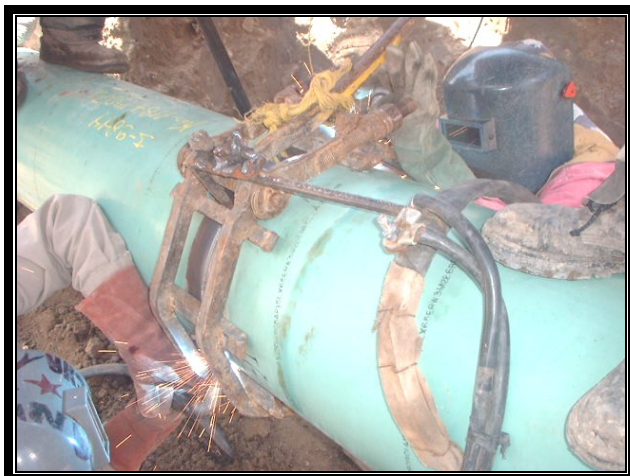
Alineado y punteo de tubería utilizando alineador exterior.
