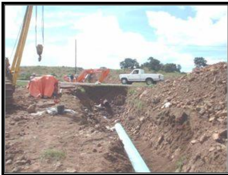
Excavación interrumpida por cruce con carretera.
