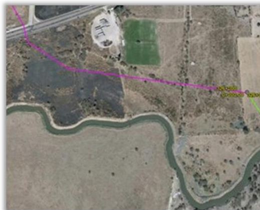
Foto IV.2.2.4.4. Punto de llegada del gasoducto e inicio del Ramal. Agropecuario. Vista aérea.
