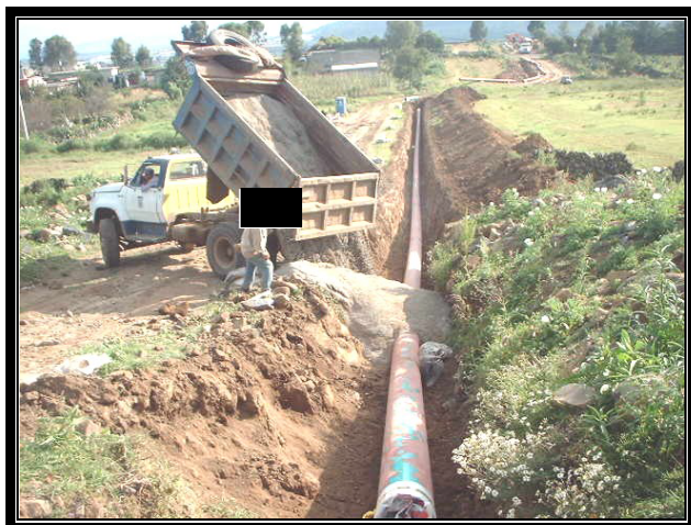
Acarreo de material de banco.
