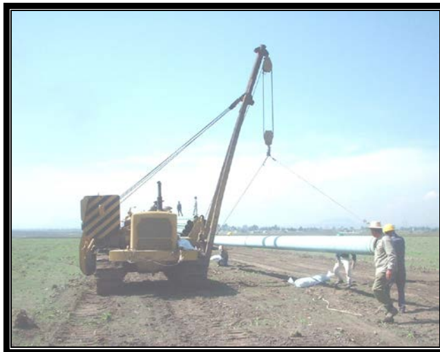
Descarga y tendido de tubería.
