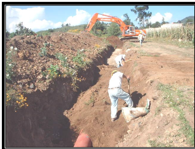
Acolchonado manual de tubería.
