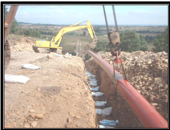
Bajado de tubería sobre cama de costales rellenos con material de banco.
