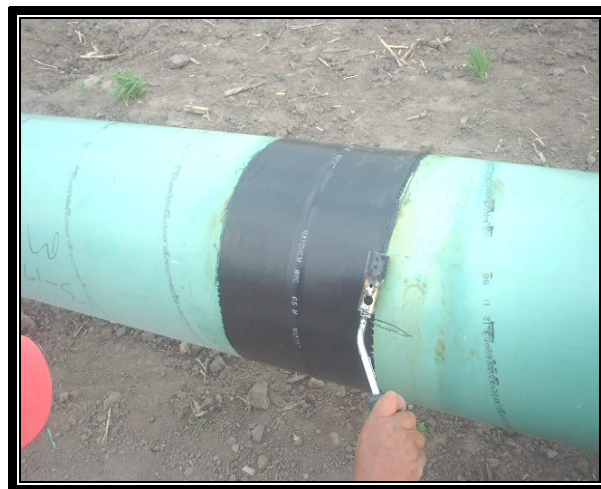
Colocación de mangas termo-contráctiles en juntas de soldadura
