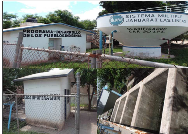
Figura IV.29. Planta Potabilizadora ubicada en Mochichahui.
