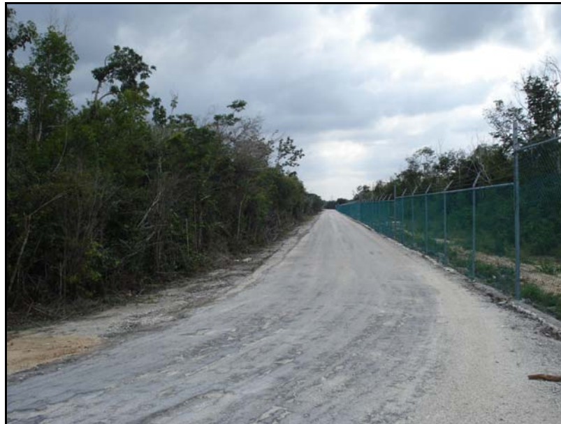
Fotografía 8.- Vista de la colindancia noroeste del área A, nótese la presencia de la infraestructura existente.
