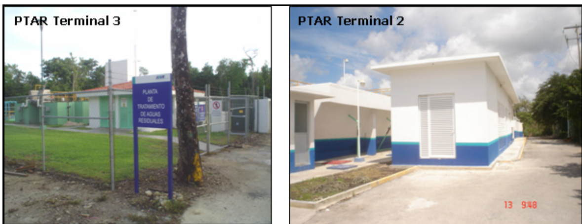
Figura II.5. Plantas de tratamiento de aguas residuales existentes.
