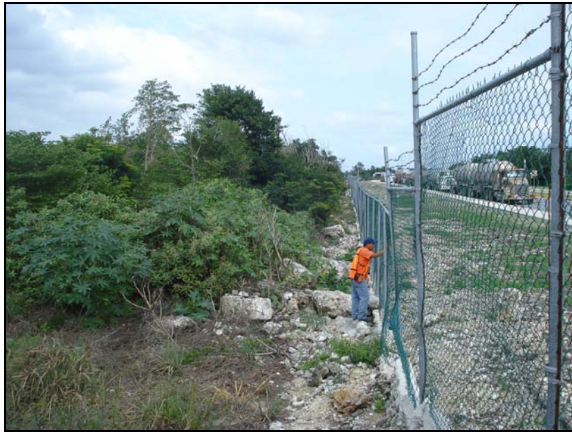
Fotografía 9.- Vista de la colindancia sureste del área A, en la cual existe una vialidad importante, utilizada principalmente por autotranques que proveen de combustibles.
