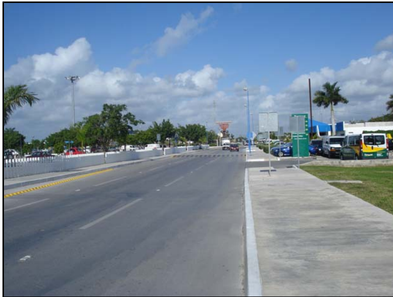
Fotografía 1.- Vista general de uno de los accesos principales del Aeropuerto Internacional de Cancún. Al lado izquierdo de la fotografía se aprecia uno de los estacionamientos públicos en funcionamiento y al fondo se visualiza la torre de control.
