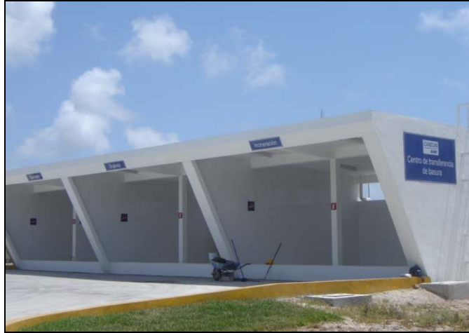
Figura II.6. Centro de Transferencia de Residuos Sólidos en funcionamiento.
