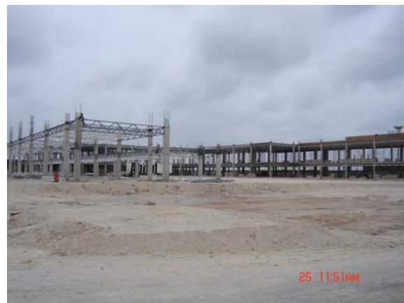
Foto No. 2.- Estructura de acero de la T-3
