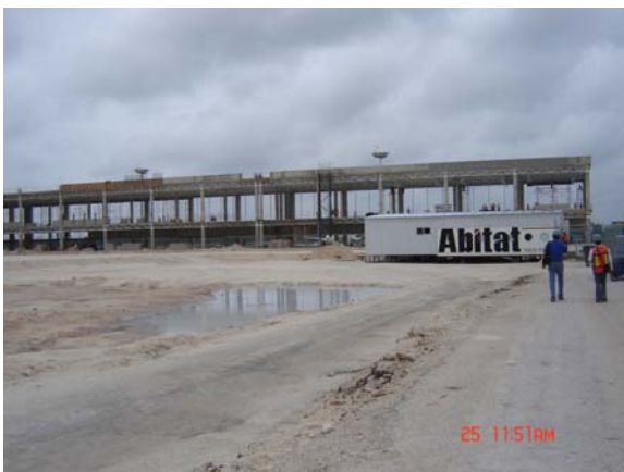
Foto No. 1.- Etapa de Construcción de la T-3
