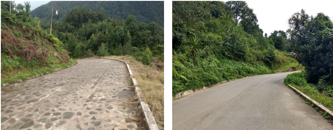
Imagen IV. 63. Tramos del camino actual que se encuentran pavimentados y/o empedrados.
