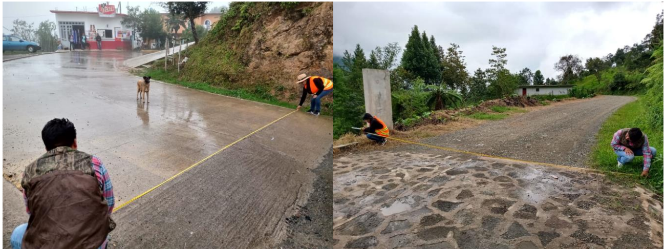
Imagen IV. 35. Trabajos previos realizados sobre el camino actual.
