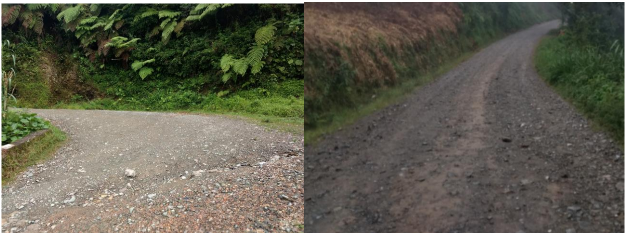
Imagen IV. 17. Suelos encontrados a lo largo de la modificación del proyecto.
