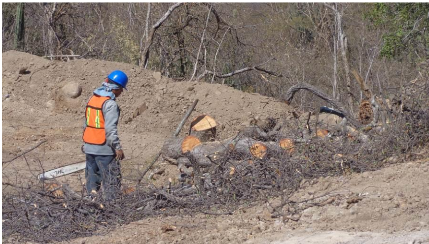
Imagen II.48 Troceo en fracciones pequeñas y con medios mecánicos
