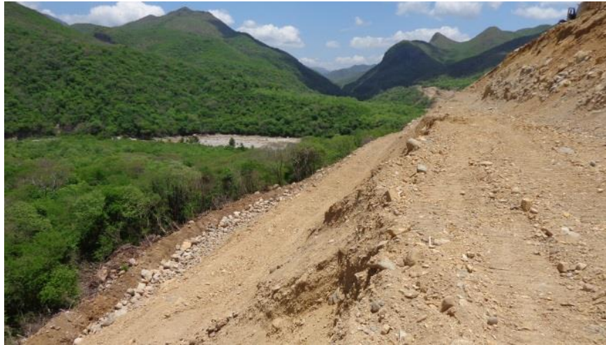
Imagen II.53 Se realiza estabilización de taludes, Km. 152+600
