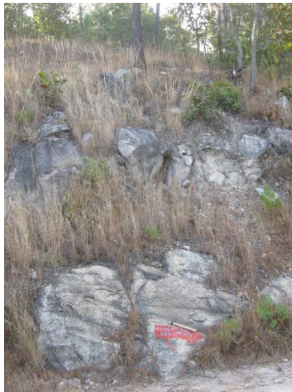
Imagen IV.27 Granito en el Km 101+730
