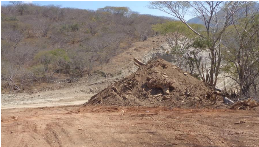
Imagen II.50 Despalme y acopio de suelo fértil con ramas para arropo de sitios desprovistos de vegetación
