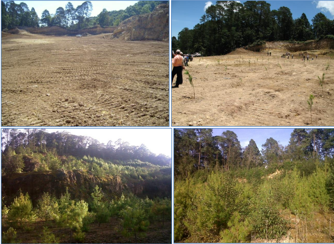
Imagen VI.54 Imagen que muestra el final de uso de un banco de tiro, el proceso de siembra de especies del sitio, y la rehabilitación de este mismo sitio 5 años después.
