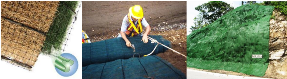
Imagen VI.9 De izquierda a derecha: Mantos Permanentes, colocación de mantos permanentes y Manto Permanente instalado.
