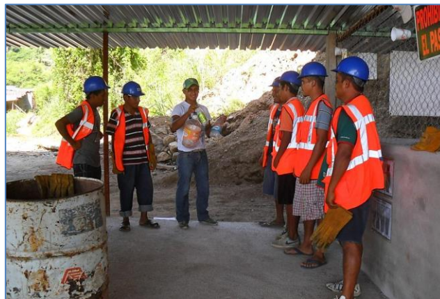
Imagen VI.4 Ejemplos de capacitación al personal para llevar a cabo el reciclado de materiales en la obra.
