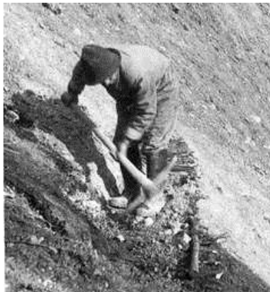
Imagen VI.21 Método de Praxl para la construcción de cordones utilizando una capa de ramas y estacas muertas de coníferas.
