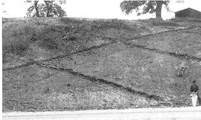
Imagen VI.26 Construcción de surcos
