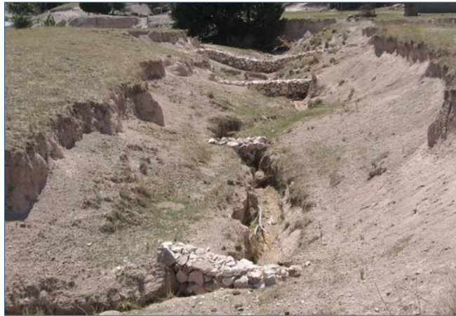
Imagen VI.15 Ejemplo de obras de Restauración de Suelos, con presas filtrantes de piedra acomodada, para reducir la erosión hídrica y generación de cárcavas (imagen: Gómez, 2008).
