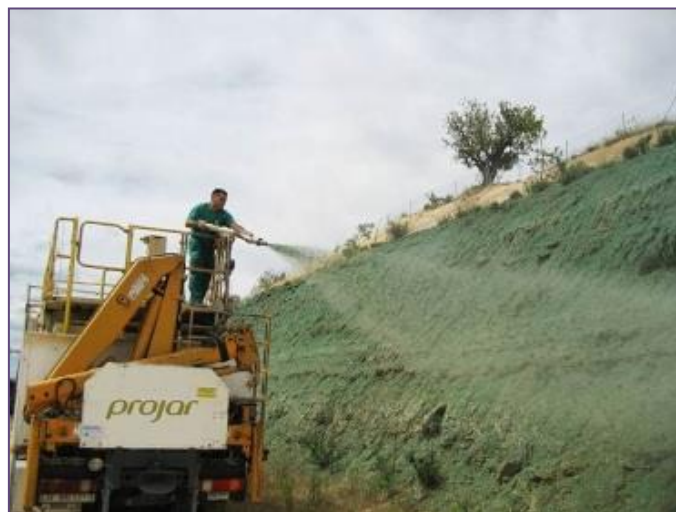
Imagen VI.6 Imagen que muestra la forma de aplicación de la hidrosiembra sobre la superficie a tratar.
