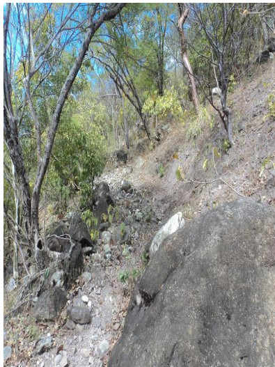
Imagen IV.28 Roca Ígnea extrusiva, intemperizada y fracturada en el Km 149+000
