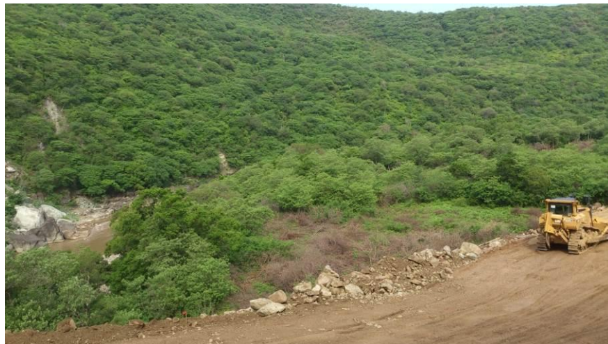
Imagen II.46 Sitio alterado con vocación agrícola, sitio de tiro cercano al proyecto, Km. 161+300
