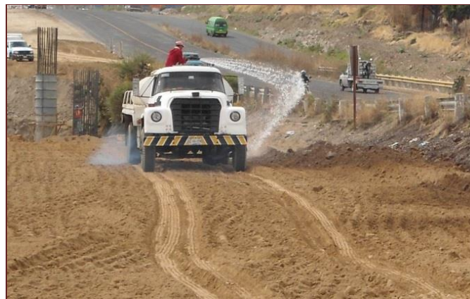
Imagen VI.5 Ejemplo de riego en un área de construcción carretera para evitar polvos.
