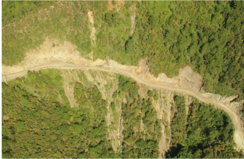
Imagen IV.17 Fotografía aérea de una zona aledaña al proyecto donde se aprecia el deslizamiento de material geológico producto de alterar la estabilidad del terreno en la zona alta.
