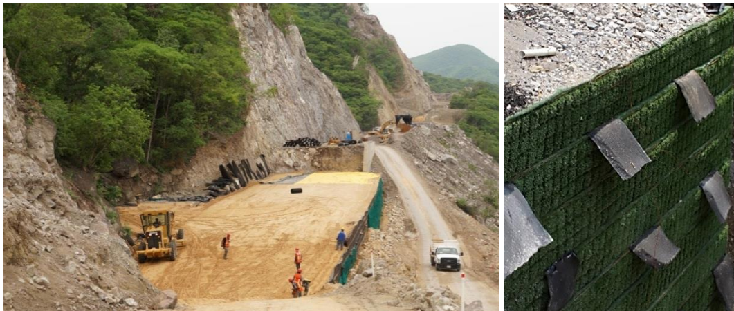
Imagen VI.10 A la izquierda construcción de Muro Verde. A la derecha apariencia muro verde.
