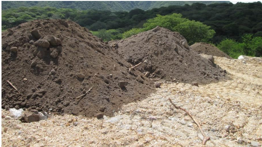
Imagen II.56 Material vegetal para arropo o restauración de áreas utilizadas como bancos de tiro
