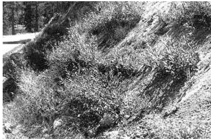
Imagen VI.23 Construcción de empalizadas con fajinas de vegetación, de dos años, utilizando sauces.
