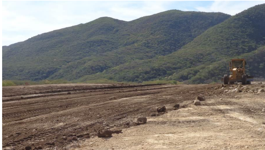
Imagen II.57 Arrope de sitios usados como banco de desperdicio
