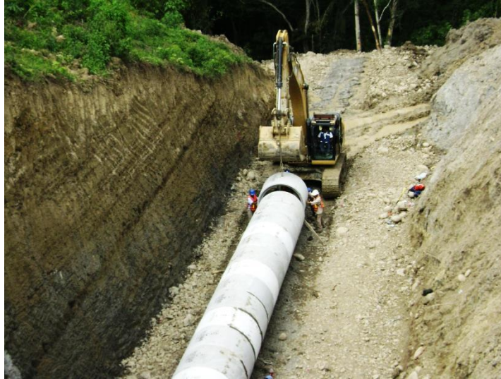
Imagen II.67 Colocación de Tubería de concreto
