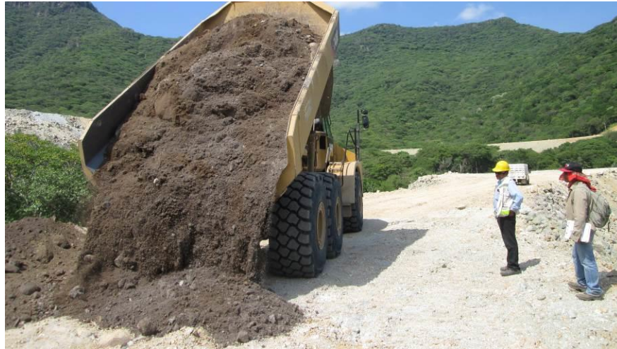
Imagen II.55 Depósito de material vegetal para arropo de taludes
