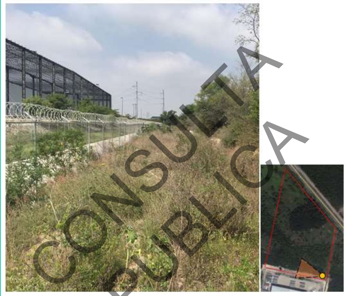
Figura IV.19 Vista en dirección oeste del limite sur del lote 4B
