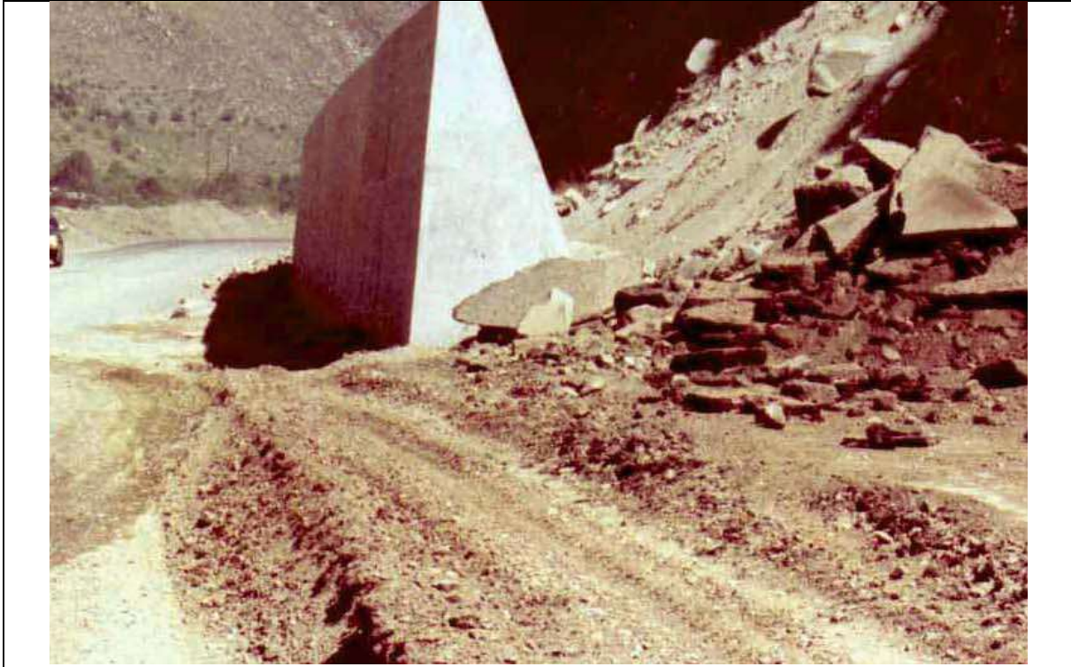
Foto II. 8. Ejemplo de la estabilización de laderas o taludes mediante el uso de barreras o muros de concreto.
