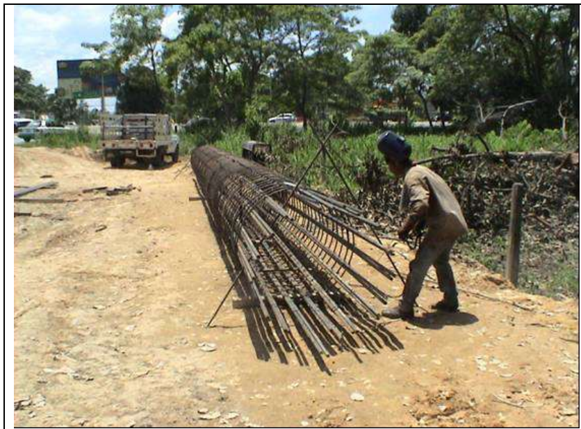
Foto II. 3. Ejemplo de armado de acero para columna puente.
