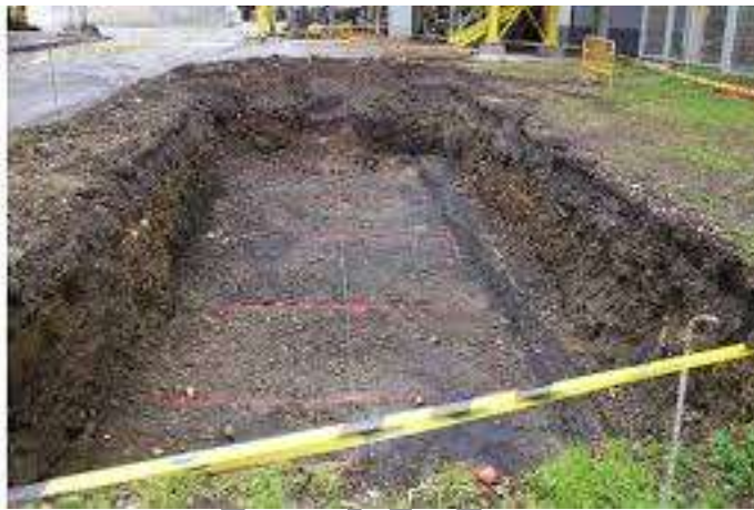
Foto VI. 14. Ejemplo de delimitación de superficies de obra con cinta.
