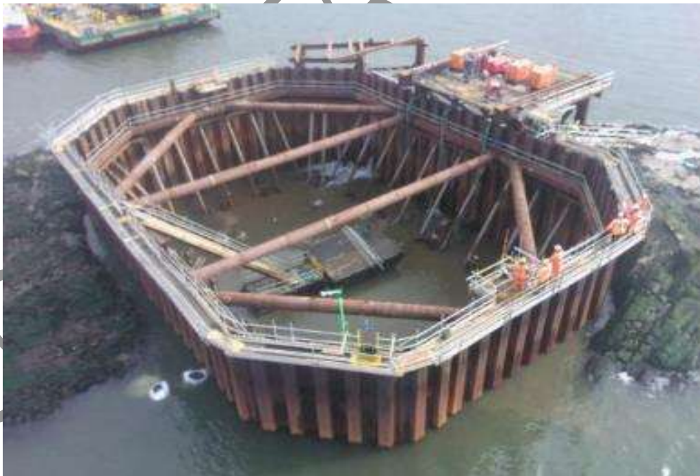
Figura VI. 14. Ejemplo de Tabla Estacado al centro de Rio para desplante de cimentación.
