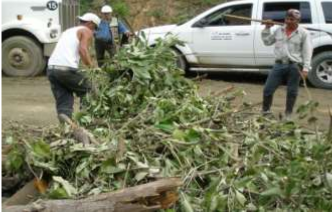
Foto VI. 7 Separación de ramas producto del desmonte, de otros materiales reutilizables.
