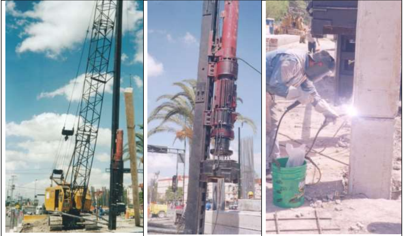
Foto II. 2. Ejemplos de hincado de pilotes.
