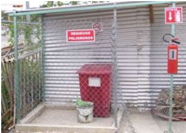
Foto VI. 9 Sitio de acopio y almacenamiento temporal de residuos peligrosos, en donde se indica el tipo de material resguardado en el área y extintor señalado adecuadamente.
