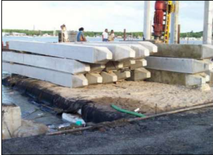
Foto II. 1. Ejemplo de pilotes fabricados “in situ”
