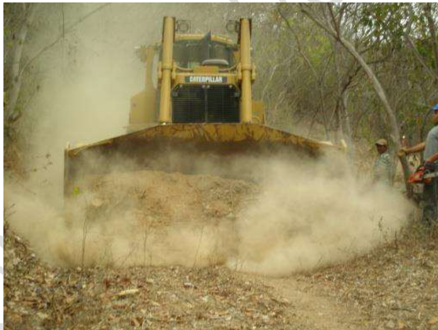
Foto V. 1 Ejemplo de dispersión de polvo y gases generados por la operación de maquinaria durante los trabajos de despalme de un Proyecto.
