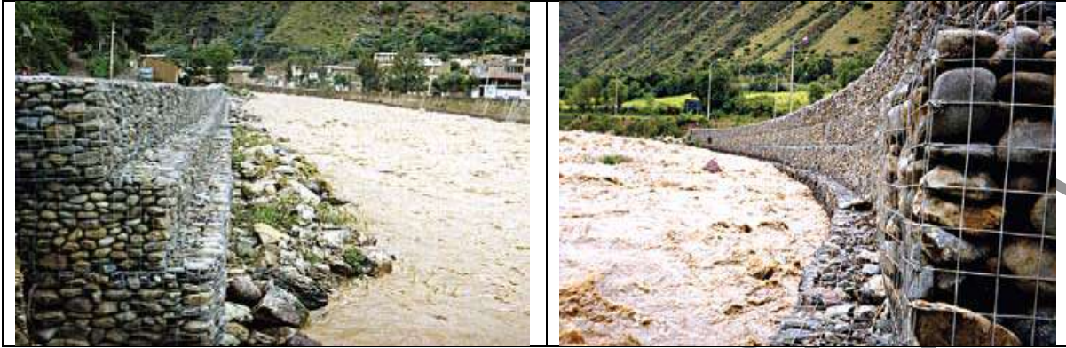
Foto VI. 22. Ejemplo de colocación de gaviones instalados en las márgenes de un río.
