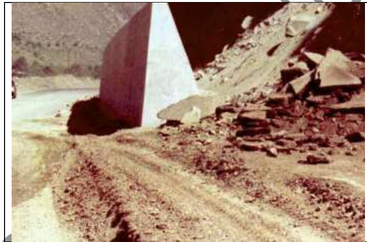
Foto VI. 24. Ejemplo de la estabilización de laderas o taludes mediante el uso de barreras o muros de concreto.
