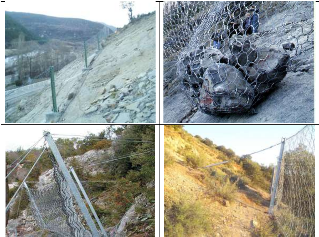
Foto II. 7. Ejemplos de la estabilización de los taludes a base del sistema de mallas metálicas.
