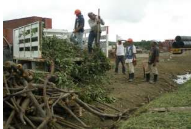
Foto VI. 8 Selección de materiales que serán reutilizables (troceado y reúso para el mejoramiento de suelo).
