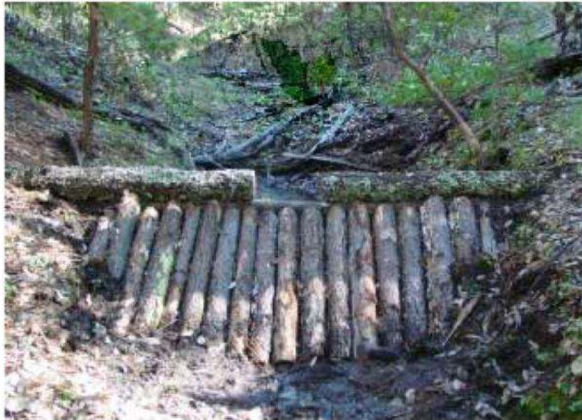
Foto VI. 16. Uso de presas de morillos para la retención de sedimentos.
