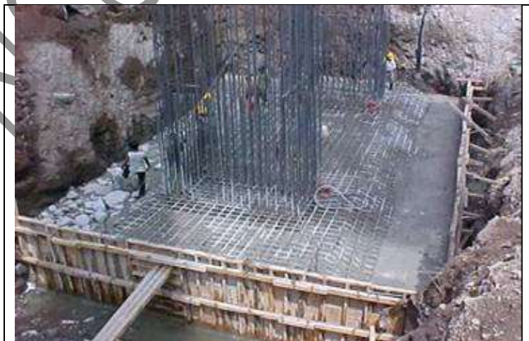
Foto VI. 21. Ejemplo de colado de zapata de apoyo fuera del margen de un río.
