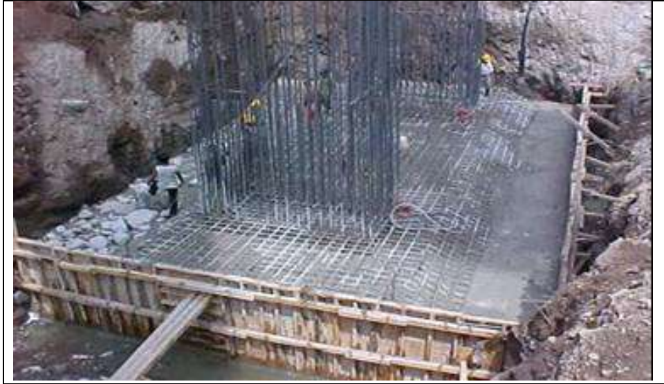
Foto II. 4. Colado de zapata de apoyo fuera del margen del río.
