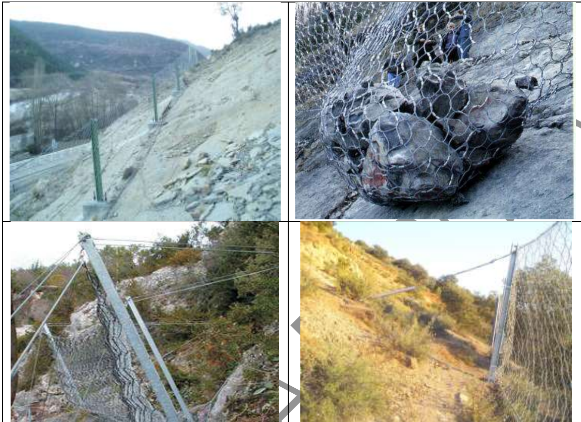
Foto VI. 23. Ejemplos de la estabilización de los taludes a base del sistema de mallas metálicas.
