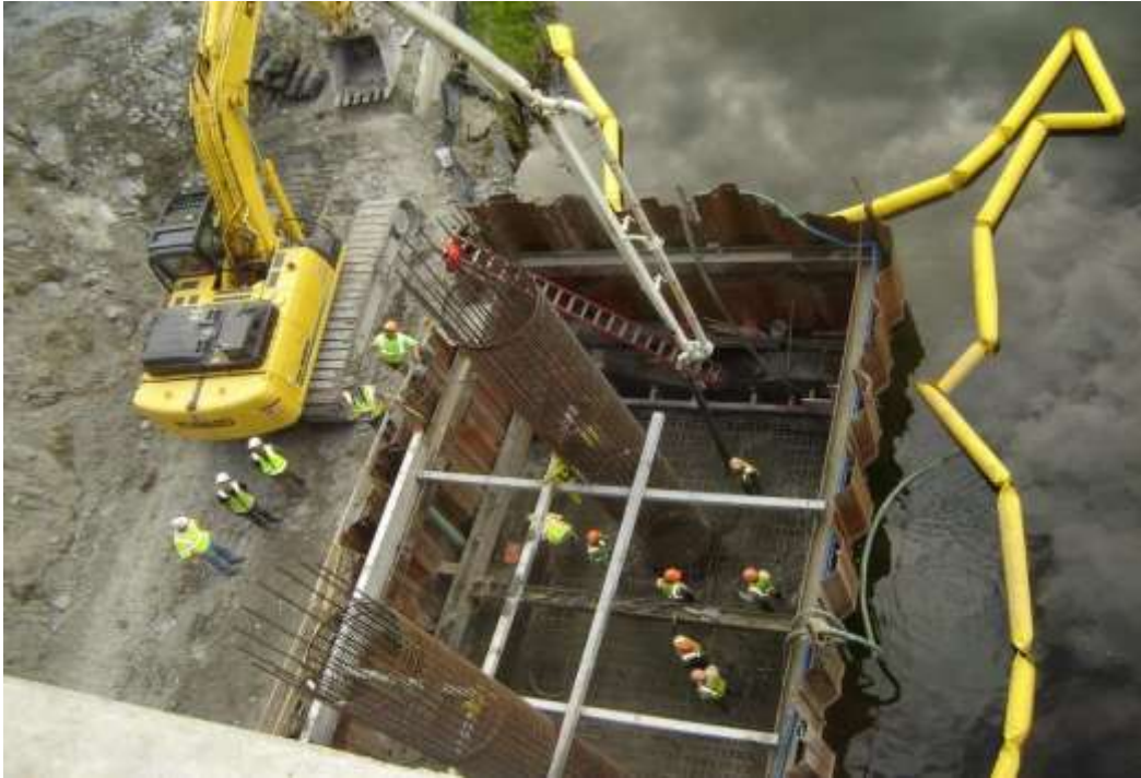
Figura VI. 13. Ejemplo de Tabla Estacado en margen de Rio para desplante de cimentación.
