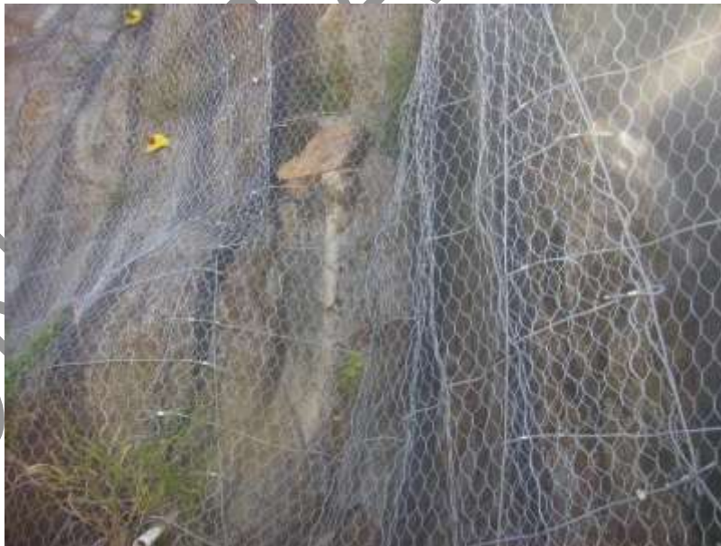
Foto VI. 15 Malla para retención de caídos:
