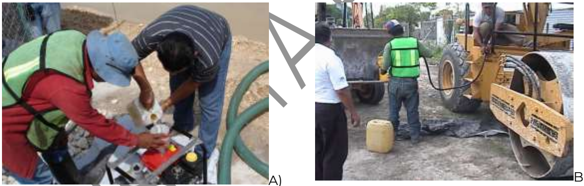
Foto VI. 12 Ejemplo de carga de combustible in situ . A) Llenado de gasolina de una bomba para extraer el agua, debajo lado izquierdo se puede observar el uso de una lona para prevenir posibles derrames de combustibles sobre el suelo; B) Carga de diésel a un vibro compactador usando una lona sobre el suelo natural para evitar posibles derrames de combustible y el uso de equipo de protección personal adecuado
