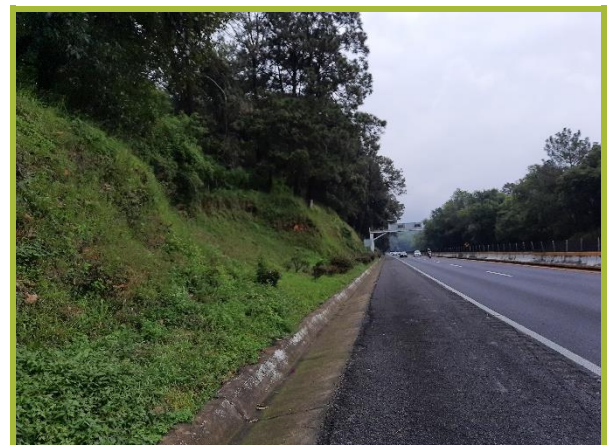
Fotografía #20: Vista del Derecho de Vía actual
