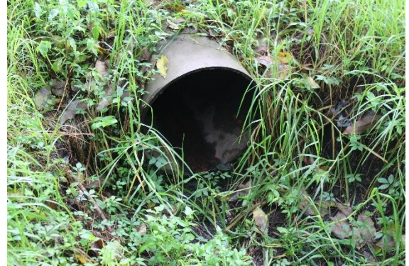
Fotografía #19: Obra de drenaje, posible paso de fauna
