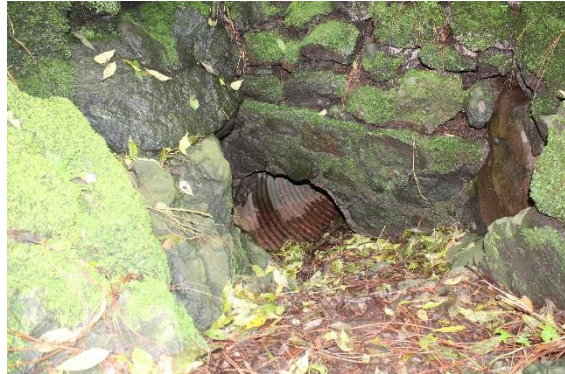
Fotografía #15: Obras de drenaje, posible paso de fauna
