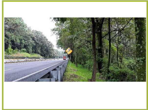
Fotografía #24: vista del derecho de vía y la vegetación en el sitio
