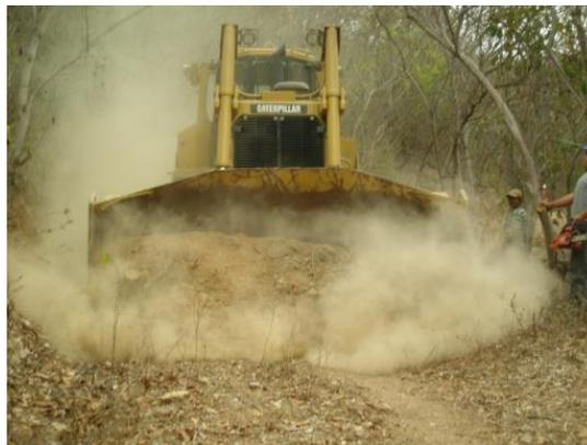
Foto 5. 1 Ejemplo de dispersión de polvo y gases generados por la operación de maquinaria durante los trabajos de despalde de un Proyecto.
