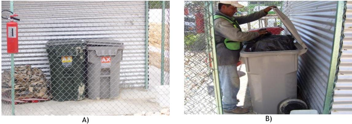
Foto 6. 5 Ejemplo de la buena disposición de los residuos sólidos. A) Contenedores adecuados para el confinamiento temporal de los residuos sólidos urbanos generados; B) Buenas prácticas por parte de los trabajadores de la obra.
