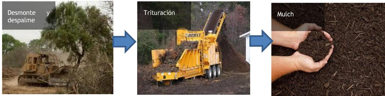
Figura 6. 6. Ejemplo del manejo de los residuos generados por el desmote y despalme.
