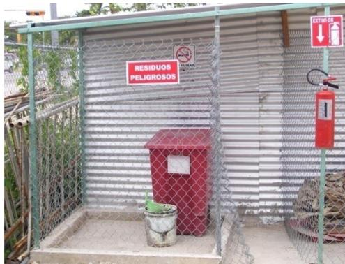
Foto 6. 10 Ejemplo de un Almacén de acopio temporal de residuos peligrosos, en donde se indica el tipo de material resguardado en el área y extintor señalado adecuadamente.
