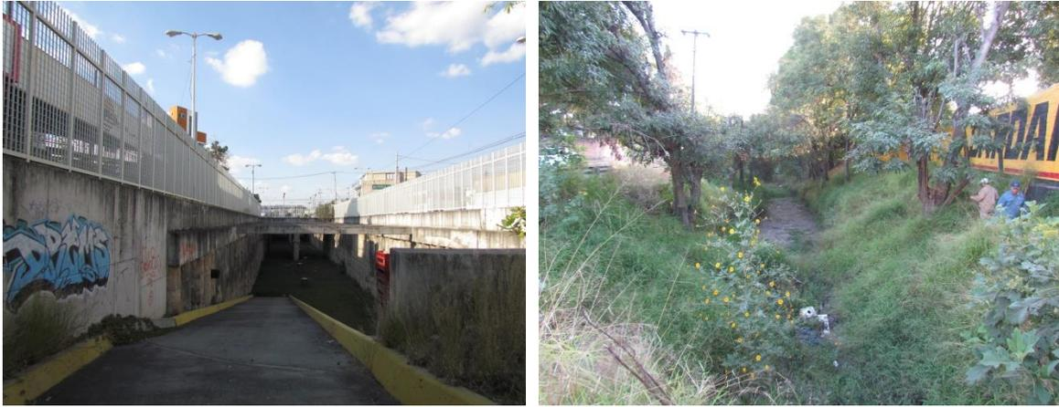
Figura II-50. Rehabilitación y ampliación del tramo norte del Canal Santa Catalina, Zapopan. Modificación de la sección trapecial actual del canal Santa Catalina por una sección rectangular de aproximadamente  $B=13$  m y  $h=8$  m
