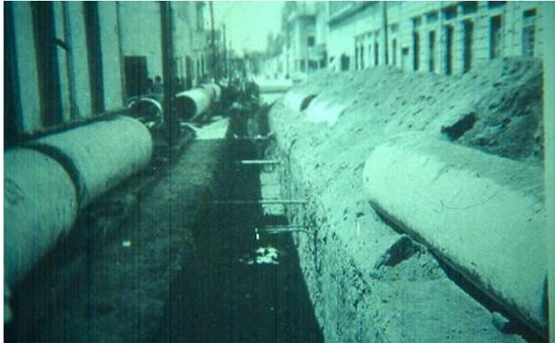
*Figura II-5. Colectores prefabricados*
