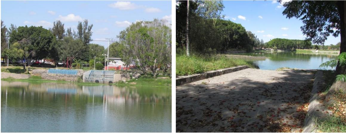
Figura II-43. Ampliación de vaso regulador El Dean. Ampliación de la capacidad de regulación del vaso regulador El Dean, para pasar de 240 mil a 506 mil m<sup>3</sup>.
