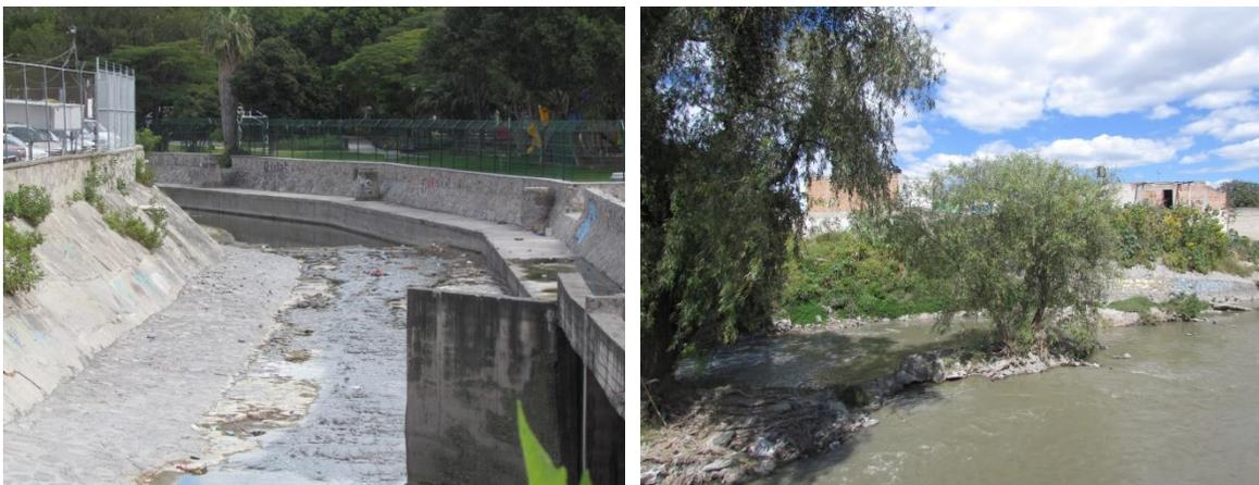
Figura II-40. Río Atemajac Tramo Alcalde-Federalismo. Colectores sanitarios marginales al cauce, estructuras de separación de flujos, muros de encauzamiento y afine del fondo rocoso
