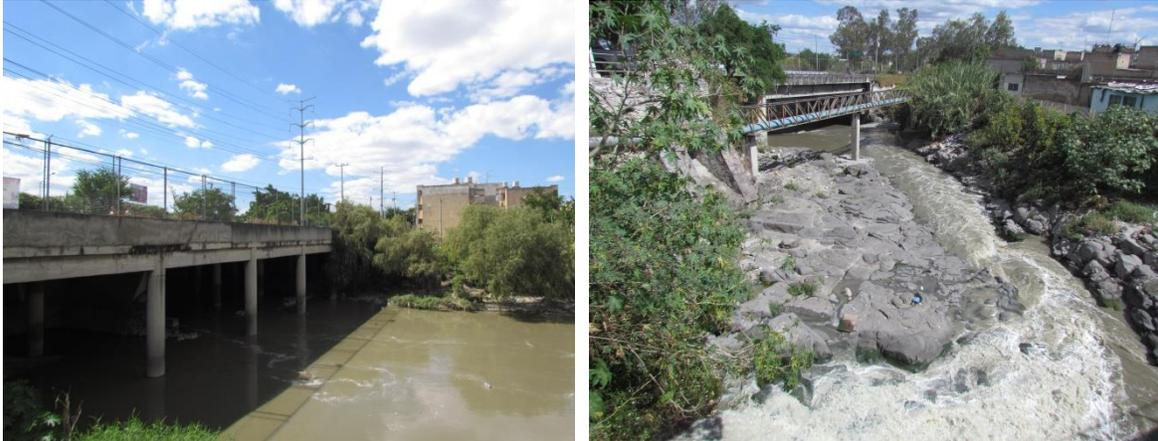
Figura II-41. Río Atemajac Tramo Periférico-Alcalde. Colectores sanitarios marginales al cauce, estructuras de separación de flujos y afine del fondo rocoso
