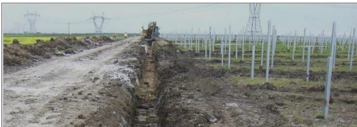
Figura II.14. Vista de las zanjas (Foto ilustrativa)
