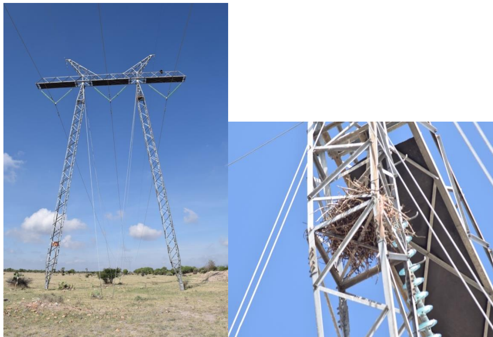
Fotografía IV. 18. Torre de transmisión eléctrica en donde anidan cuervos ( Corvus corax ) en terrenos aledaños al Área de Influencia.
