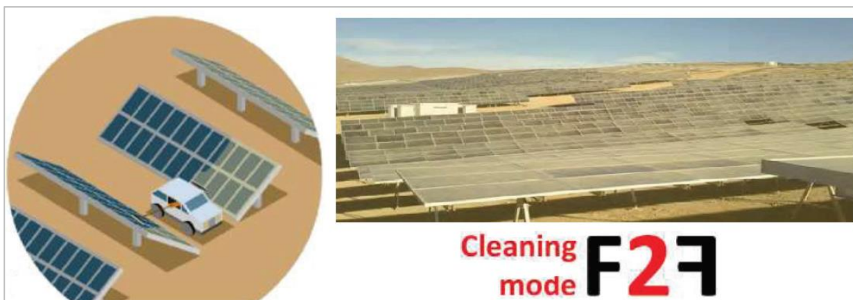
Figura II. 19. Modo de limpieza F2F, para los paneles fotovoltaicos.
