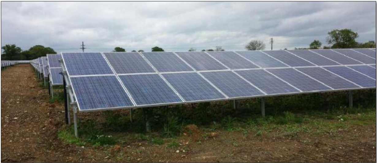
Figura II.13. Estructuras de soporte (Foto ilustrativa)
