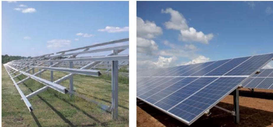
Los módulos fotovoltaicos deberán de ser anclados a la estructura mediante grapas de sujeción normalizadas y que aseguren el correcto anclaje y fijación a la estructura bajo las condiciones de carga de viento. Deberá preverse la interconexión de los marcos de los módulos fotovoltaicos con la estructura metálica con el fin de poner a tierra el sistema de generación. Los strings o series se dispondrán con 4.5 metros de separación para permitir que la instalación mecánica se adapte lo
