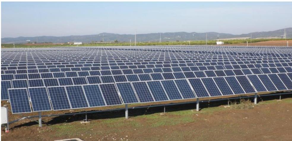
En la imagen anterior se observa el acomodo de los módulos solares, el sistema de postería hincada en terreno natural para soporte de la estructura que sostiene los módulos solares, sin cimentación ni obra civil, lo que permitirá el crecimiento de cobertura vegetal del suelo, con vegetación de pastizal, para disminuir la generación de polvos, evitar la erosión y favorecer la fijación de carbono. Las dimensiones de los bloques se muestran en las figuras siguientes:
