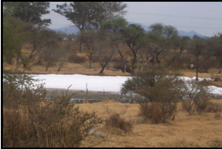
Figura 26 : Agua corriente debajo de la cortina de La Presa.
