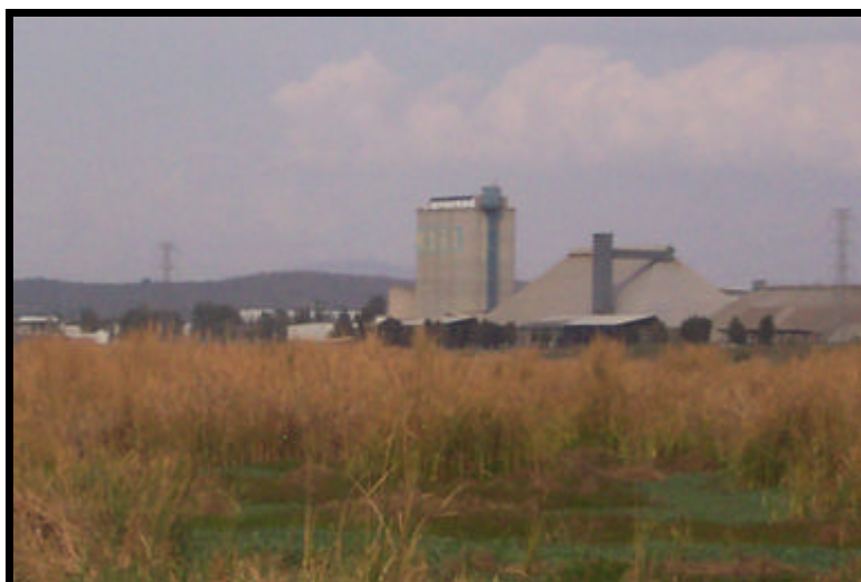
Figura 29 : Vista hacia el lado Oriente de la Presa, presencia de lirio y tule.
