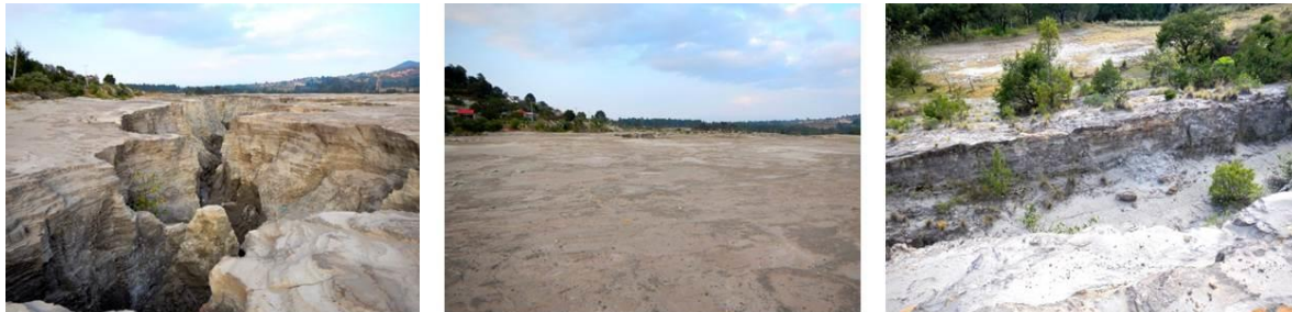
Condición actual del grado de erosión entre los cadenamientos 18+600 y 19+200
