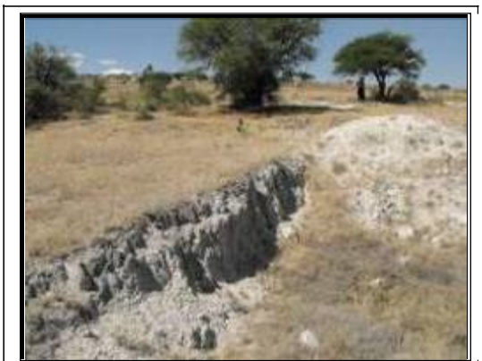
a) Erosión hídrica en Leptosol muy intemperizado
