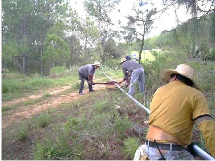
Ejemplo gráfico de la unión de la tubería de fierro galvanizado de forma manual.
