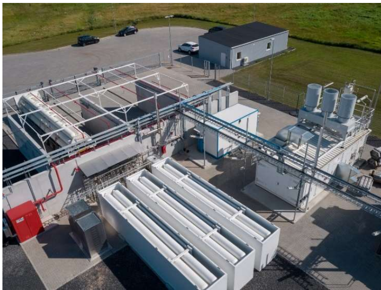
20. Figura II. 30. Tanques En Forma De Tubos Para El Almacenamiento A Alta Presión
