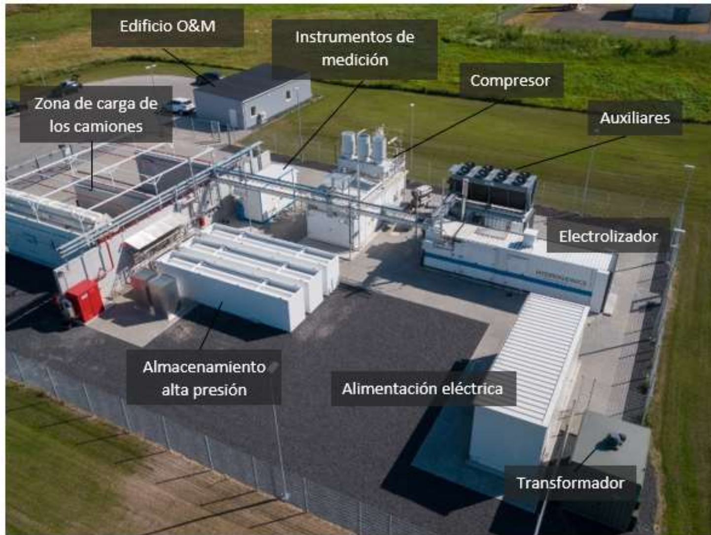
Figura II.9. Componentes de una planta de generación de hidrógeno verde, ejemplo de planta existente
