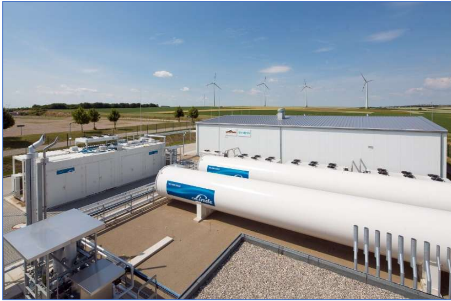
18. Figura II. 28. Tanques cilíndricos de almacenamiento intermedio de 82 m 3 entre 20 y 80 bars
