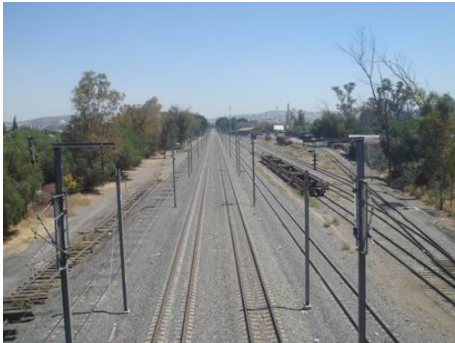
FIGURA 38. VISTA PLATAFORMA JM DESDE PS EJIDO. FINAL DEL TRAYECTO (VISTA DIR. MÉXICO).A LA IZDA., PQUE. ALCANFORES. JM 243+600
