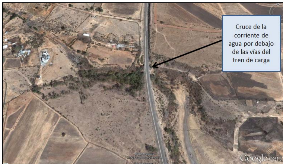
FIGURA 115. DE ACUERDO CON ESTA IMAGEN OBTENIDA DEL PROGRAMA GOOGLE EARTH, SE ALCANZA A OBSERVAR QUE LA CORRIENTE DE AGUA QUE PROVIENE DE LA PRESA 1 ATRAVIESA POR DEBAJO DE LAS VÍAS DEL TREN DE CARGA MEDIANTE ALGUNA OBRA DE DRENAJE PARA CONTINUAR SU CAMINO HACIA LA PRESA 2.
