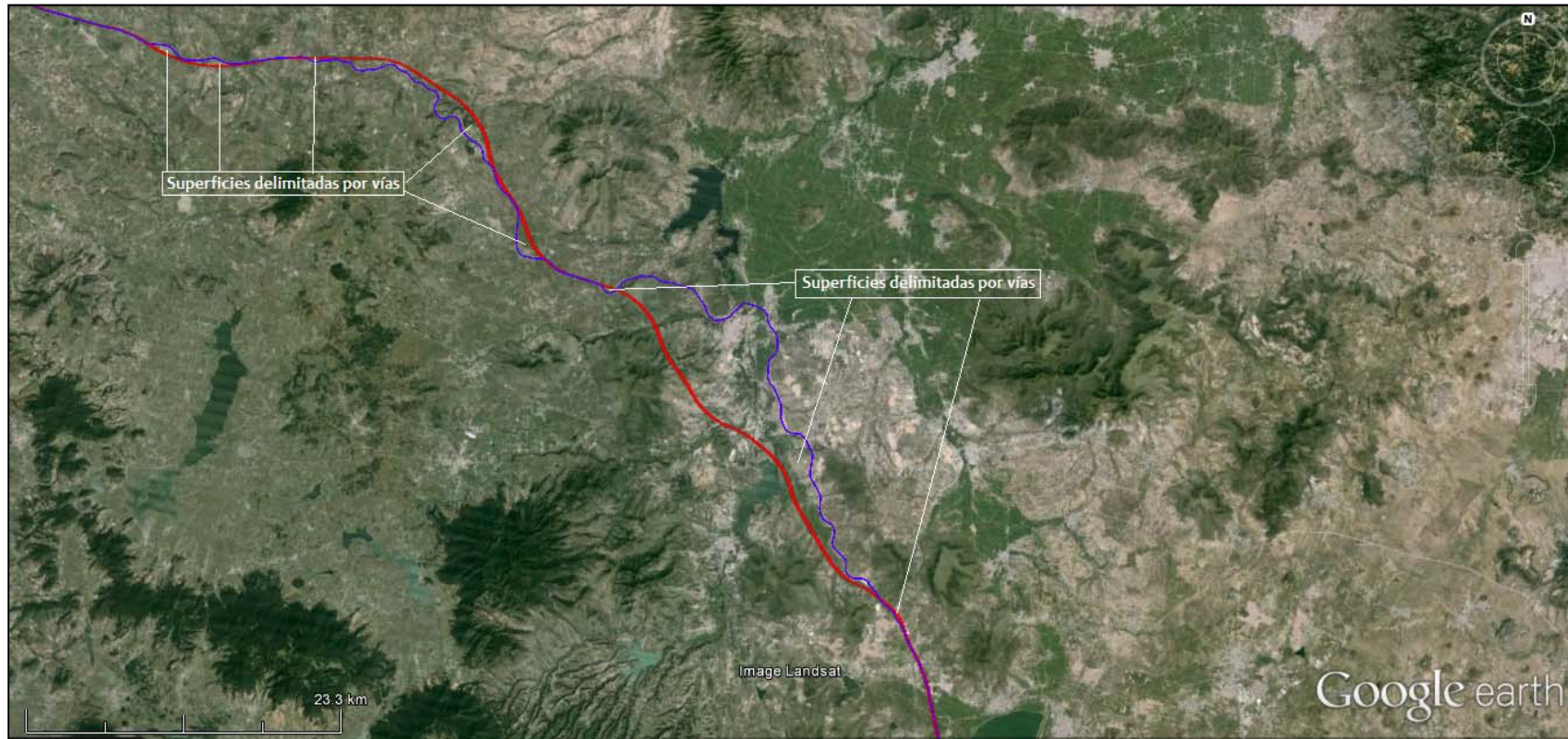
FIGURA 109. TRAZO DEL TREN DE PASAJEROS MÉXICO QUERÉTARO (LINEA EN COLOR ROJO) EN EL SEGMENTO QUE VA DEL KM 46+500 AL KM 140+000 DEL CADENAMIENTO DE LA VÍA QUE EXISTE ACTUALMENTE (LINEA AZUL). COMO ES POSIBLE OBSERVAR, CIERTAS SUPERFICIES QUEDARÍAN DELIMITADAS POR EL TRAZO DE LA ACTUAL VÍA (EN AZUL) Y EL TRAZO DE LA NUEVA VÍA (EN ROJO).
