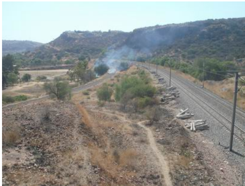
FIGURA 34. VISTA LÍNEA B Y JM EN TRAMO DESCENDENTE POR CAÑADA. AL FONDO, TÚNEL EXISTENTE. JM 234+500, APROX.
