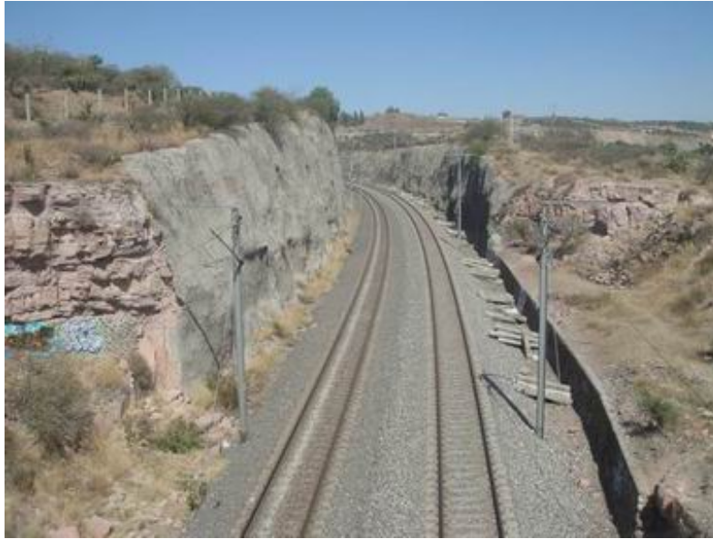
FIGURA 33. VISTA JM EN CORTE POR CAÑADA (VISTA DIR. MÉXICO). JM 234+000, APROX.
