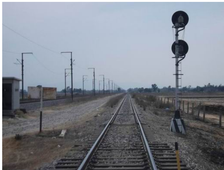
FIGURA 19. PLATAFORMA FERROVIARIA DESDE LÍNEA A. A LA IZDA, VÍAS JUÁREZ MORELOS (VISTA DIR. SUR). JM 41+800
