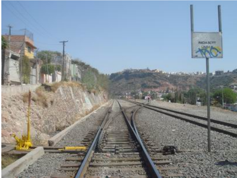
FIGURA 35. VISTA CONFLUENCIA LÍNEA B CON MORELOS (VISTA DIR. MÉXICO). JM 239+000
