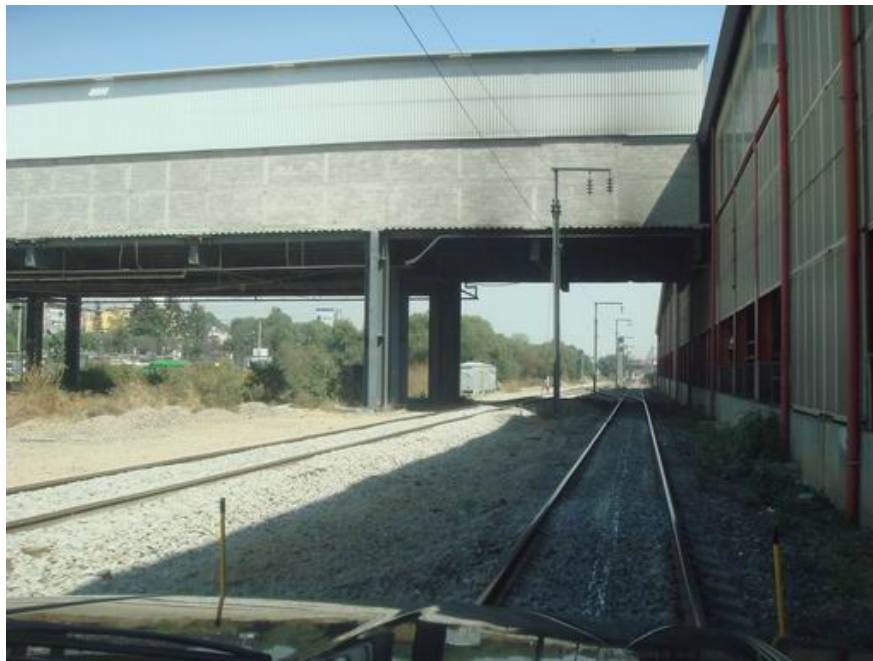
FIGURA 16. ZONA DE ACTUACIÓN LADERO IZQUIERDO LECHERÍA
