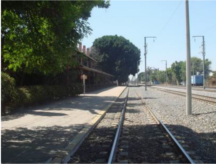
FIGURA 37. VISTA PLATAFORMA JM DESDE ESTACIÓN ANTIGUA DE QUERÉTARO. JM 242+600
