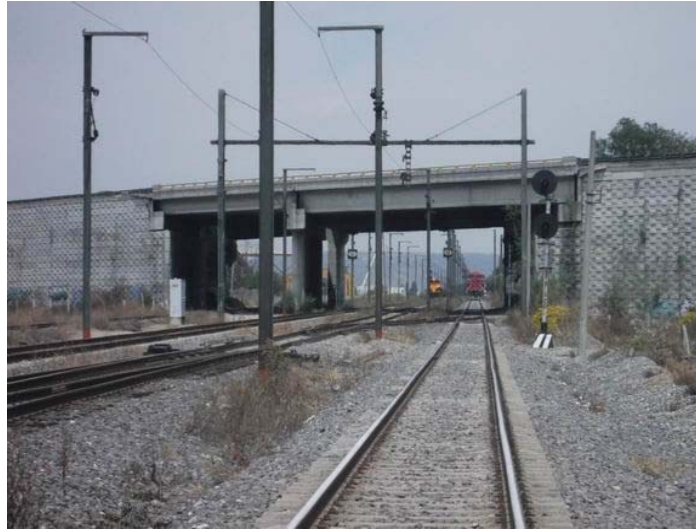
FIGURA 21. PASO SUPERIOR CIRCUITO EXTERIOR MEXIQUENSE. JM 42+080
