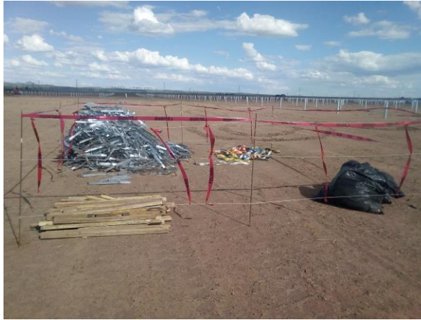
Figura VI.15 Ejemplo de acopio temporal de residuos de manejo especial. Fuente: Elaboración propia
