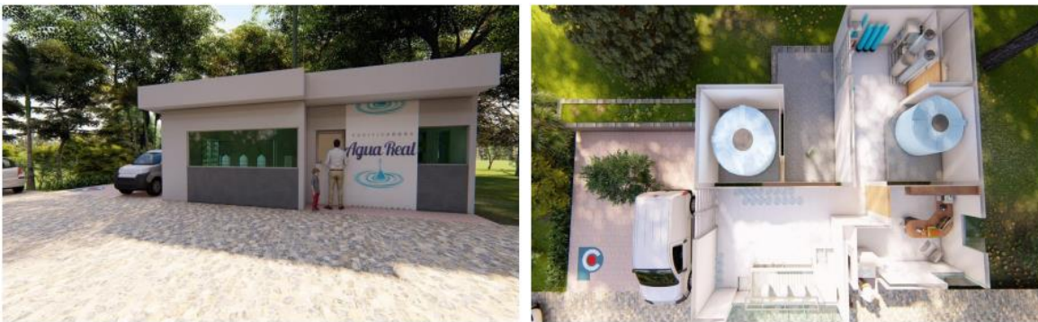
Figura V.4 Planta purificadora de agua en la localidad Arrayanal. Fuente: Imágenes proporcionadas por la promotora.
