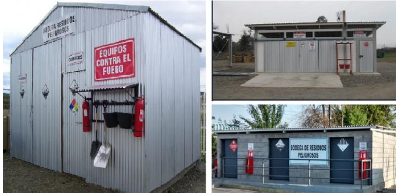
Figura VI.14 Ejemplo de almacenes temporales de residuos peligrosos. Fuente: Obtenida de internet
