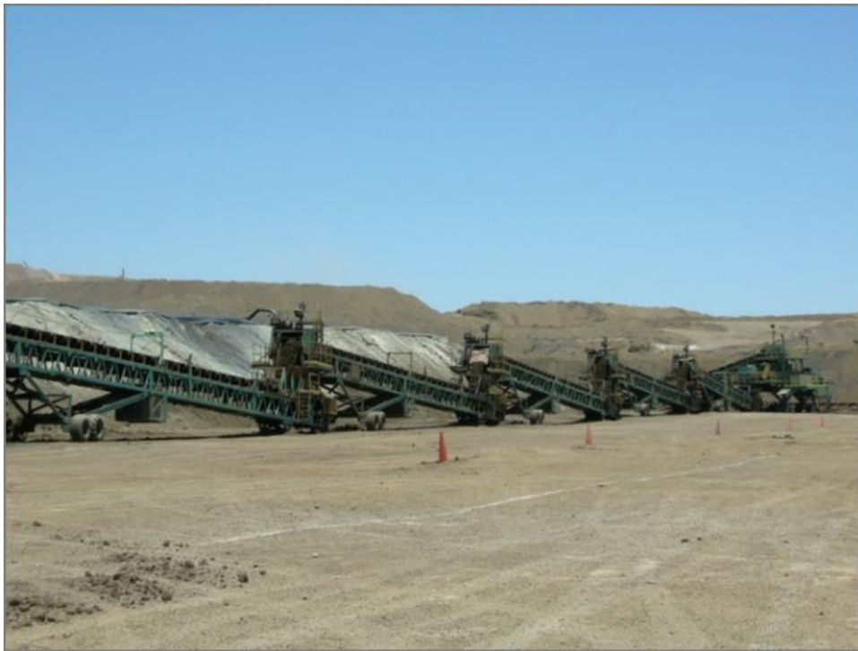
Figura VII. 13 Transporte de jal en bandas transportadoras con un porcentaje de humedad que evitará la suspensión de polvos.
