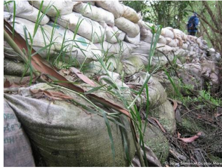
Figura 8. Ejemplo de la colocación de diques con sacos de tierra.
