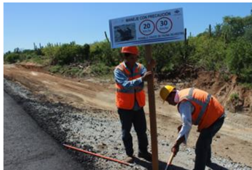
Figura 6. Ejemplificación de la instalación de un letrero temporal
