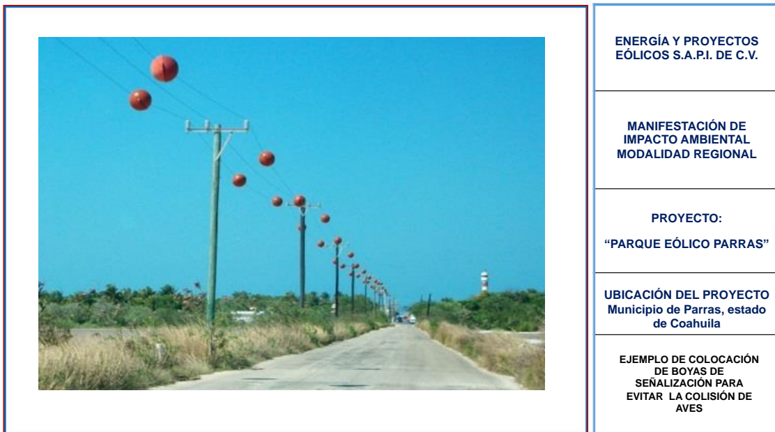
Figura VI. 12. Ejemplo de colocación de boyas de señalización para evitar la colisión de aves
