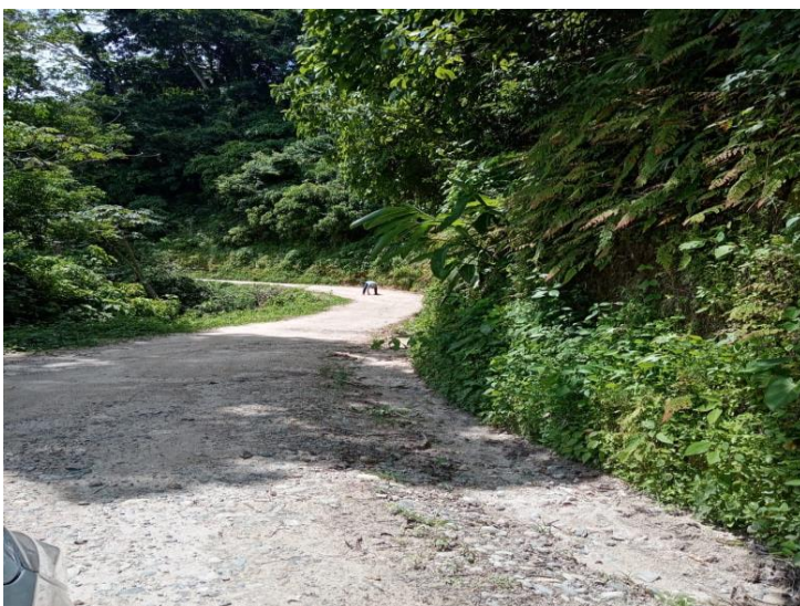
Figura 4. Curva existente a lo largo del camino, sin vegetación arbórea dentro del ancho de corona
