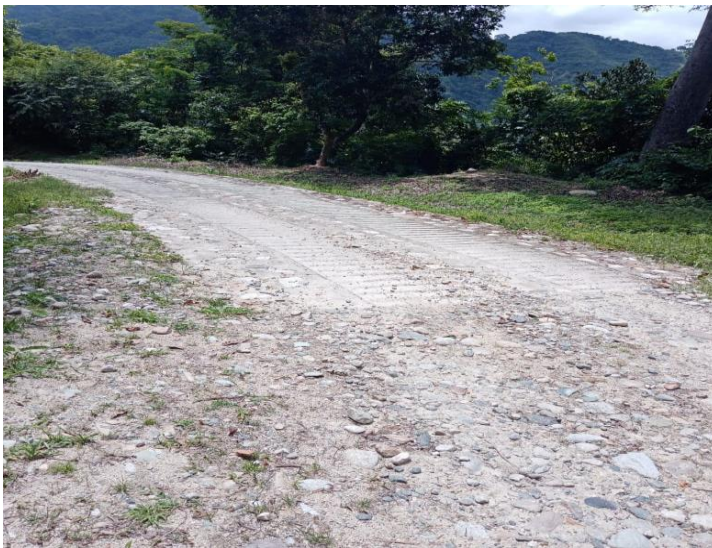
Figura 6. Parte del camino donde existe concreto hidráulico
