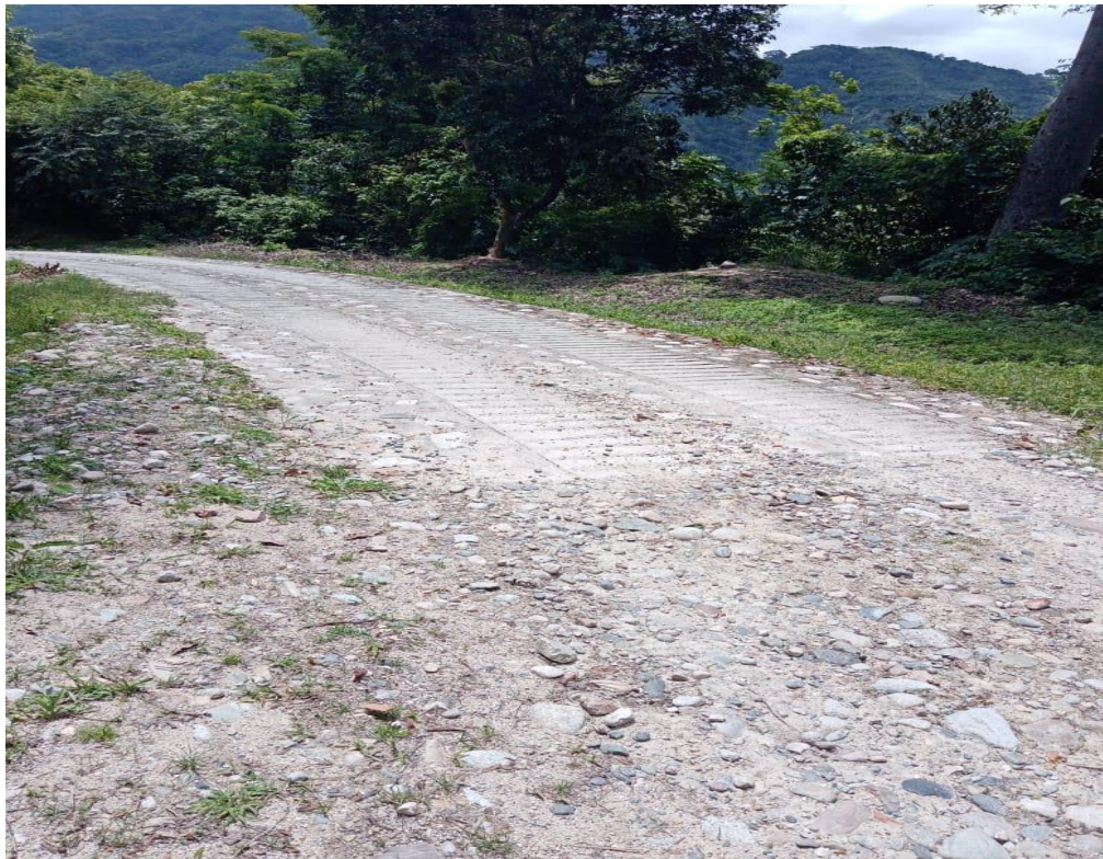
Figura 2. Tramo del camino con huellas de concreto
