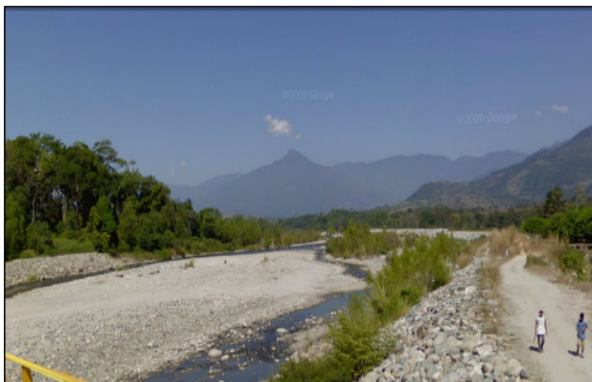
Foto II.5.- Vista general del río Vado Ancho en las inmediaciones del sitio del proyecto del CFRS-Chiapas.
