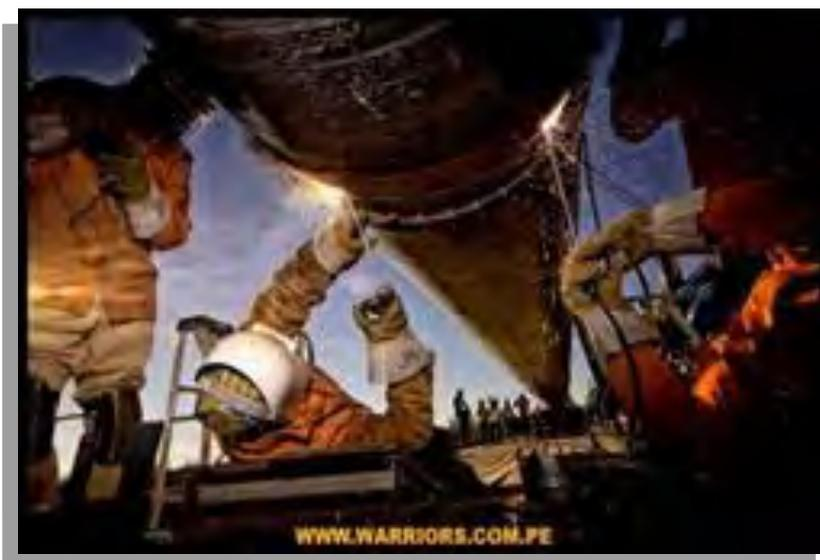
**Figura II.13** Soldado de tubería.
