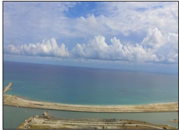
Fotografía 4. Vista general de la playa frente al lote M1.
