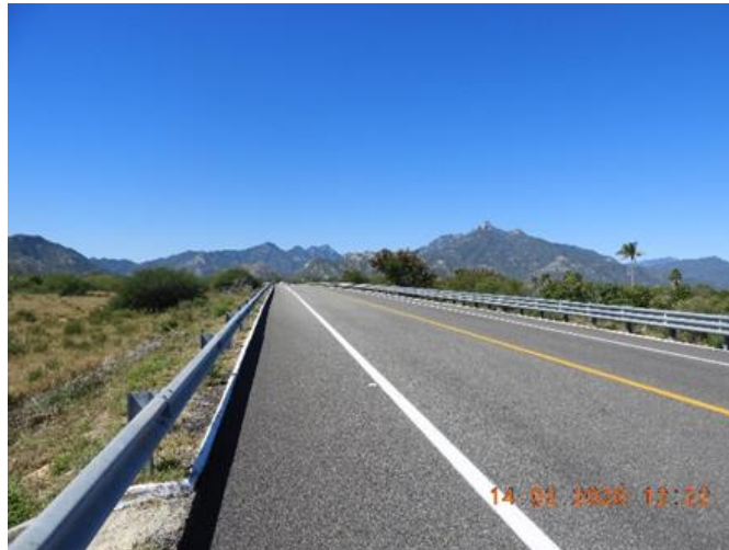
Figura IV.40 Vista de la carretera federal Highway 1D aledaña al proyecto de la ampliación del aeropuerto en cuestión
