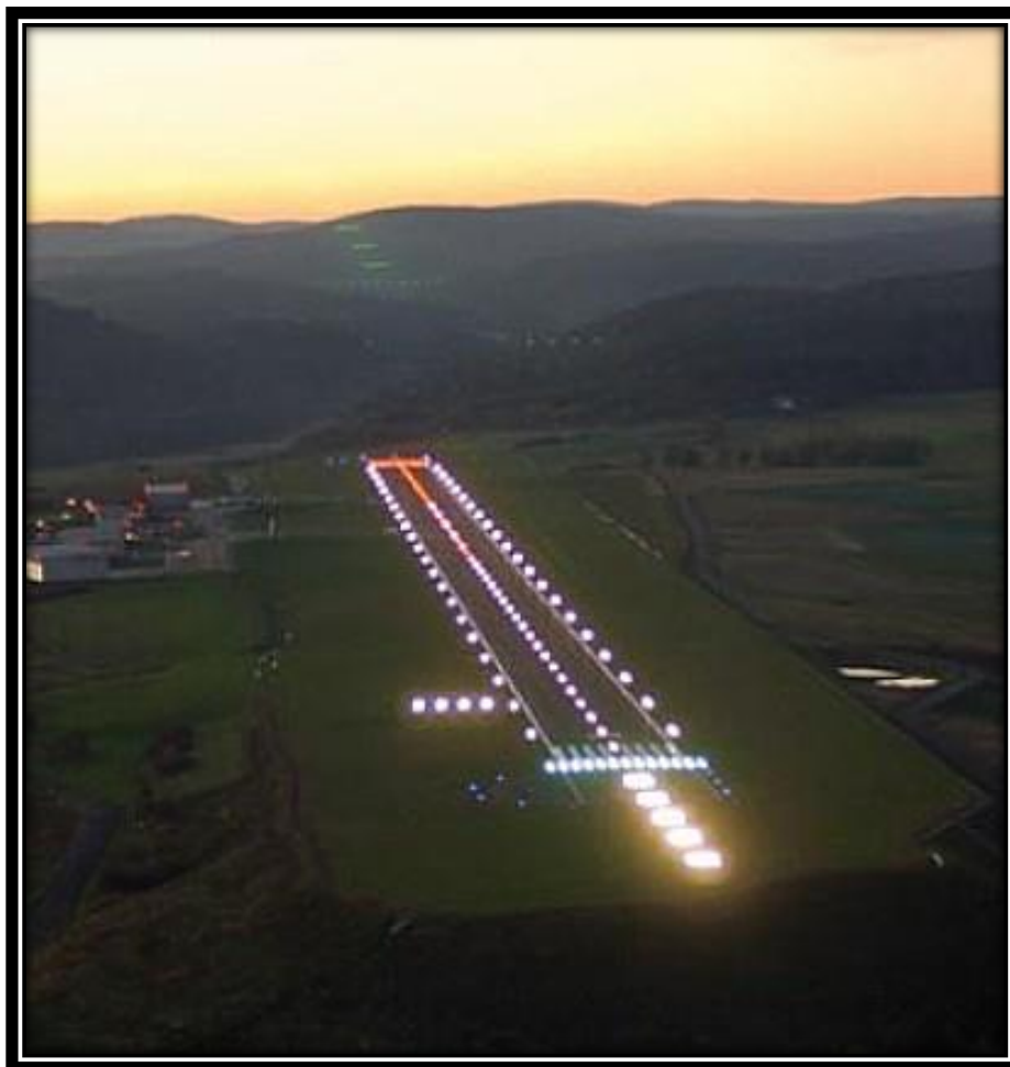
Figura II.60 Ejemplo de la iluminación de la Pista
