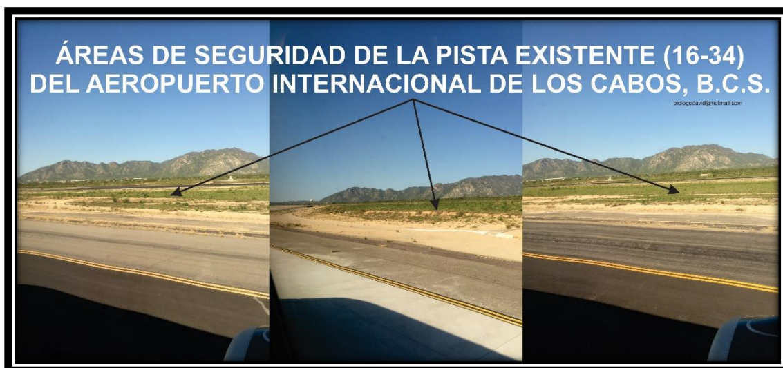
Figura II.16 Vista de las áreas de seguridad de la Pista existente (16-34)
