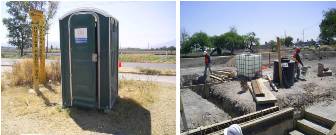
Figura II- 1 Se instalarán sanitarios portátiles y contenedores para agua
