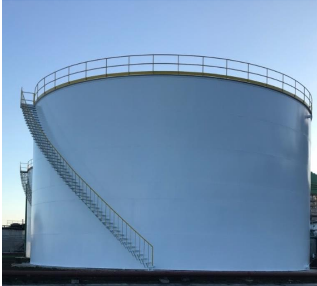
Figura II.22. Tanques para agua de 1,000 m 3
