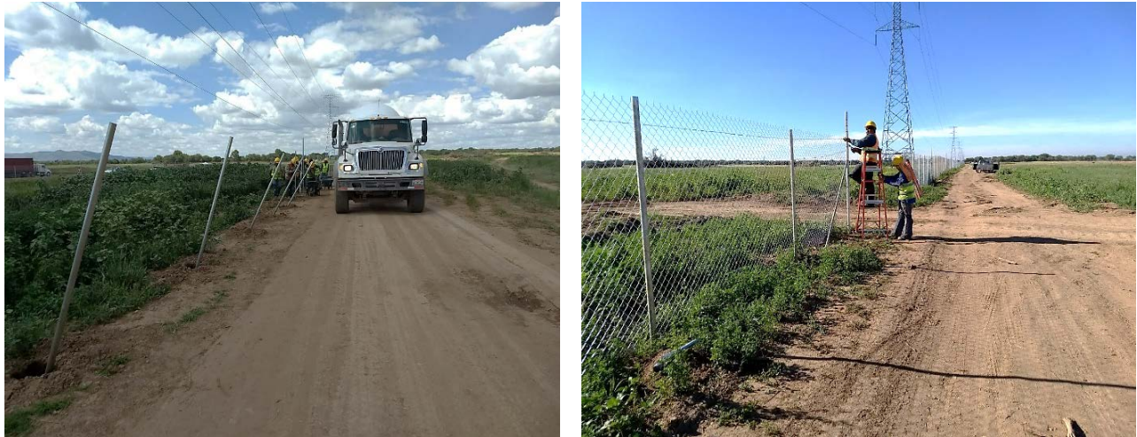
Figura II.11. Vallado perimetral que será usado para la planta Tepezalá I.
