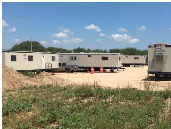
Figura II.15. Modelo de contenedores para las instalaciones provisionales de obra.
