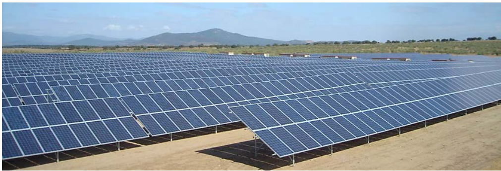
Figura II.9. Posición de los seguidores solares por la mañana.
