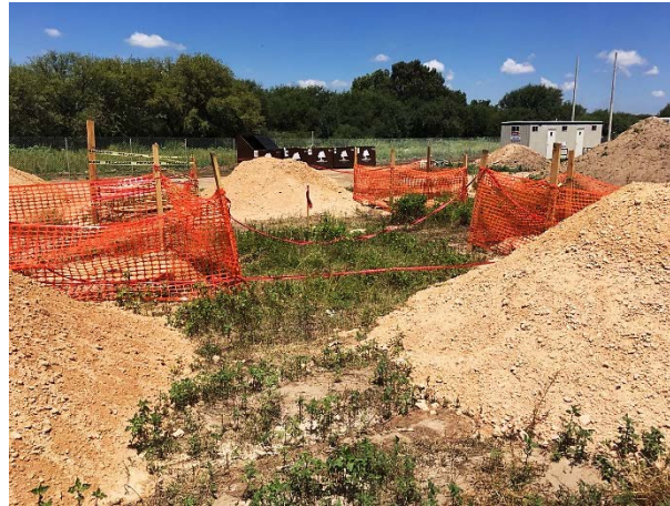
Figura II.33. Excavación para construcción de bases de cimentación de las torres de interconexión.
