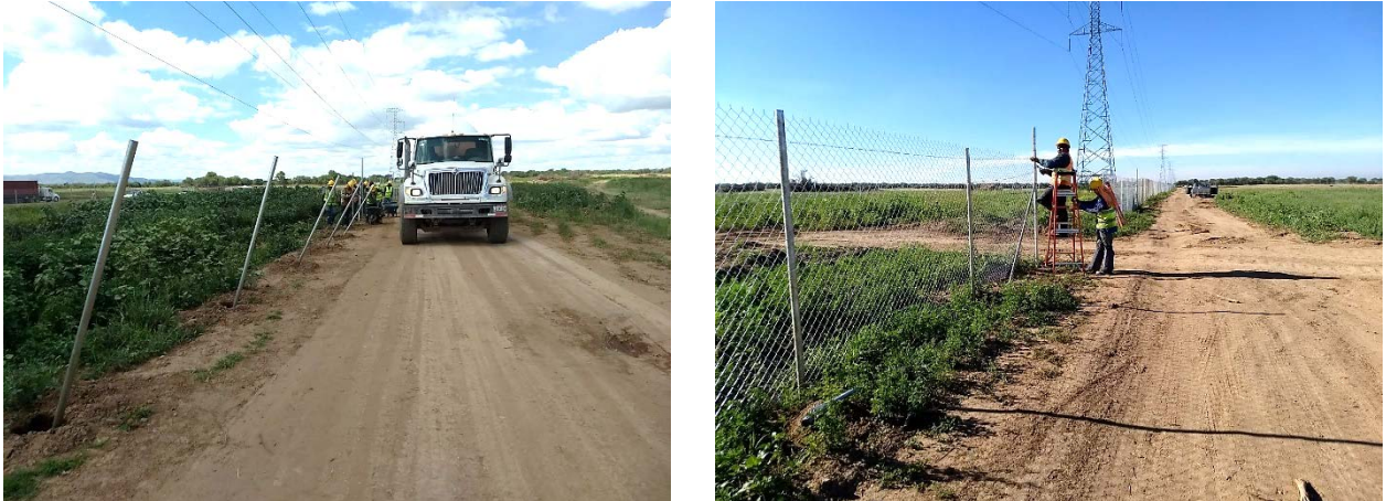
Figura II.28. Ejemplo del cercado perimetral con malla de alambre galvanizado.
