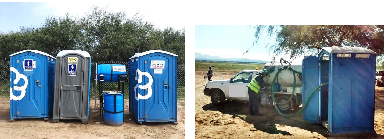
Figura II 27. Sanitarios móviles que serán usados durante la etapa de preparación del sitio y construcción del proyecto.
