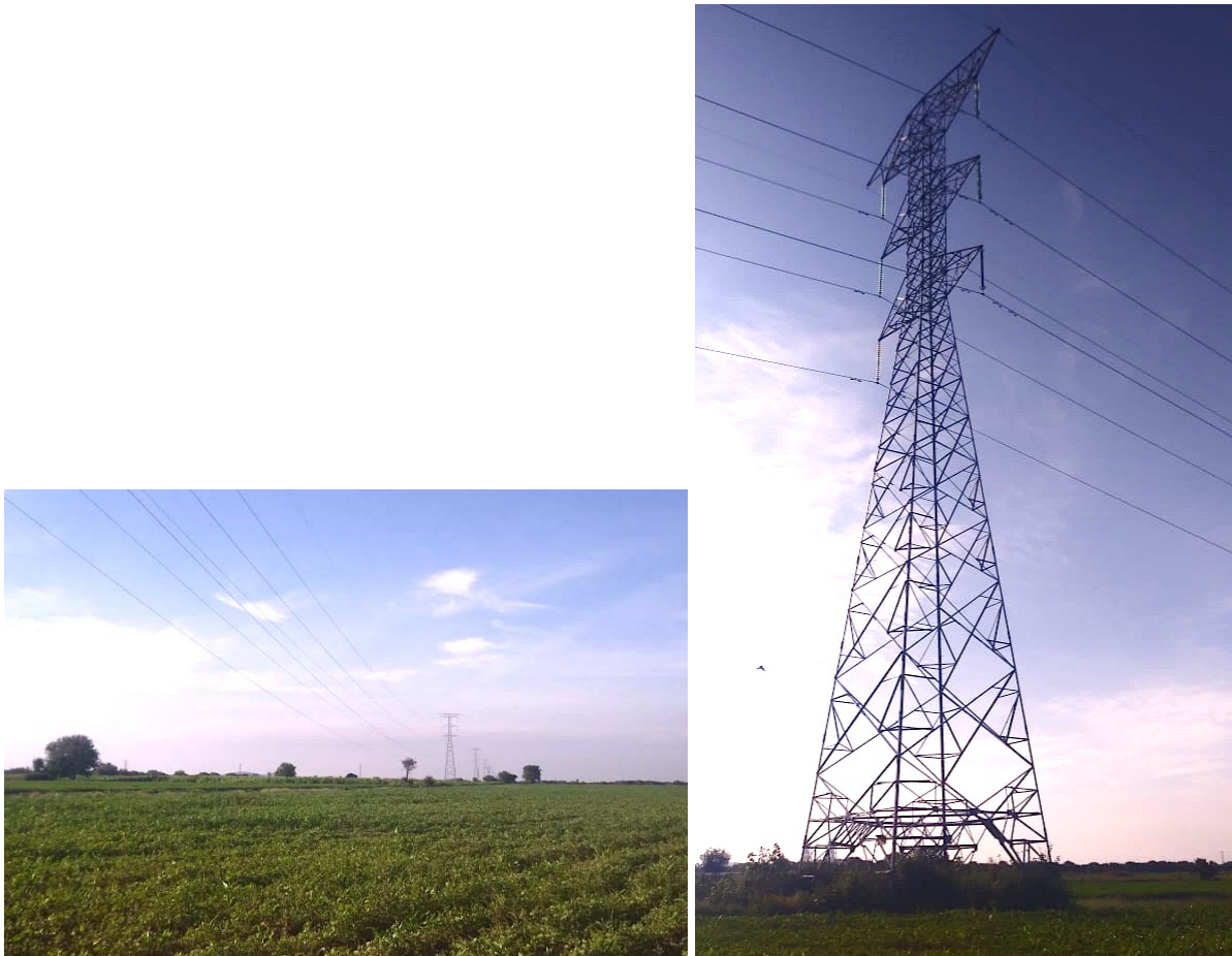
Figura IV.18. Torres de transmisión eléctrica en el SAR Tepezalá I.
