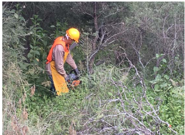
Figura II.16. Remoción de vegetación con equipo mecánico y uso de equipo de protección personal (EPP).
