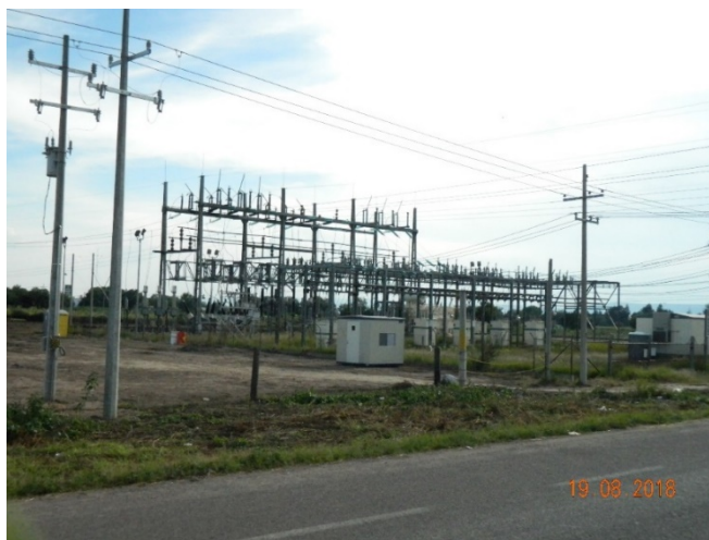
Figura IV.19. Subestación eléctrica de San Antonio, donde se interconectará la Planta Solar Tepezalá I.
