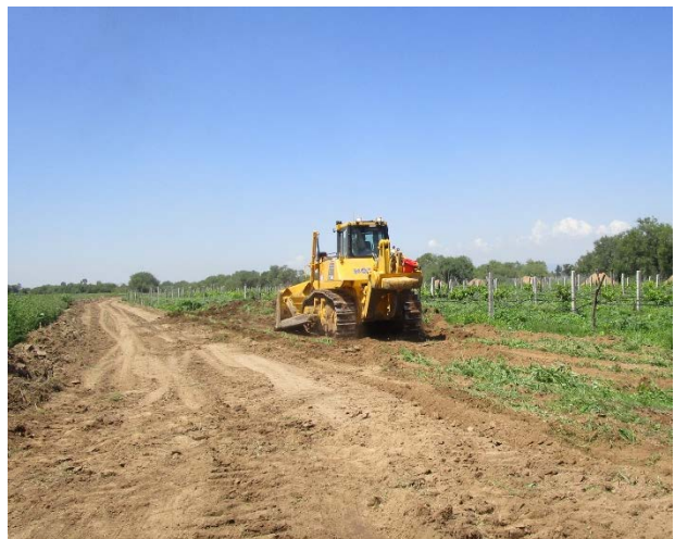
Figura II.17 Trazo u nivelación durante la etapa de preparación del sitio de proyecto.
