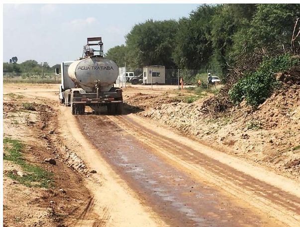
Figura II 26. Riego de caminos con agua tratada para evitar el desprendimiento de partículas de polvo.
