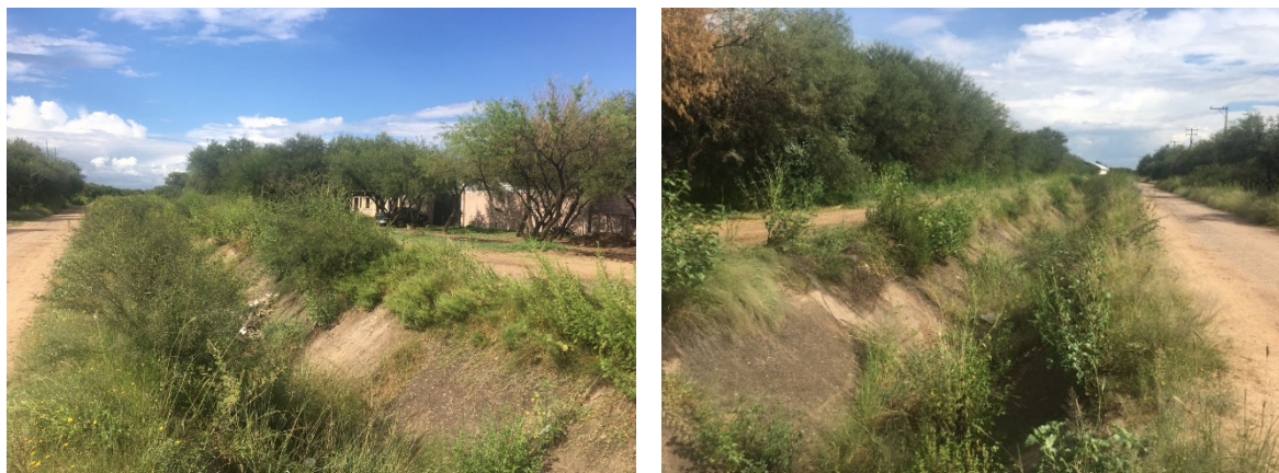
Figura IV.13. Canal de riego agrícola que forma parte del Distrito de Riego 001 Pabellón que se ubica dentro del SAR.
