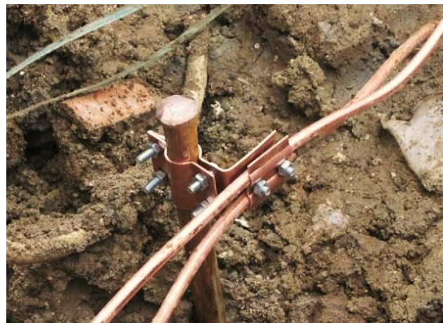
Figura II.31. Instalación de cable desnudo de cobre (35 mm 2 ) para sistema de tierras.
