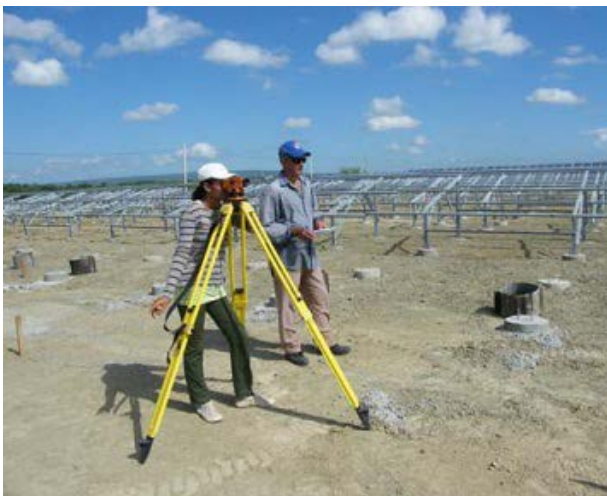
Figura II.17 Trazo u nivelación durante la etapa de preparación del sitio de proyecto.
