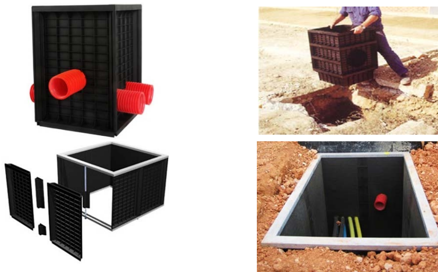
Figura II.21. Instalación de arquetas para canalizaciones subterráneas.
