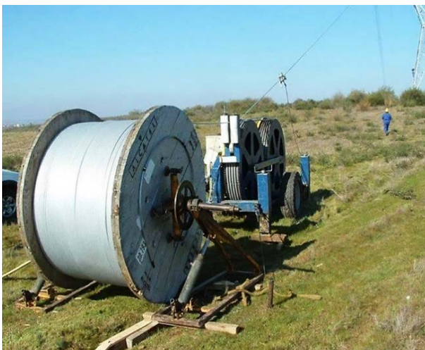
Figura II.37. Tendido de cable de guarda para las torres de interconexión de alta tensión.
