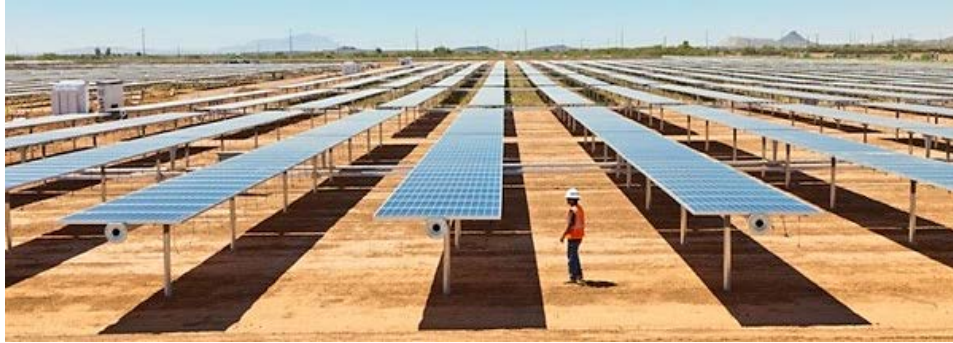
Figura II-8. Posición horizontal de los seguidores solares
