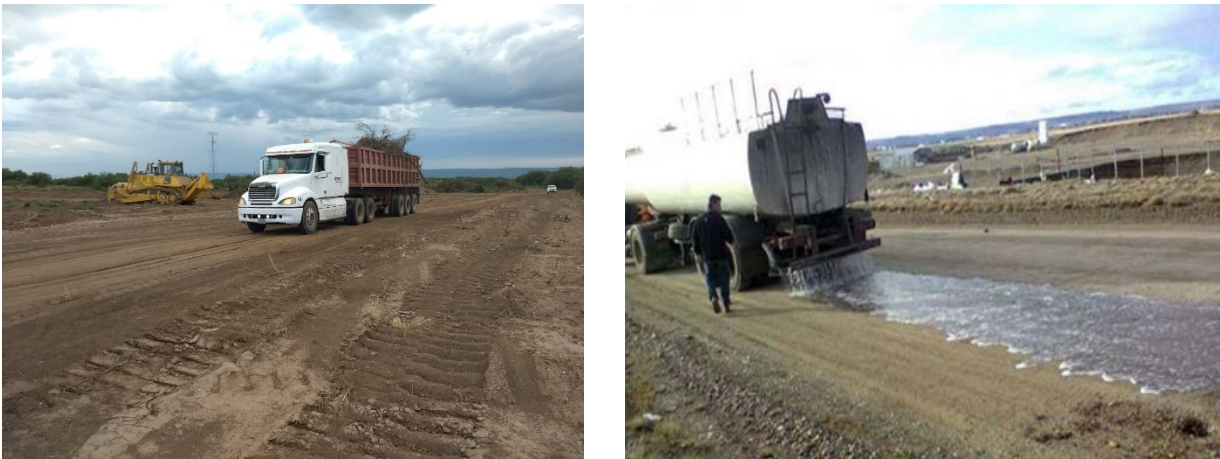
Figura II.22. Carpeta de rodado compuesta por dos capas. A la izquierda una sub base granular con CBR>50 y la derecha rodadura con una base estabilizadora de bischofita.
