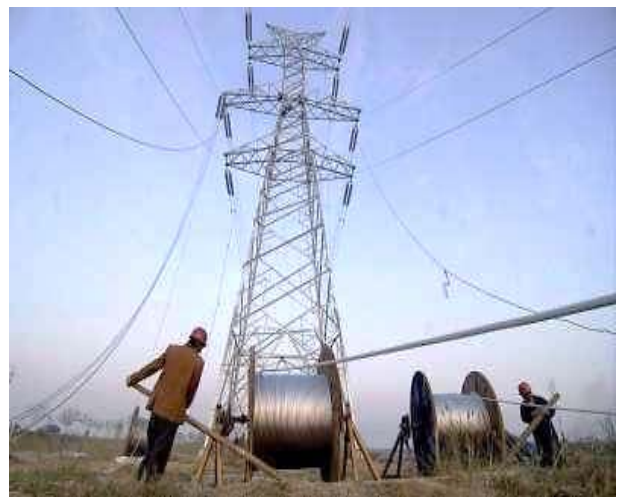
Figura II.37. Tendido de cable de guarda para las torres de interconexión de alta tensión.
