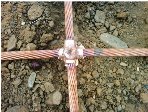
Figura II.31. Instalación de cable desnudo de cobre (35 mm 2 ) para sistema de tierras.
