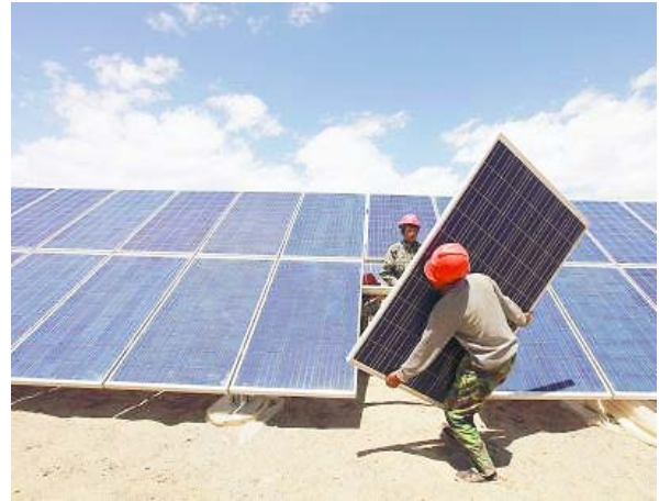
Figura II.30. Seguidores y montaje de paneles fotovoltaicos.
