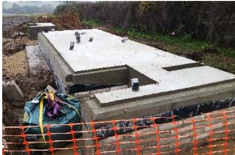
Figura II.12. Ejemplo de cimentaciones para las estaciones de potencia.
