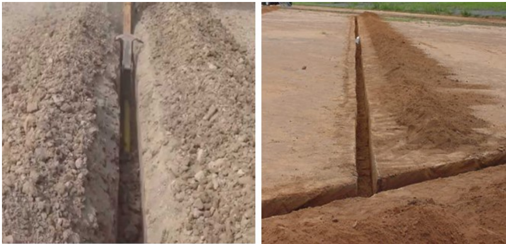
Figura II.19. Zanjas para el sistema de drenaje.
