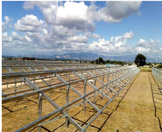
Figura II. 20. Secuencia del hincado de los postes y colocación de los seguidores.
