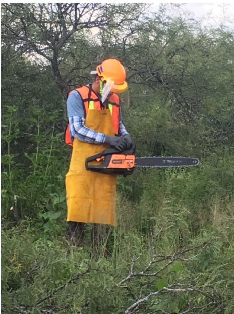
Figura II.16. Remoción de vegetación con equipo mecánico y uso de equipo de protección personal (EPP).
