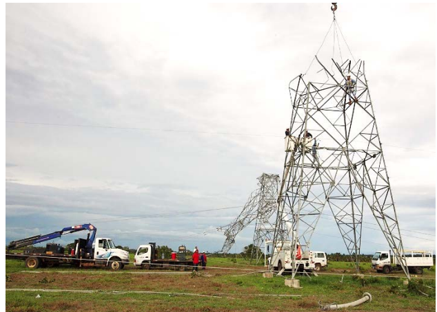
Figura II.36. Montaje y armado de la torre E71A21 de alta tensión.
