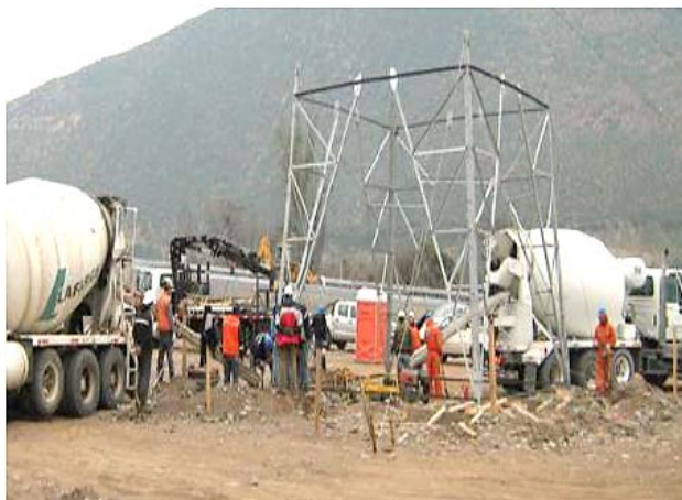
Figura II.36. Montaje y armado de la torre E71A21 de alta tensión.
