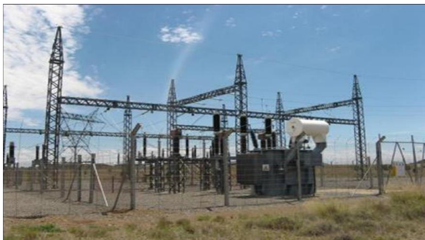
Figura. Subestación elevación 34.5/ 230kV
