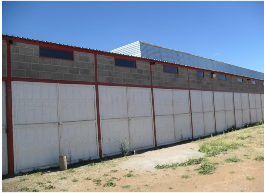
Figura 20.- LIMPIEZA DEL ÁREA
