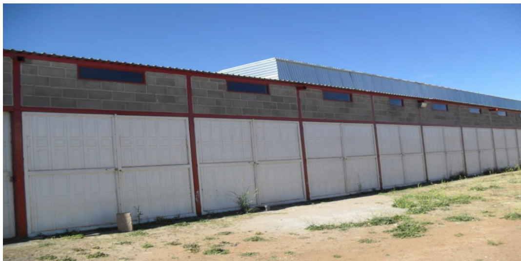
Figura 26.- ESPACIO QUE SERÁ REFORZADO
