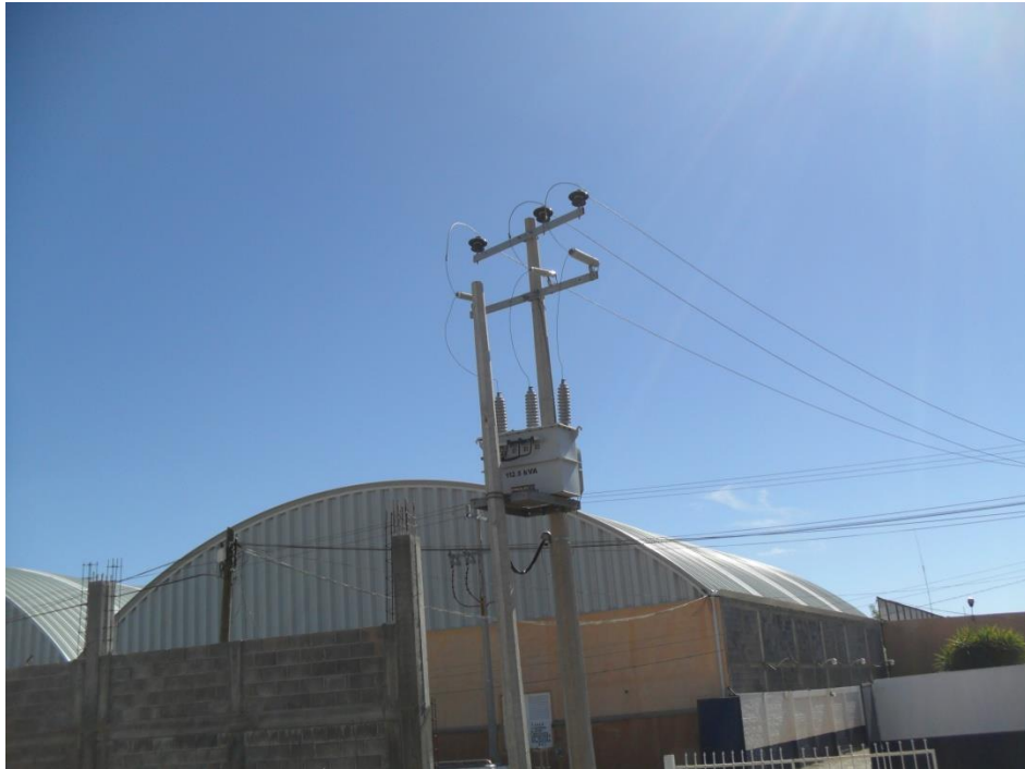
Figura 21.- VERIFICACIÓN DE INSTALACIONES
