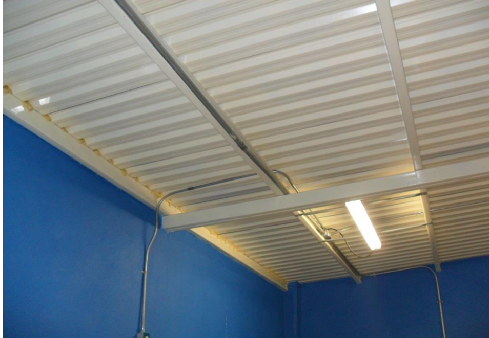
Figura 28.- PLAFONES Y TECHOS CON ESTRUCTURA METÁLICA
