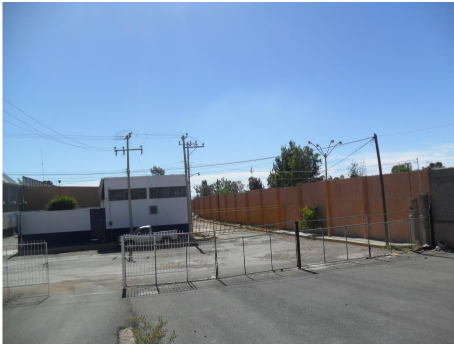
Figura 23.- OBRAS PROVISIONALES (CALLES, ENERGÍA ELÉCTRICA, CERCADO DE ÁREAS, ETC)
