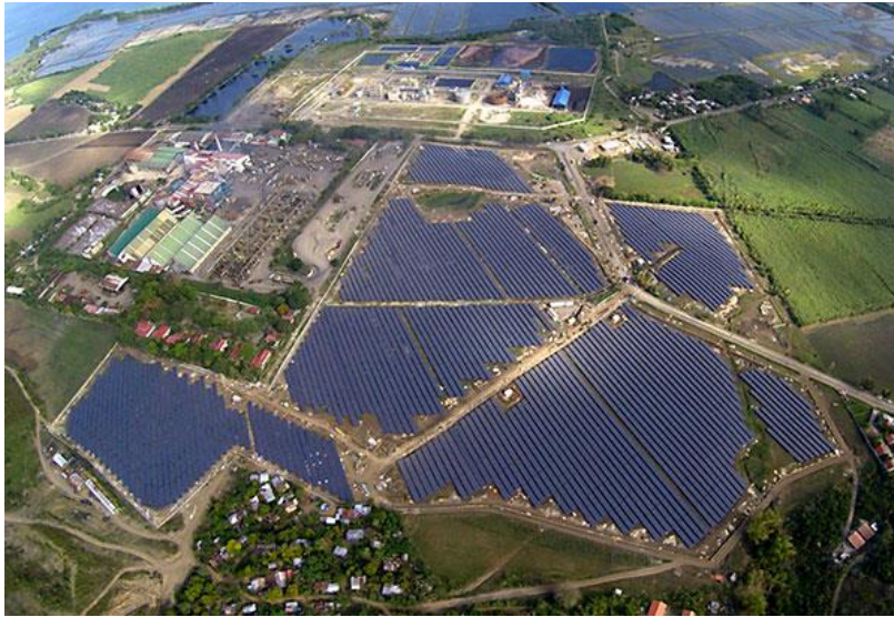
Figura. 49. Ejemplo de la condición del paisaje circundante de un parque fotovoltaico en operación. Note la inclusión en una matriz agropecuaria. Negros Oriental, Filipinas.
