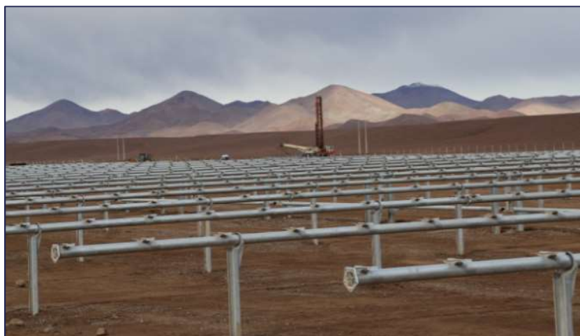
Figura II.6. Instalación de tubos de rotación
