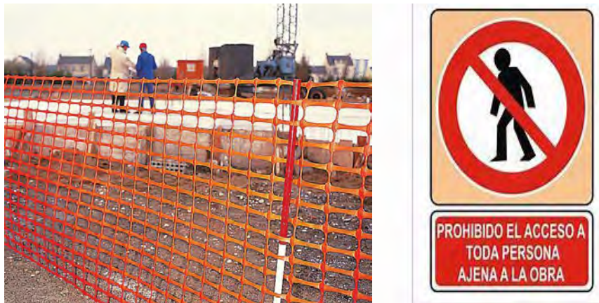
Figura 2. Ejemplo de delimitación de obra
