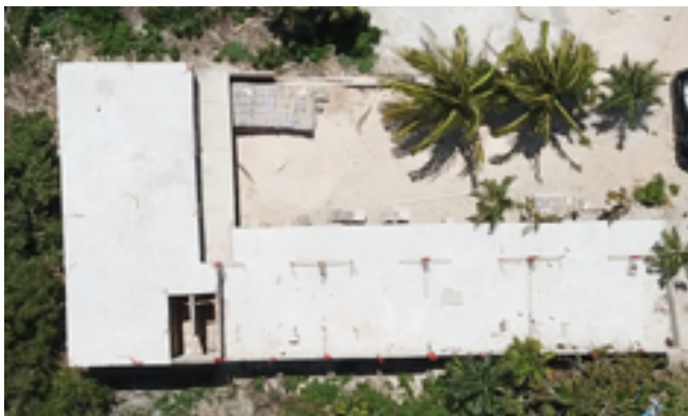
Foto 1 Cap IV. Vista aérea del predio donde se desarrolla el proyecto.
