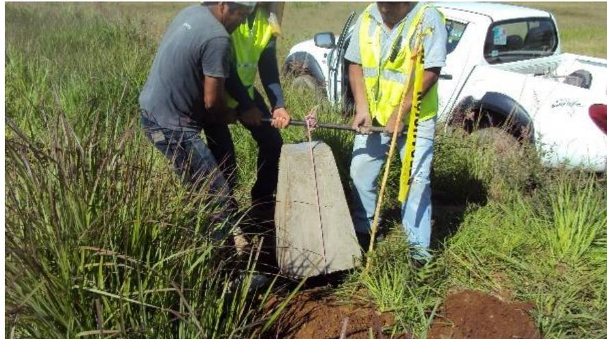
Figura II.13. Ejemplificación de las mojoneras que suelen ser empleadas para la lotificación.
