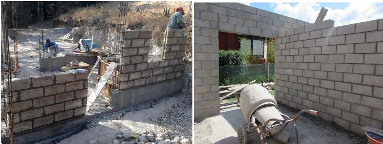
Figura II.16. Ejemplificación del levantamiento del muro.
