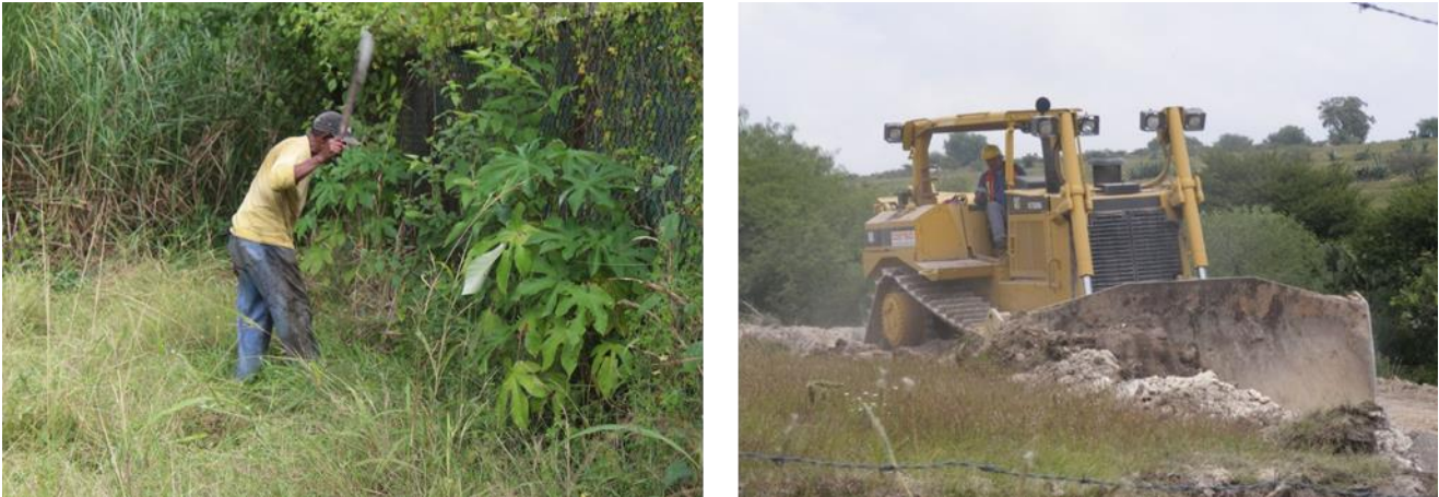
Figura II. 13. Actividades de desmonte y despalme.
